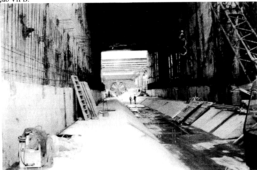
FOTO 4 - Secção VII e Estação Chelas (vista geral)
