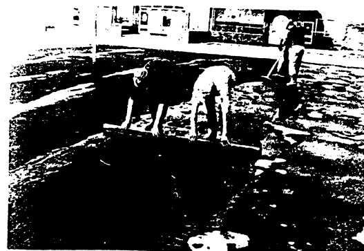
FOTO 2 - Regularização da superfície.
