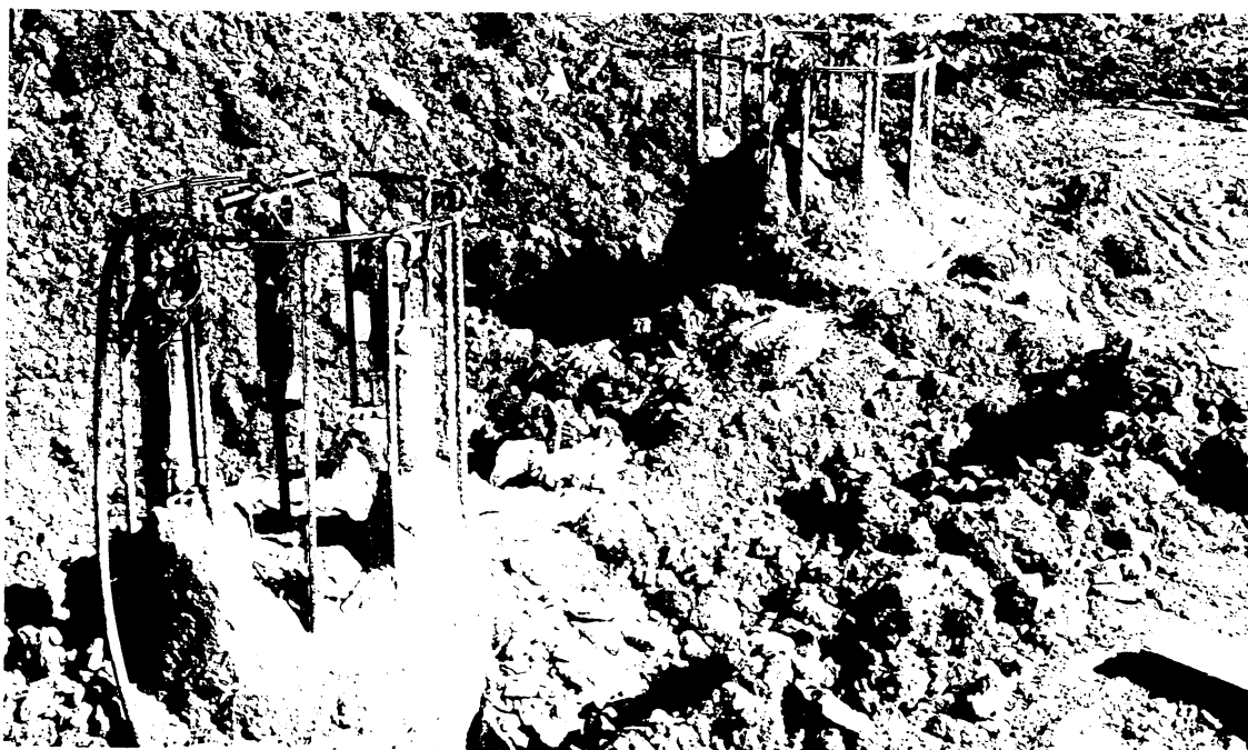
Fig. 5 - Aspecto das estacas instrumentadas após a betonagem.
