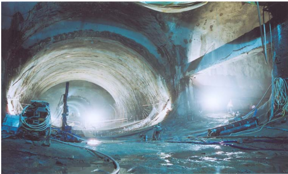
Figura 6 - Aspecto geral da zona de intersecção após conclusão da escavação
