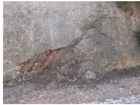
Figura 9 – Ligação direta (através da argamassa) entre o maciço conglomerático e a fundação da muralha (à esquerda).
