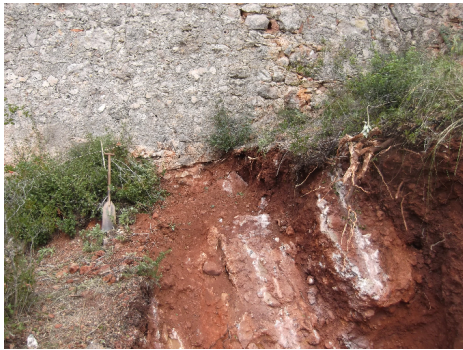
Figura 9 – Ligação direta (através da argamassa) entre o maciço conglomerático e a fundação da muralha (à esquerda).
