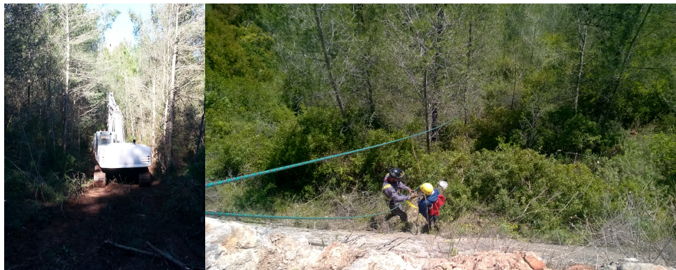
Figura 2 – Criação de acessos com giratória. Figura 3 – Descida em rapel junto à muralha do Caminho de Ronda (CR)
