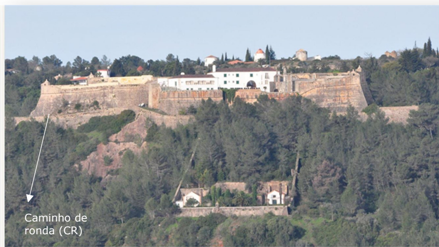
Figura 1 – Fotografia atual do Forte de Setúbal, encosta Sudeste (estabilizada em 1983)
