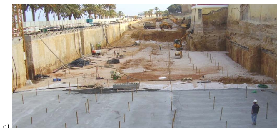
Figura 6 – Aspecto Geral da Obra nas várias Fases de Execução: a) Escavação até à Profundidade de 6 m; b) Pormenor da Parede de CSM; c) Regularização do Fundo de Escavação e Aplicação do Betão de Limpeza
