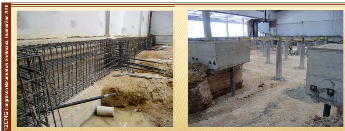
Figura 4 – Vista das vigas de recalçamento das sapatas interiores da estrutura metálica existente
