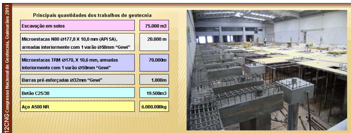
Figura 11 – Principais quantidades e vista geral do andamento dos trabalhos, colocação de cofragens para betonagem da laje
