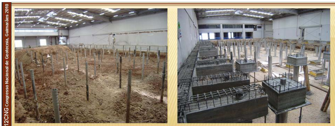
Figura 7 – Vista dos trabalhos de escavação dos materiais de aterro e inícios da betonagem dos maciços e vigas de recalçamento
