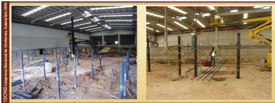
Figura 6 – Vista do equipamento de cravação das microestacas e da colocação do varão Ø50mm
