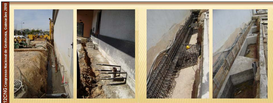
Figura 5 – Vista da sequência de execução das vigas de recalçamento das sapatas exteriores
