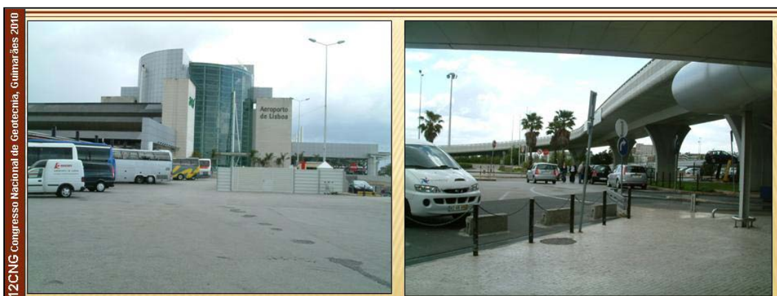
Figura 7 – Vistas Gerais da Zona de Implantação da Estação do Aeroporto, Antes do Início dos Trabalhos
