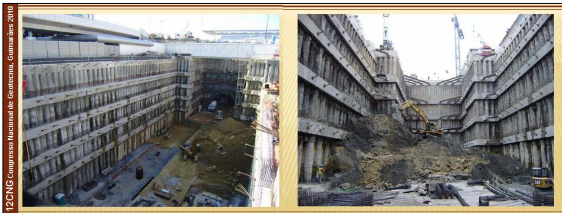
Figura 15 – Vistas das Escavações das Estações de Aeroporto (à esquerda) e de Moscavide (à direita)
