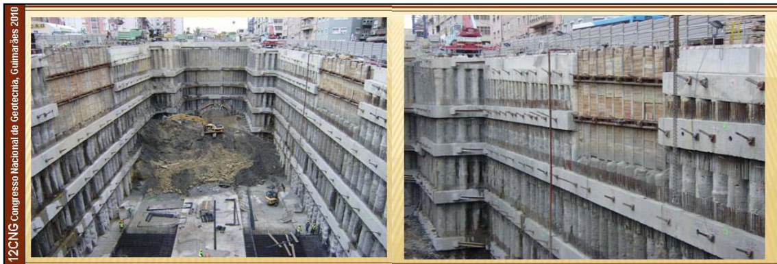
Figura 8 – Vista Geral e Pormenor da Parede de Contenção da Estação de Moscavide
