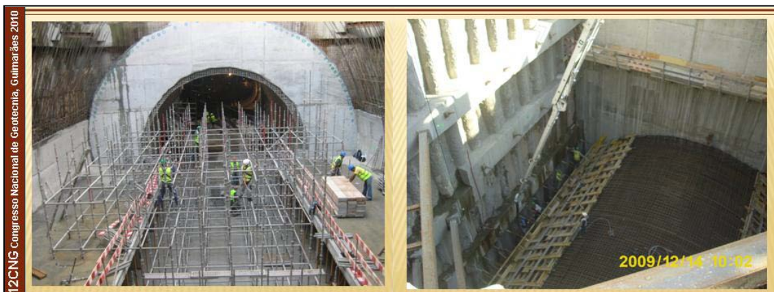
Figura 10 – Vista da Zona dos Falsos Túneis Executados nos Topos das Estações
