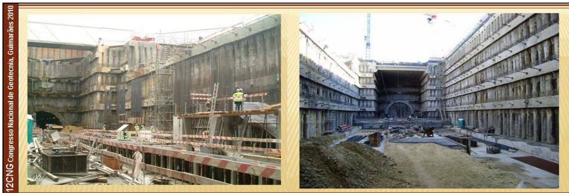
Figura 9 – Vista Geral da Parede de Contenção da Estação do Aeroporto
