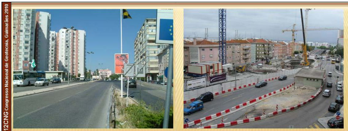
Figura 5 – Vistas Gerais da Zona de Implantação da Estação de Moscavide, Antes e Depois do Início dos Trabalhos
