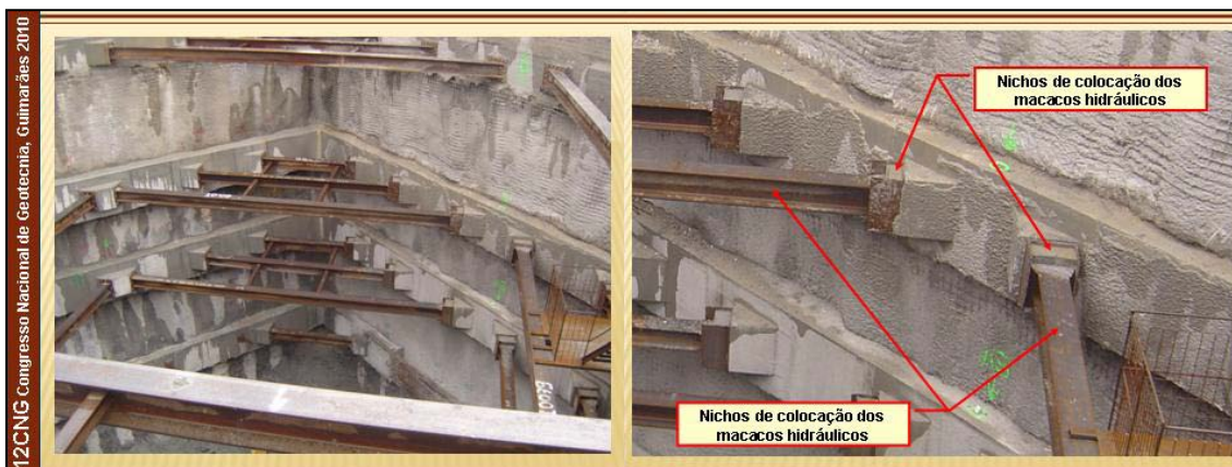
Figura 11 – Vista Geral da Escavação do PA1 e Pormenor dos Nichos de Aplicação do Pré-Esforço
