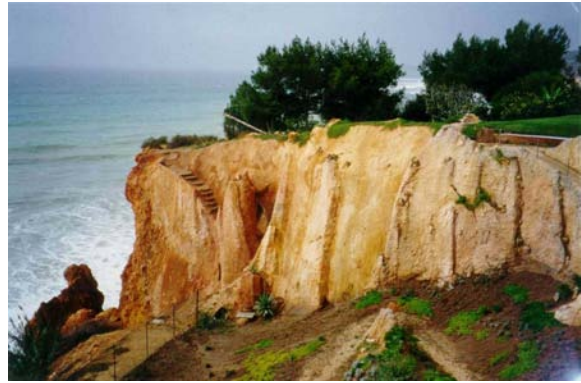
Figura 8 – Integração paisagística. Vista do talude lateral ponte
