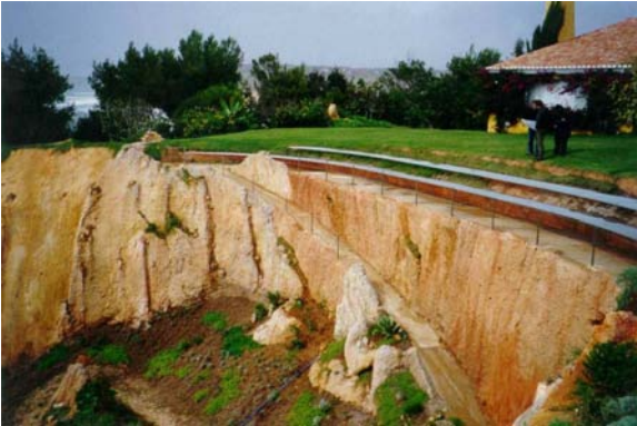
Figura 7 – Integração paisagística. Vista do talude central
