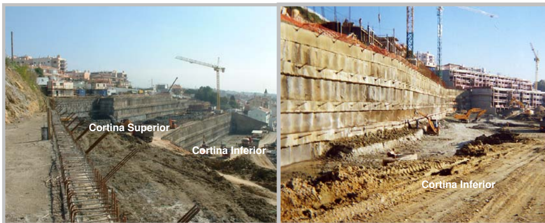
Figura 5 - Vistas das cortinas superior e inferior realizadas.
