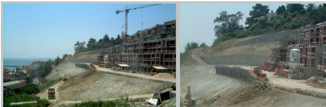
Figura 8 - Vista do reperfilamento e muros de estabilização da encosta.
