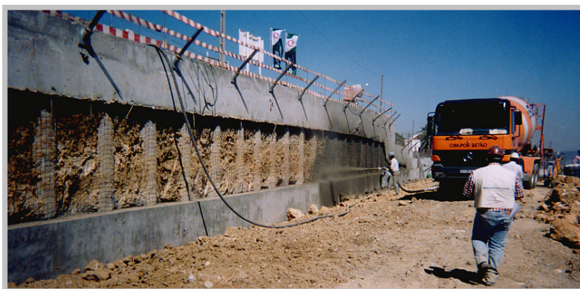
Figura 6 - Vista da fase de projecção de betão por via húmida.
