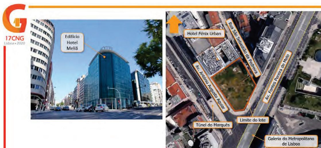
Figura 1 – Simulação do futuro edifício (Atelier de Arquitetura João Paciência) e vista aérea do recinto da escavação (Google Earth)
