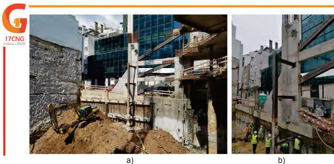
Figura 6 – Adaptações da solução em fase de obra - alçado Nascente (a) e pormenor do pórtico de travamento (b)
