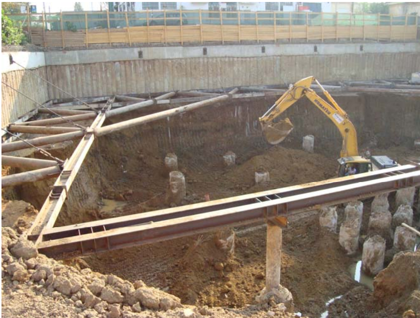
Figura 3 – Trabalhos a decorrer no projecto Nusco Tower
