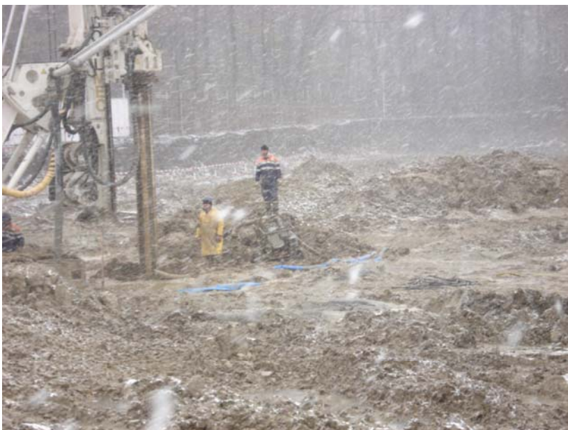
Figura 2 – Execução dos trabalhos em condições climáticas adversas
