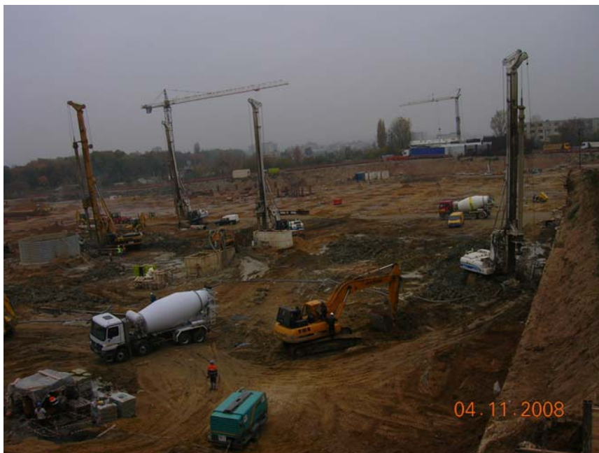
Figura 7 – Trabalhos a decorrer no projecto Craiova Mall
