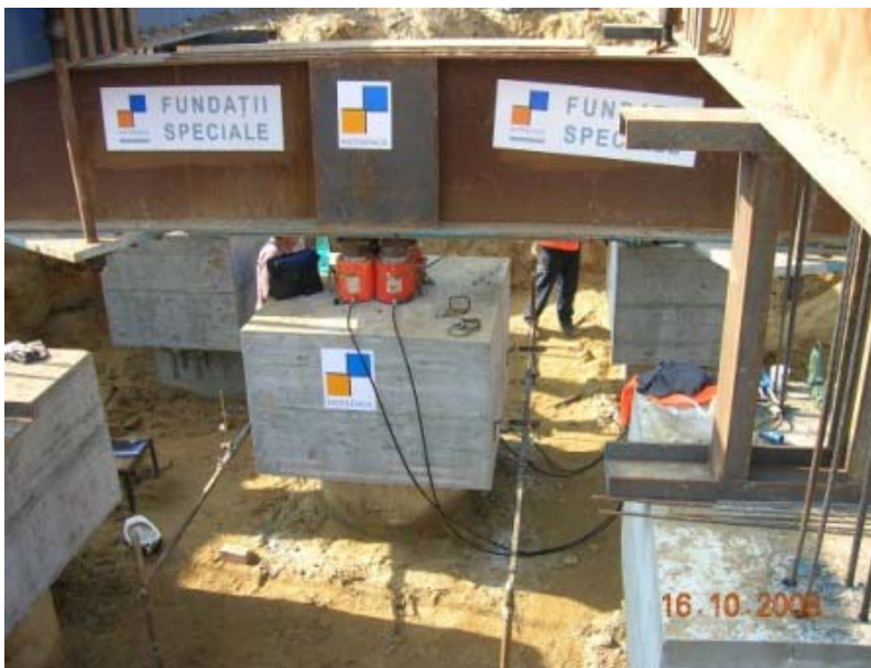
Figura 9 – Ensaio de carga estático realizado em obra
