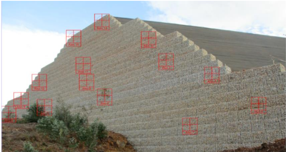
Figura 14 – Hitos de control en cara vista Muro Gaviones Reforzados
