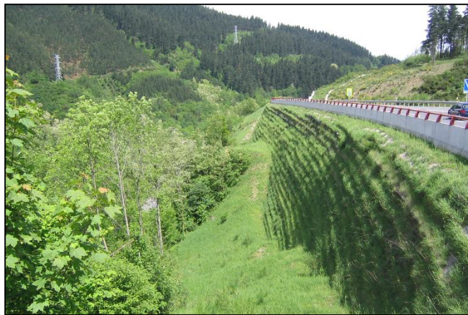
Figura 1 - Muro vegetalizado en el puerto de Etxegarate, totalmente integrado en el paisaje
