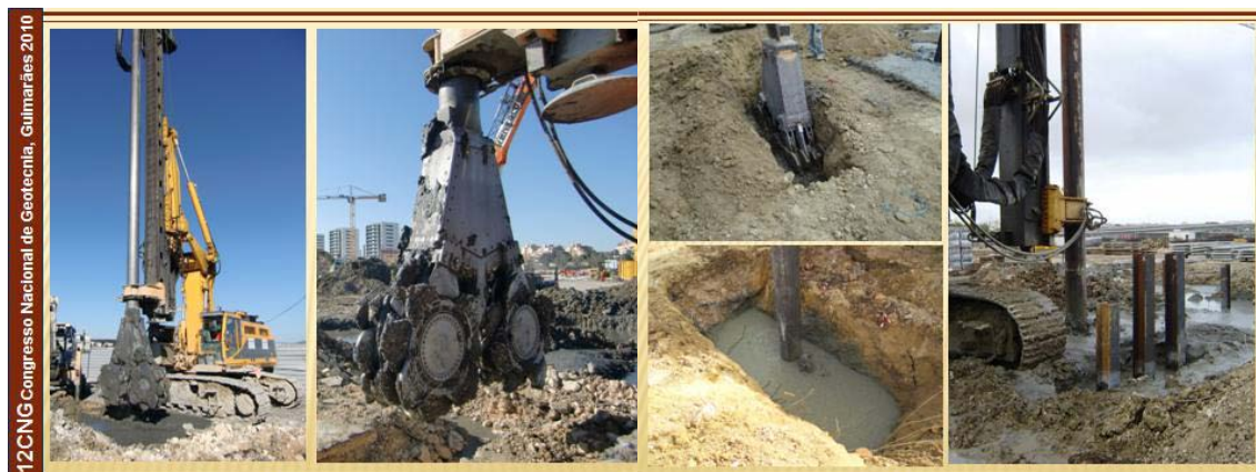
Figura 6 - Equipamento e Execução de Painéis de CSM
