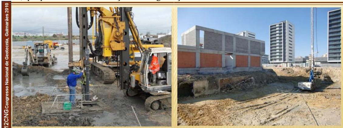
Figura 12 - Execução das Microestacas Cravadas e das Colunas de Jet Grouting
