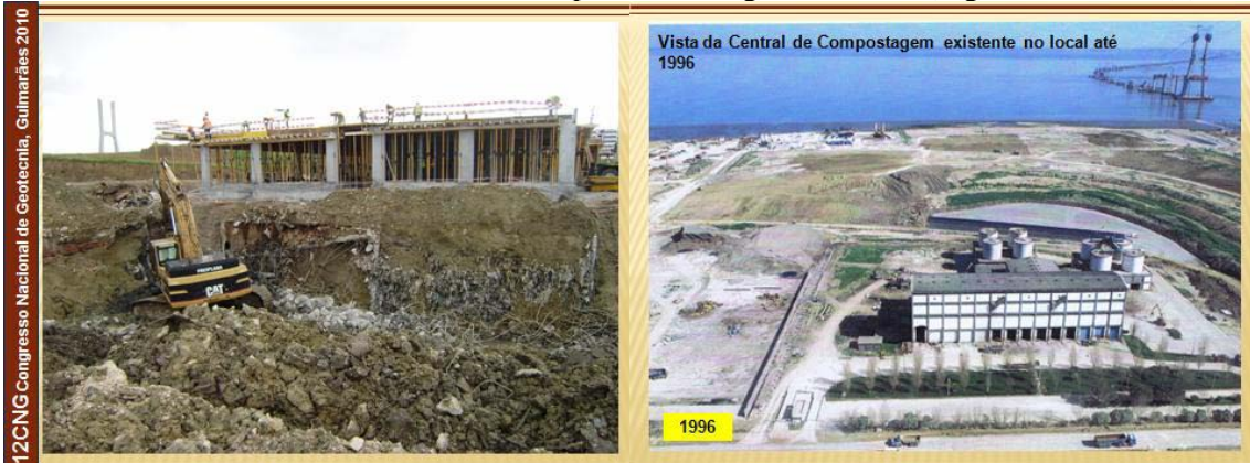
Figura 10 - Escavação e Demolição das Estruturas Enterradas e Vista da Central de Compostagem (1996)
