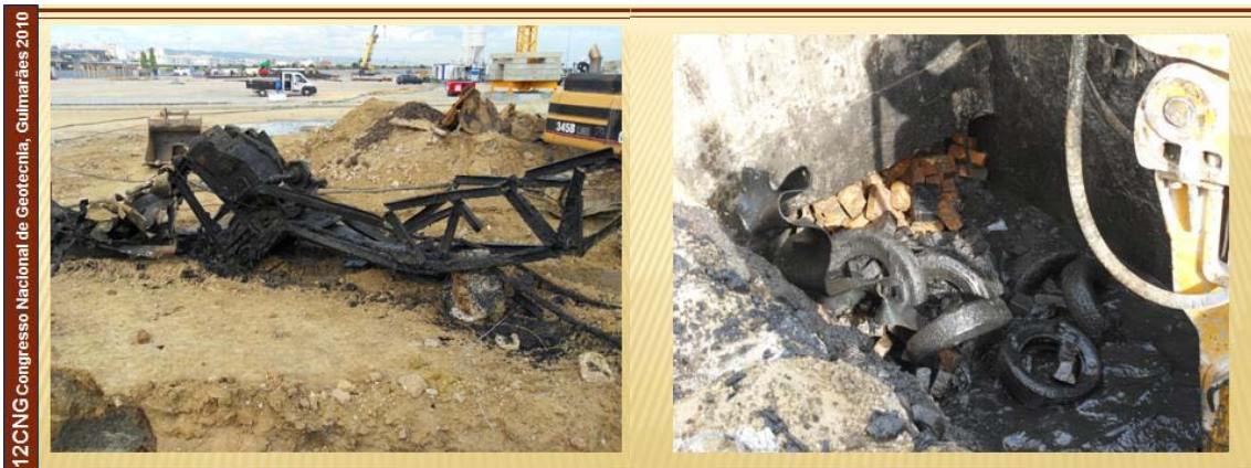
Figura 11 - Evidências de Entulho Diversificado no Interior das Estruturas Enterradas.
