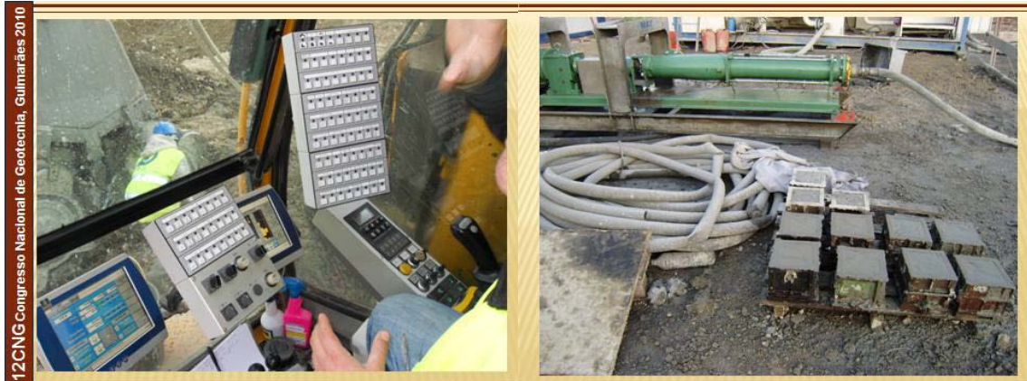
Figura 7 - Painel de Aparelhos para Controlo de Execução e Provetes para Ensaios de Compressão Uniaxial, Não Confinada, com Medição de Módulo de Deformabilidade
