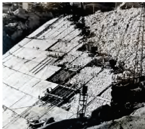
Figura 3 – Cortina estanque em betão sobre o enrocamento arrumado (agosto de 1957)
