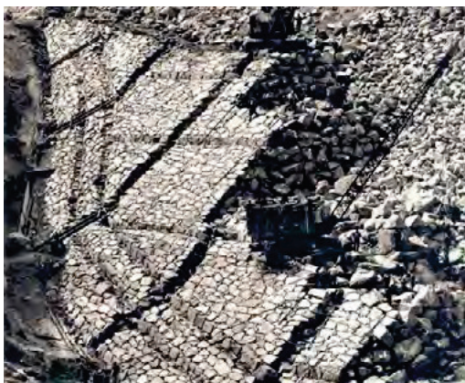
Figura 2 – Almofada de enrocamento arrumado (junho de 1956)
