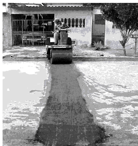
Figura 7. Camada final de rolamento CBUQ.
