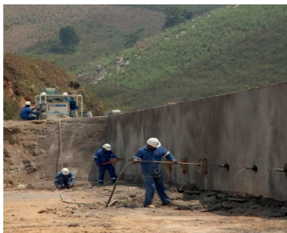
Figura 16. Inyección repetitiva selectiva en anclajes.
