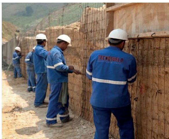
Figura 19. Colocación de malla para gunitado.
