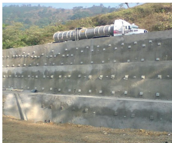
Figura 3. Carretera Pachuca – Tuxpan, km 105+200. Solución con Estatec en 3 niveles.
