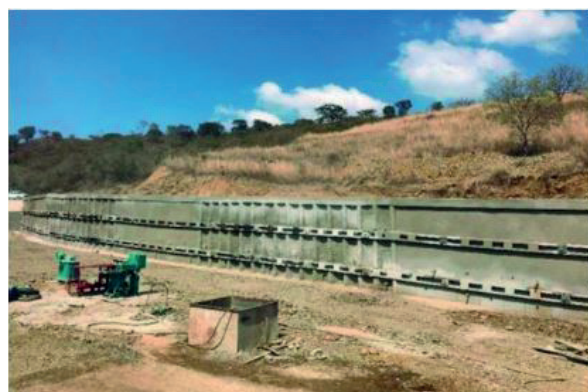
Figura 12. Cortina de micropilotes junto al Sistema Estatec. Carretera Villahermosa – Escopetazo. Chiapas.
