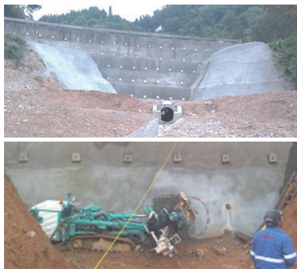
Figura 11. Combinación Sistema Estatec y microtúnel. Carretera Pachuca – Tuxpan Km 102+200. Puebla
