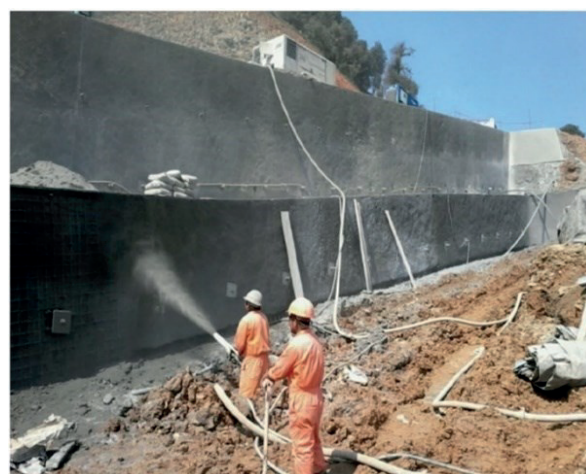
Figura 15. Gunitado en paramento del muro plástico.
