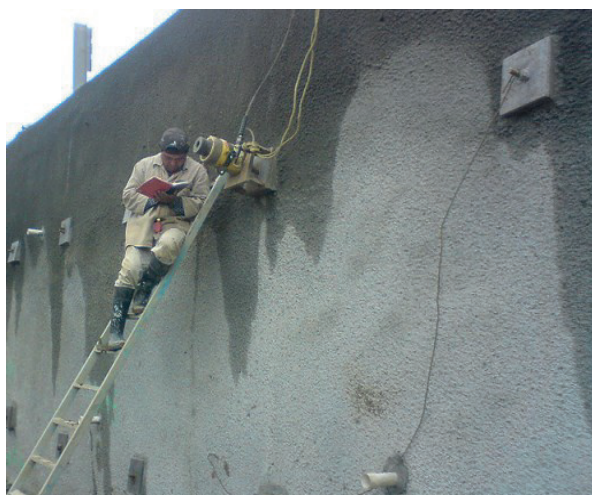
Figura 17. Tesado de anclajes de barra. Carretera Pachuca – Tuxpan. Km 111+300. Puebla.
