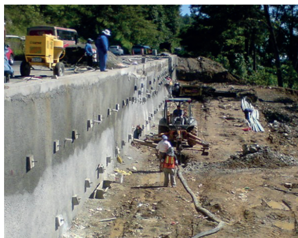
Figura 13. Ejecución de muro de bentonita cemento, con maquinaria ligera. Pachuca - Tuxpan, Km 105+200
