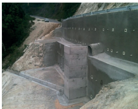
Figura 9. Estabilización con sistema en 2 terrazas y elementos de drenaje. Carretera Huixtla – Motozintla.
