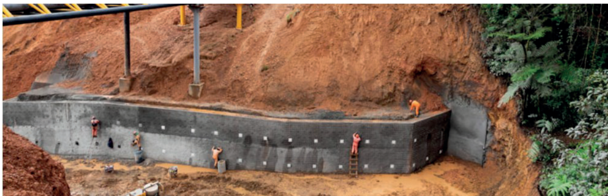
Figura 20. Estabilización y protección de cimentación de puente. Oleoducto Zoquital – Catalina Km 4+640. Puebla
