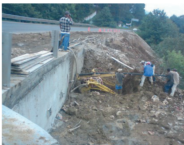
Figura 18. Instalación de drenes subhorizontales. Carretera de Necaxa. Km 95+350. Puebla.
