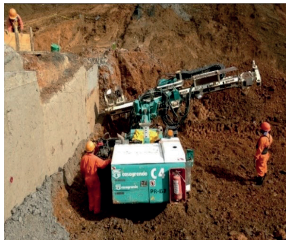
Figura 14. Perforación de anclajes. Oleoducto Zoquital – Catalina. Huachinango, Puebla
