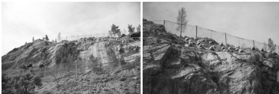
Figura 5 – Ancoragens de estabilização na zona onde foi identificada uma fenda.
