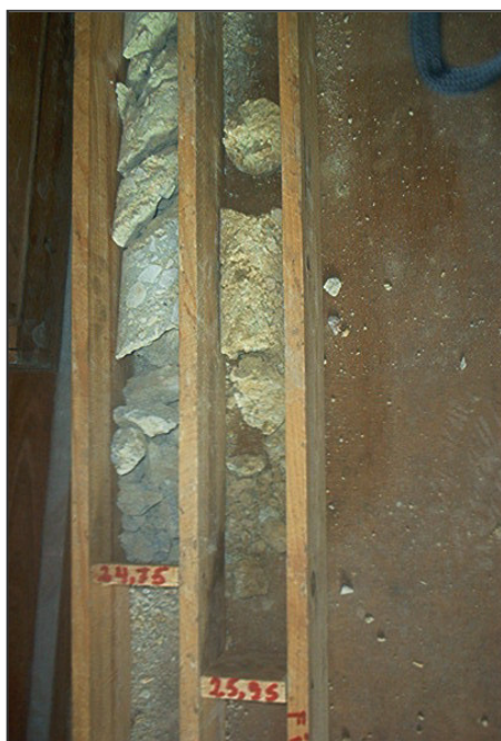
Figura 6 – Contaminação da estaca (ponta)
