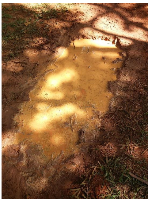
Figura 5 - Aspecto final da vala após procedimento de compactação
