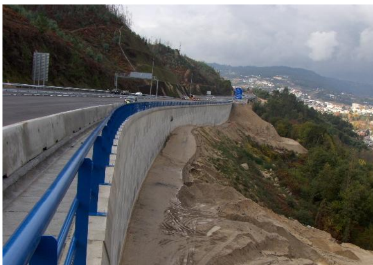
Figura 1 – Muro M4B da Auto-Estrada do Marão.
