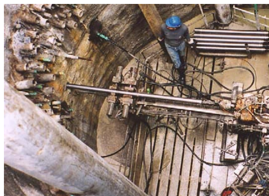
Figura VI – Execução dos trabalhos no interior do Poço n.1
