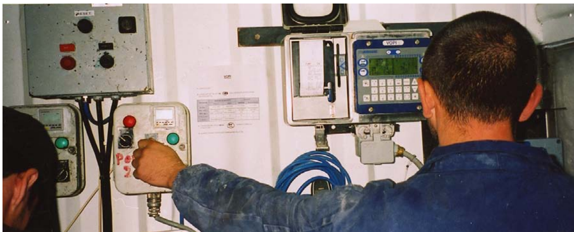
Figura VII –VOPI, sistema de controlo e registo contínuo dos parâmetros de injeção
