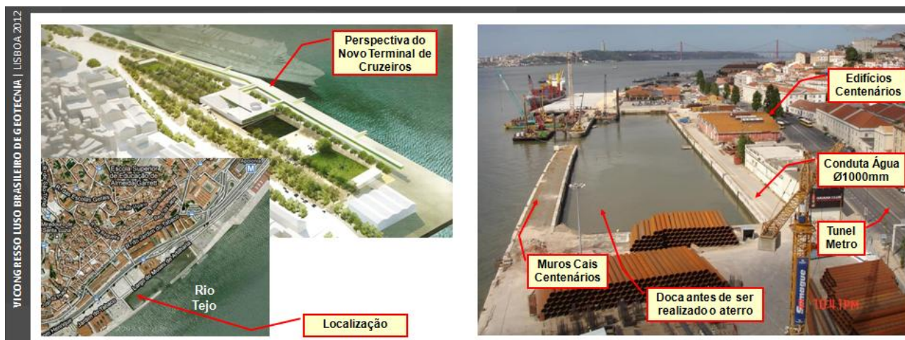
Figura 2 – Vista geral da zona da intervenção e das Condições de Vizinhança
