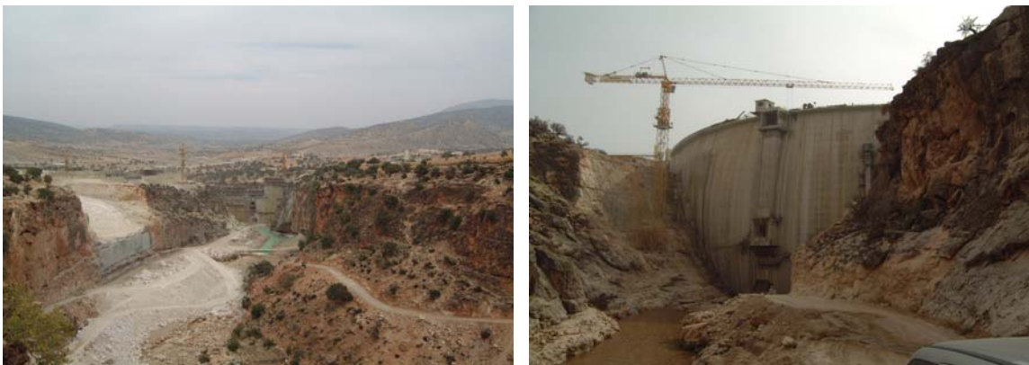
Figura 6 – vistas de jusante e montante – de notar a fracturação do maciço
