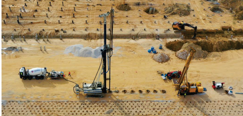
Figura 5 – Equipamentos utilizados na execução das CMM.
