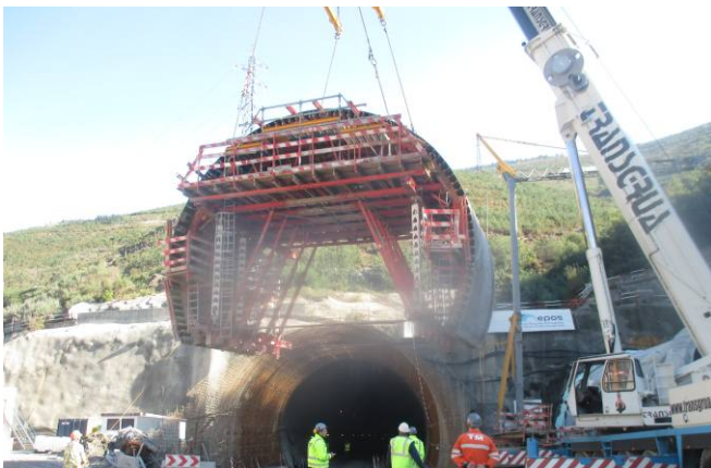
Foto 18 - Entalamento, esmagamento, corte, queimadura
