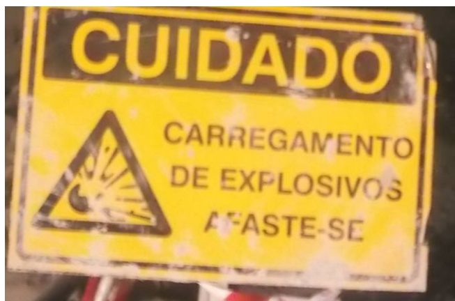
Foto 24 - Aplicação dos explosivos - Geral
