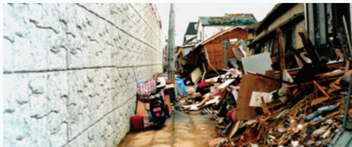
Fig.2 Muro reforçado inspecionado após o sismo de Kobe (Tatsuoka et al: S&F, 1996)
