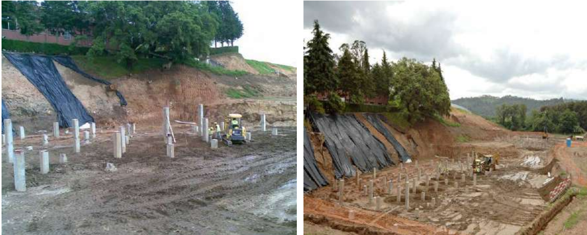
Figura 8 - Vistas da execução de Estacas Cravadas
