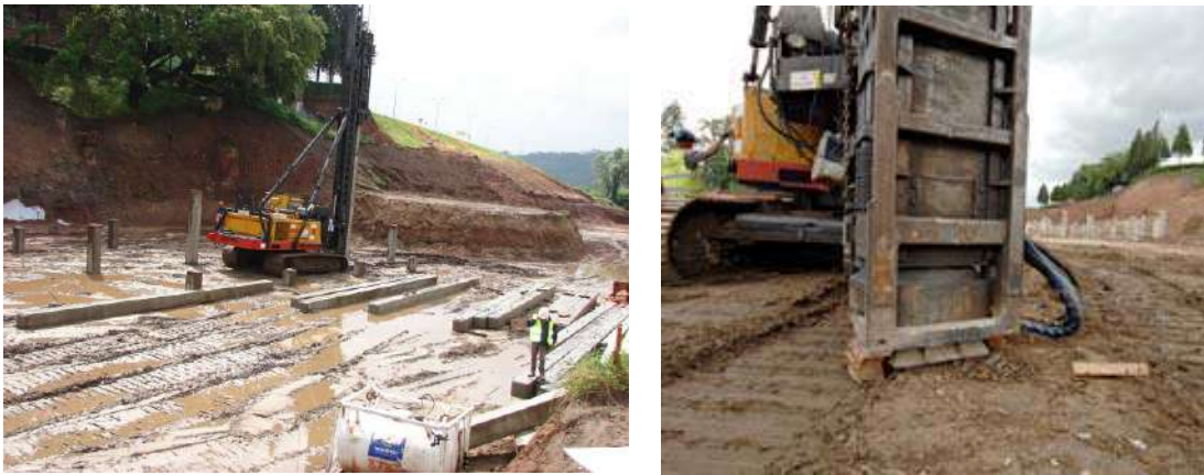
Figura 9 - Vistas do equipamento de cravação das estacas
