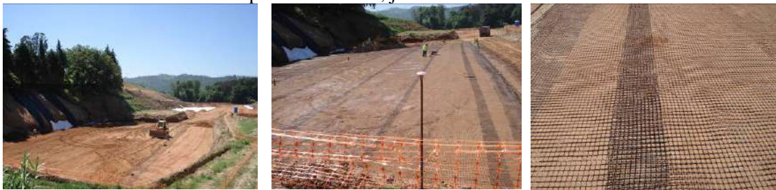
Figura 6 – Colocação das Geogrelhas Biaxiais
