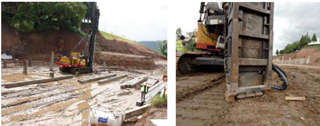
Figura 9 - Vistas do equipamento de cravação das estacas
