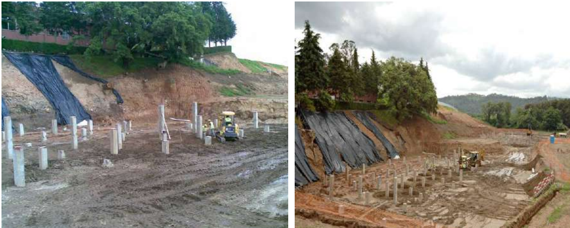
Figura 8 - Vistas da execução de Estacas Cravadas
