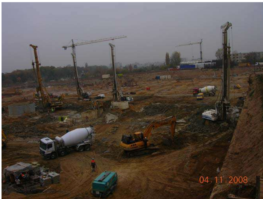
Figura 7 – Trabalhos a decorrer no projecto Craiova Mall
