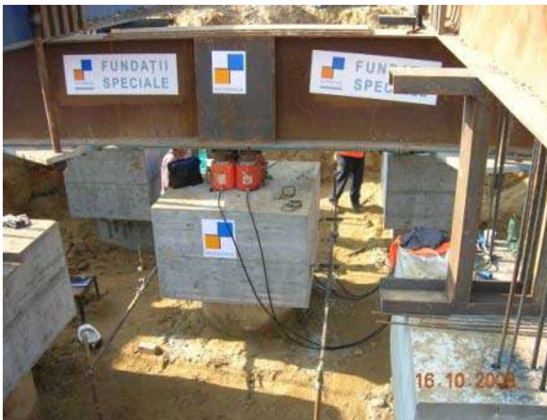
Figura 9 – Ensaio de carga estático realizado em obra
