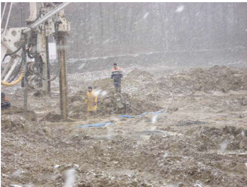
Figura 2 – Execução dos trabalhos em condições climáticas adversas
