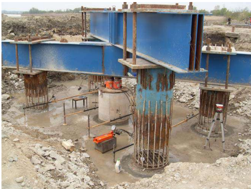
Figura 8 – Pormenor da ligação da estrutura metálica à cabeça das estacas a ensaiar
