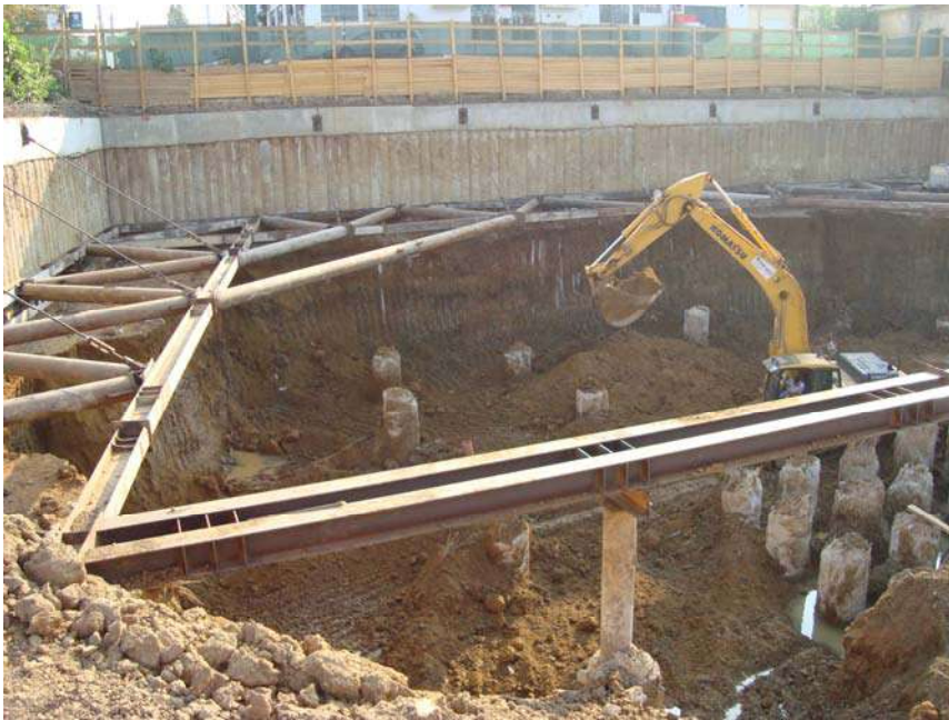
Figura 3 – Trabalhos a decorrer no projecto Nusco Tower
