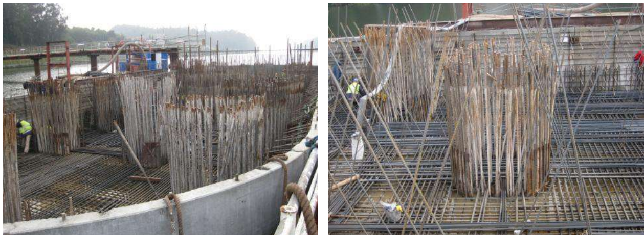
Figura 20 – Montagem das armaduras do maciço de encabeçamento das estacas
