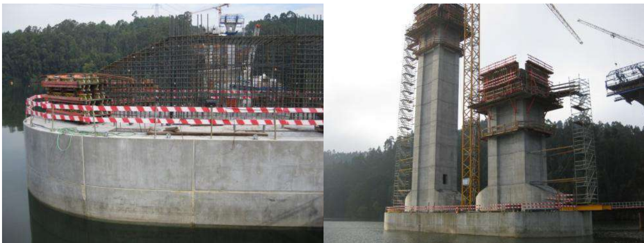
Figura 21 – Conclusão da betonagem do maciço e “arranque” dos pilares da ponte
