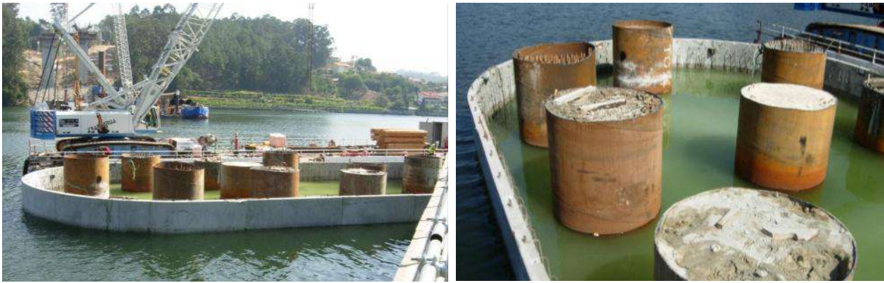
Figura 18- Imagens ilustrativas da conclusão dos trabalhos de posicionamento das peças primárias do cofre
