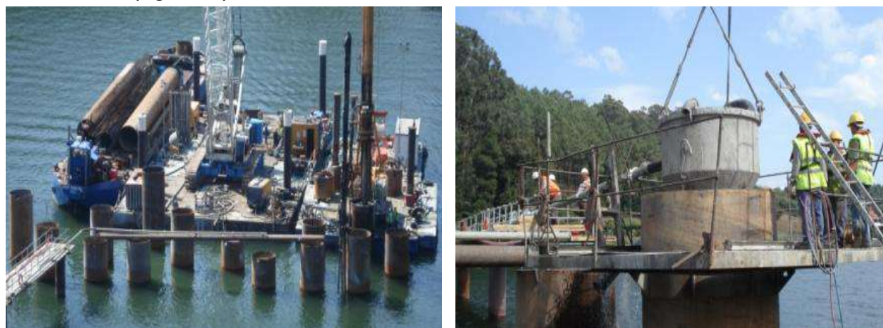
Figura 11 – Linhas de bombagem e colocação do betão com tubos tremie
