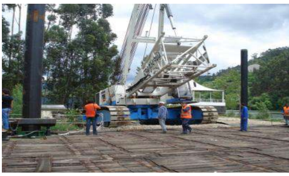
Figura 3 – Instalação da Grua no Pontão
