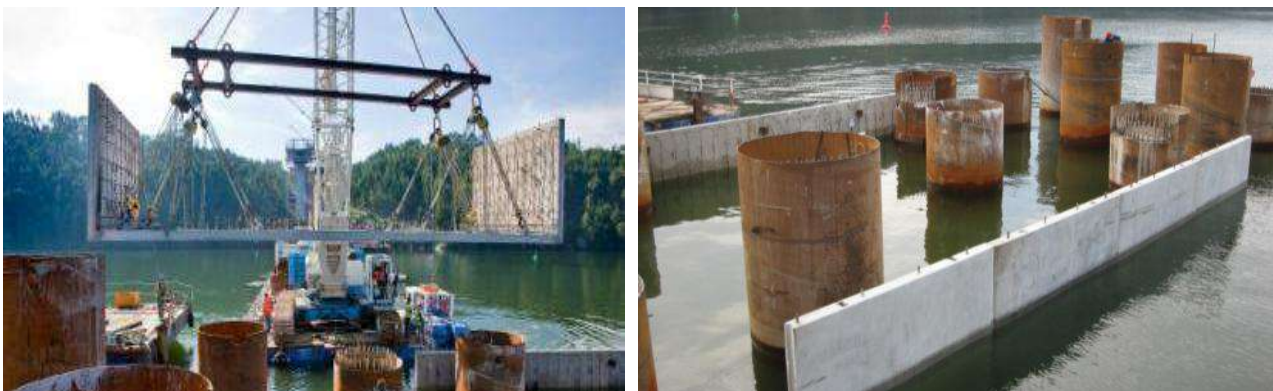
Figura 17- Sistema de suspensão e posicionamento sequencial das peças primárias, pré-fabricadas, do "cofre"
