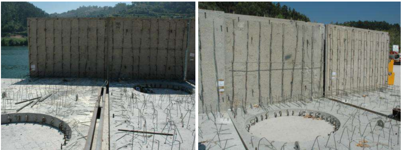
Figura 12- Imagem dos elementos pré-fabricados (primários) armazenados em estaleiro
