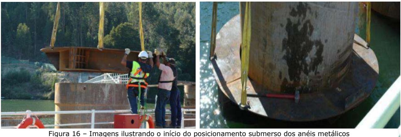
Figura 16 – Imagens ilustrando o início do posicionamento submerso dos anéis metálicos
