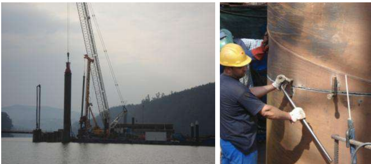
Figura 6 – Cravação e soldadura dos tubos
