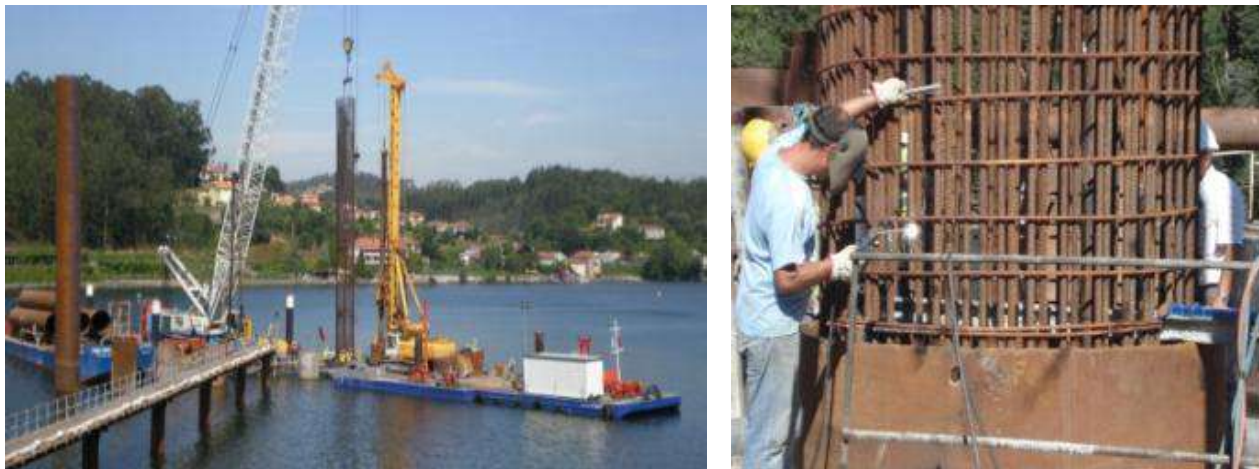
Figura 9 – Aplicação de um troço de armadura e pormenor dos empalmes
