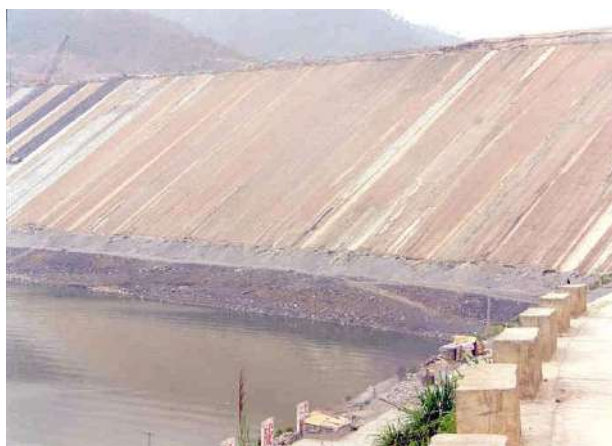
Figura 1- Vista geral da barragem de tsq 1.
