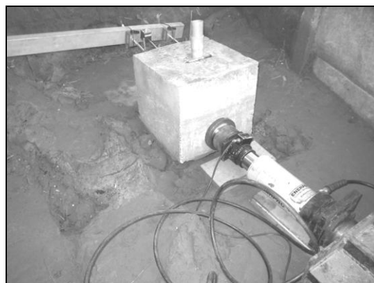
Figura 3 – Vista de uma prova de carga.
