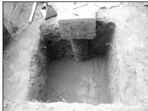
Figura 5 – Vista da abertura da vala.
