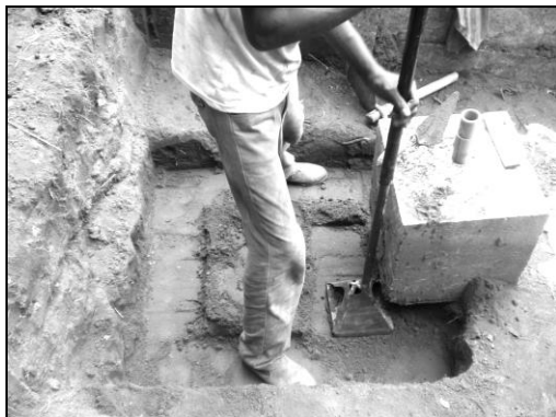
Figura 6 – Trabalhos de substituição do solo.
