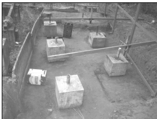
Figura 2 – Vista das estacas ensaiadas.
