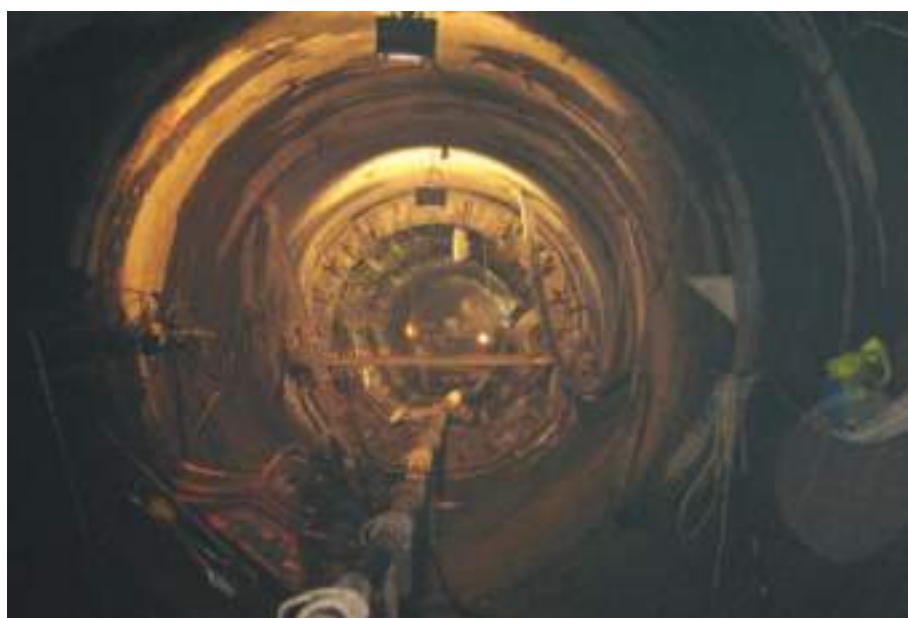
Aspectos do túnel, suporte primário e trabalhos de betoneamento com recurso a cofragem telescópica. Views of the tunnel, primary support and concreting using the telescopic formwork.
