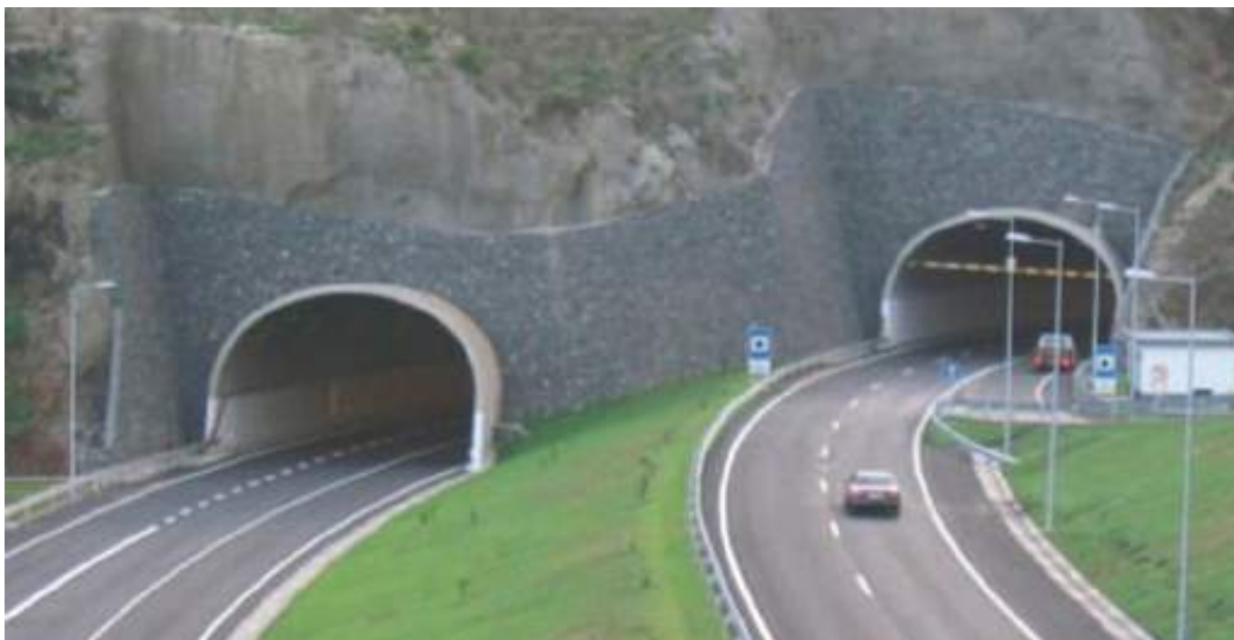
Fig. 03 Portal Este do túnel duplo do Caniçal, com três vias cada. Double Caniçal tunnel east portal with three lanes.
