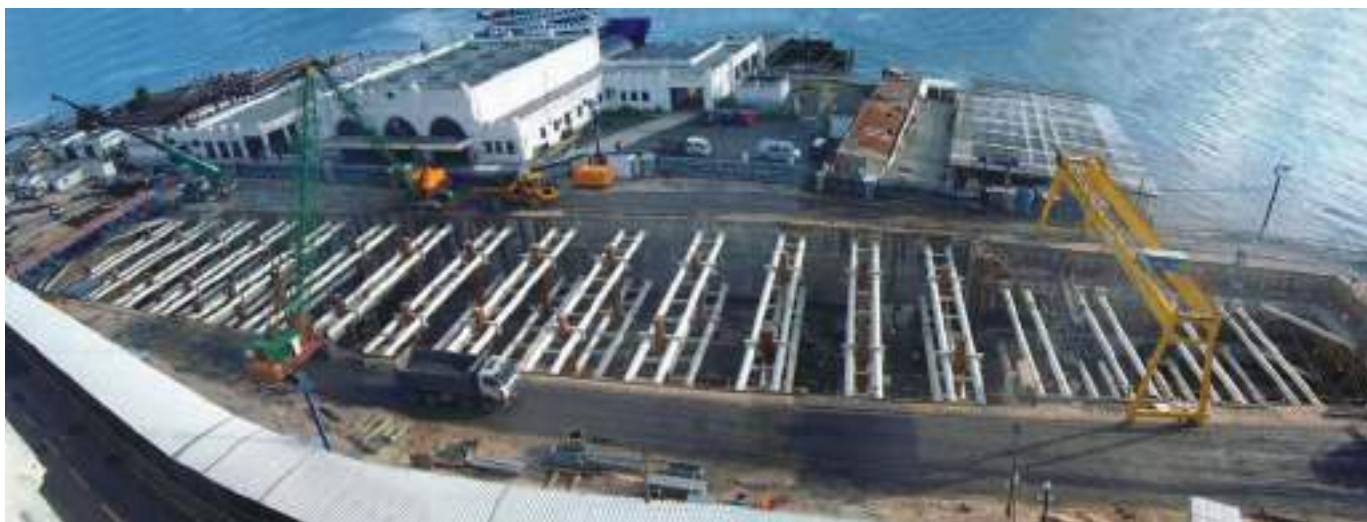
Fig. 03 Vista da contenção e do sistema de escoramento a partir do Torreão Nascente (do lado oposto está situado o edifício da Estação Fluvial). View of the retaining wall and of the shoring system from the eastern tower (the river ferry terminal building is located to the left).
