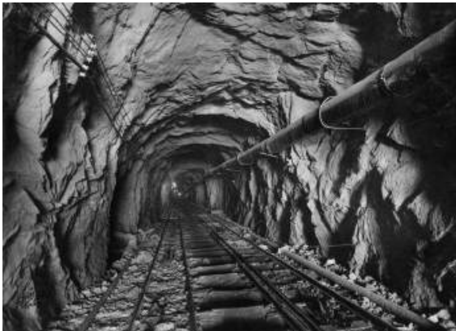
Fig. 07 Galeria de ataque à central (atualmente de ventilação e segurança). Powerhouse construction tunnel (now used for ventilation and safety).
