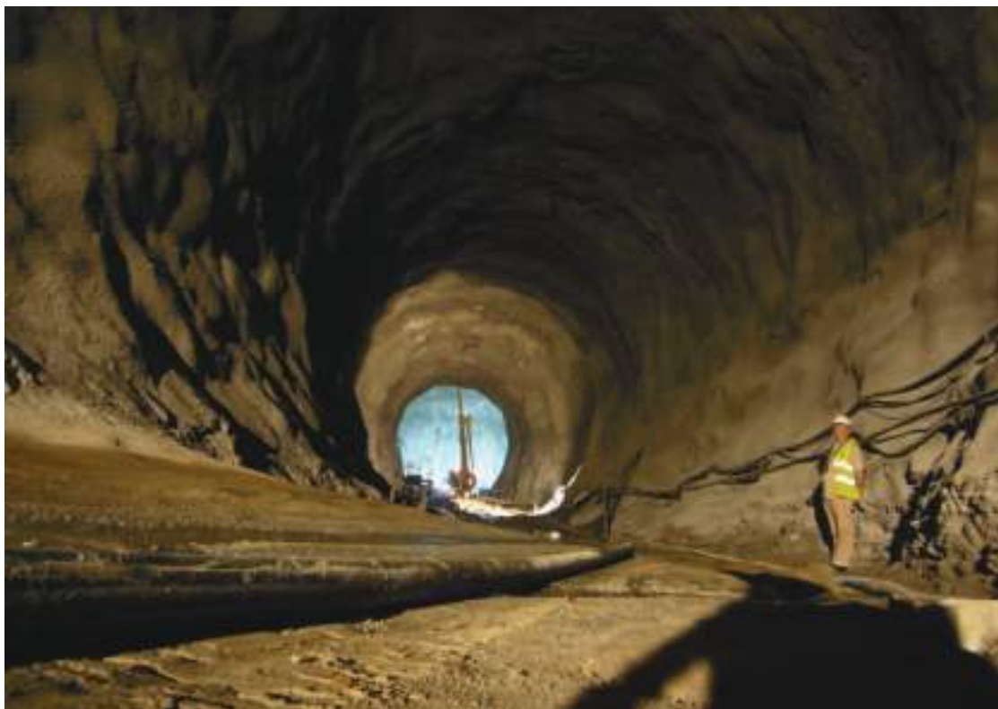
Fig. 07 Galeria em carga. Ao fundo a central. Headrace tunnel near the powerhouse.
