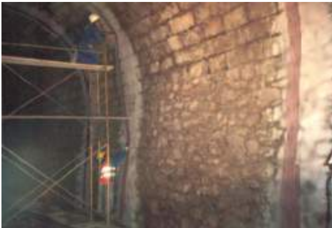
Drenagem, aspetos da colocação de drenos planos no contorno da estrutura. Drainage, aspects of setting up flat drains on the walls of the structure.
