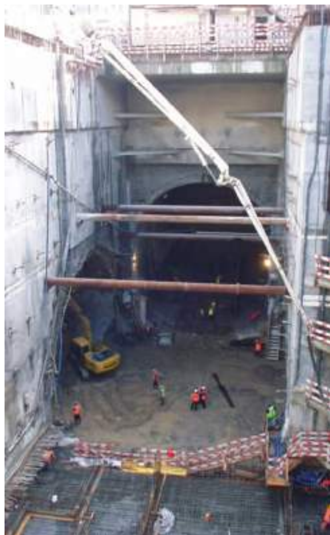
Fig. 03 Vista geral da estação na fase de abertura dos túneis. General view of the station at the tunnel opening stage.
