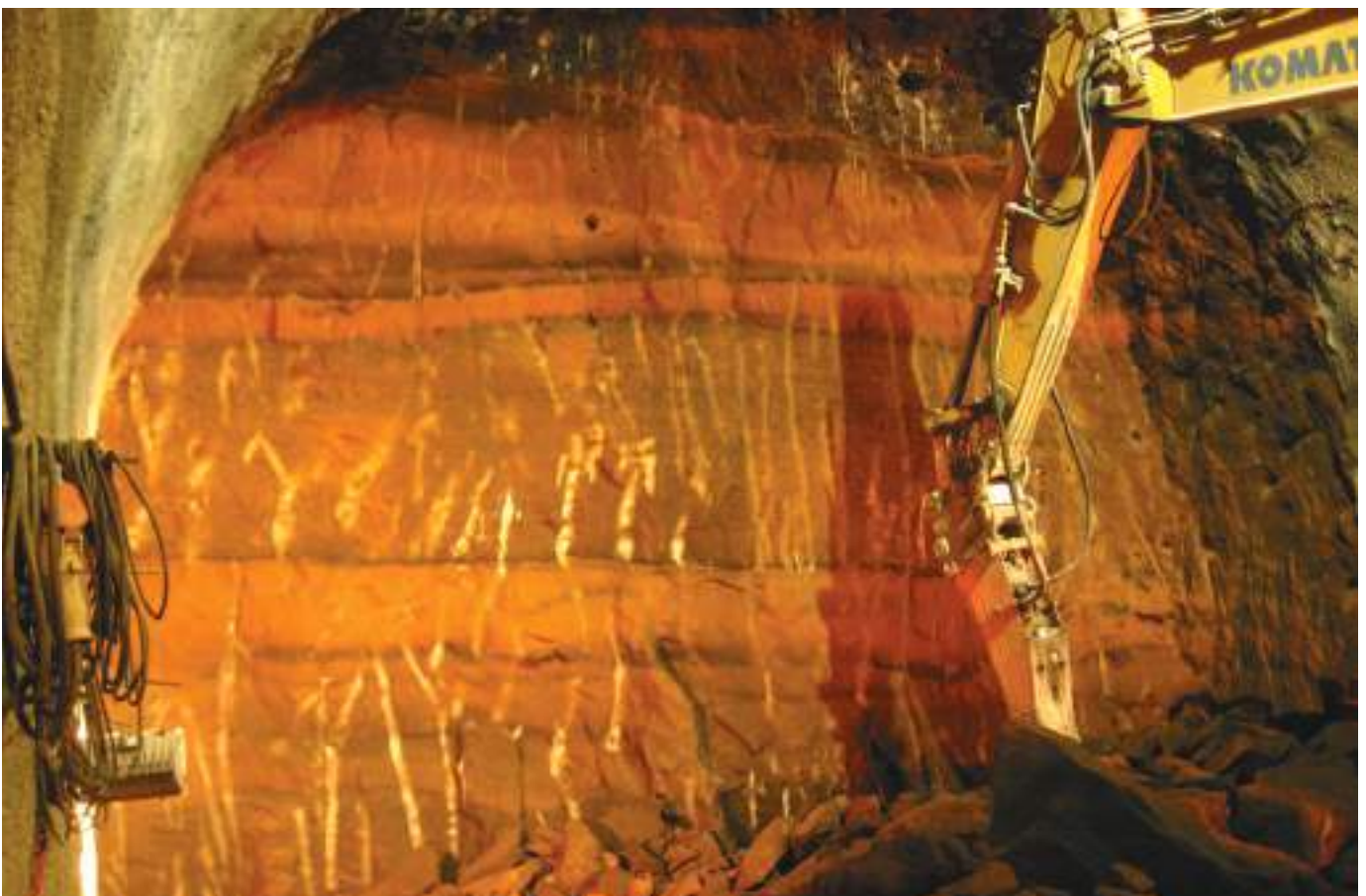
Frente de escavação em tubos vulcânicos. Excavation face in volcanic tuffs.
