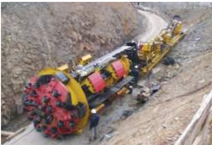
Fig. 02 Aspectos da tuneladora em montagem no emboquilhamento de montante e do comboio de apoio. TBM during assembly at the upstream portal, and the support train.
