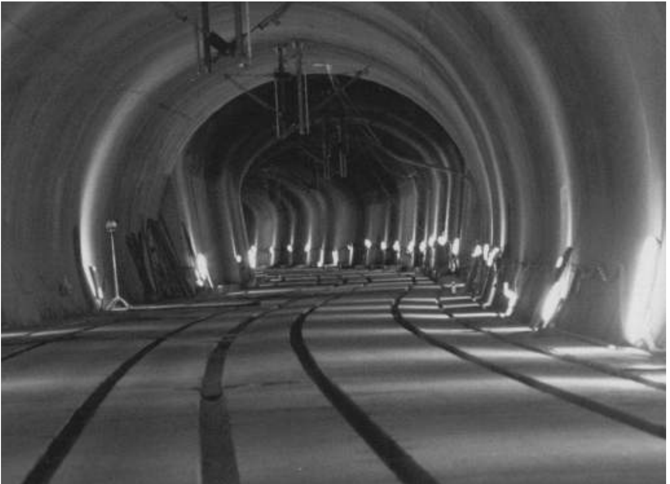
Túnel do Pragal – zona de transição entre seções. Pragal Tunnel – transition area between sections.
