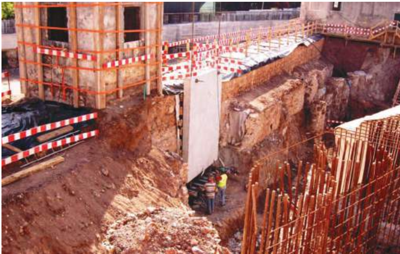
Fig. 11 Colocação de painel lateral em betão armado, pré-fabricado, observando-se já embainhadas as barras de suporte do aqueduto. Placement of a pre-cast reinforced concrete side panel, showing the already sheathed aqueduct support rods.
