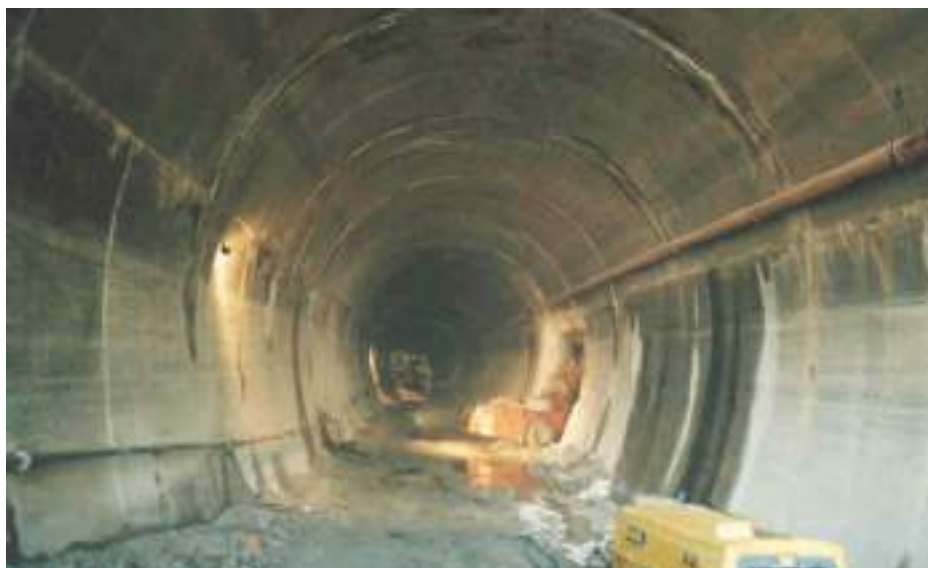
Fig. 07 Início das obras do reforço de potência na zona do túnel da descarga auxiliar. Works in the tailrace tunnel.
