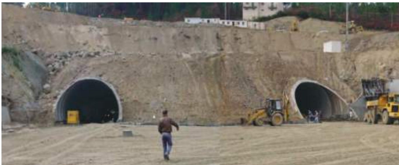
Fig. 03 Aspeto do emboquilhamento Norte. Northern portal view.
