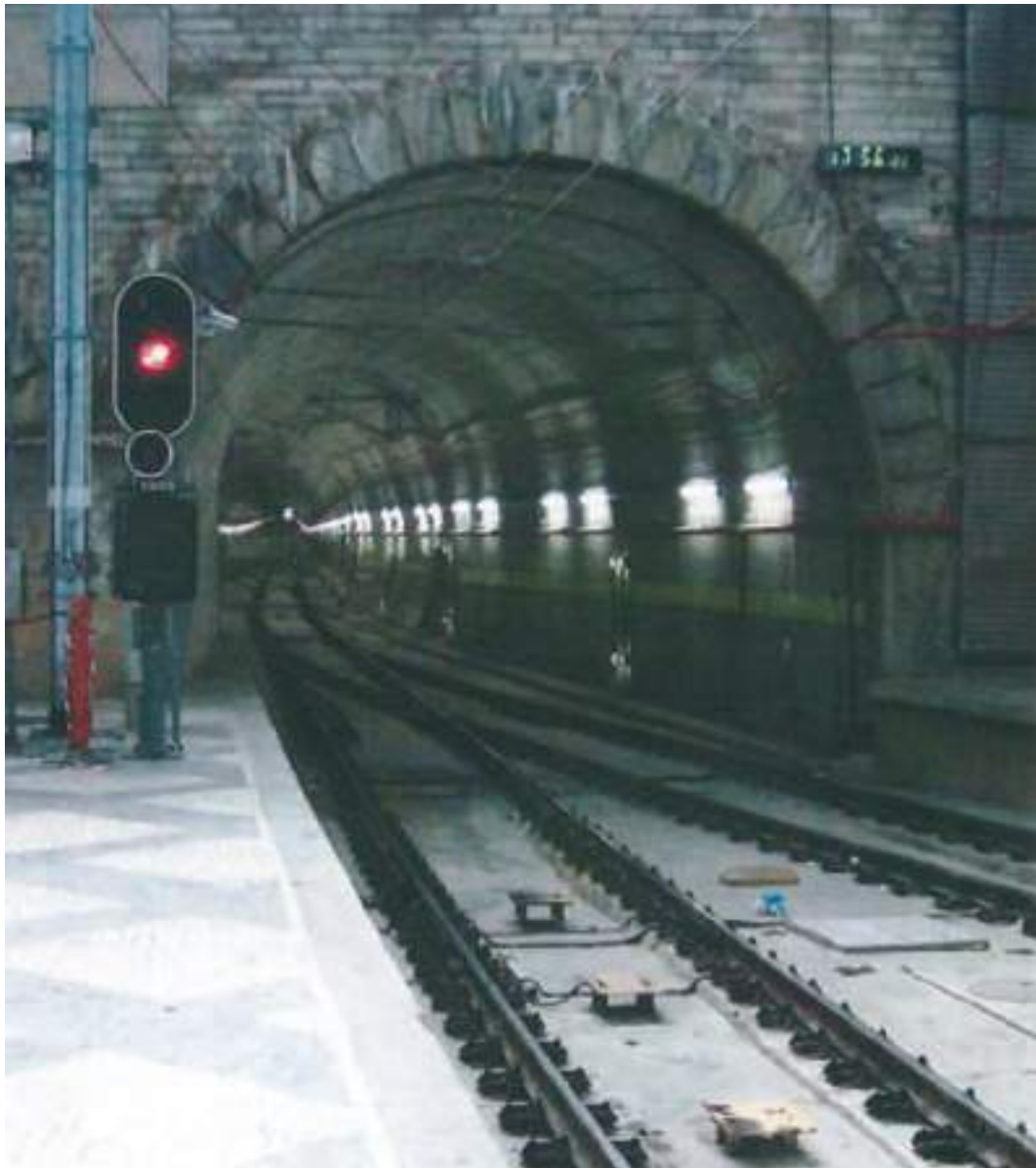
Fig. 05 Túnel concluído: Emboquilhamento. Finished Portal of the Tunnel.
