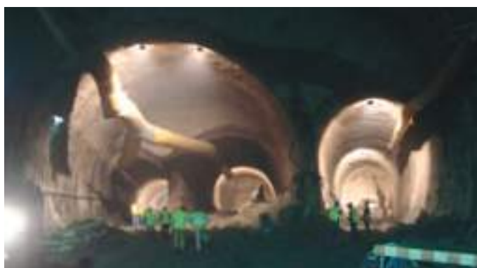
c) Túnel de via – revestimento secundário c) Track tunnel – final lining
