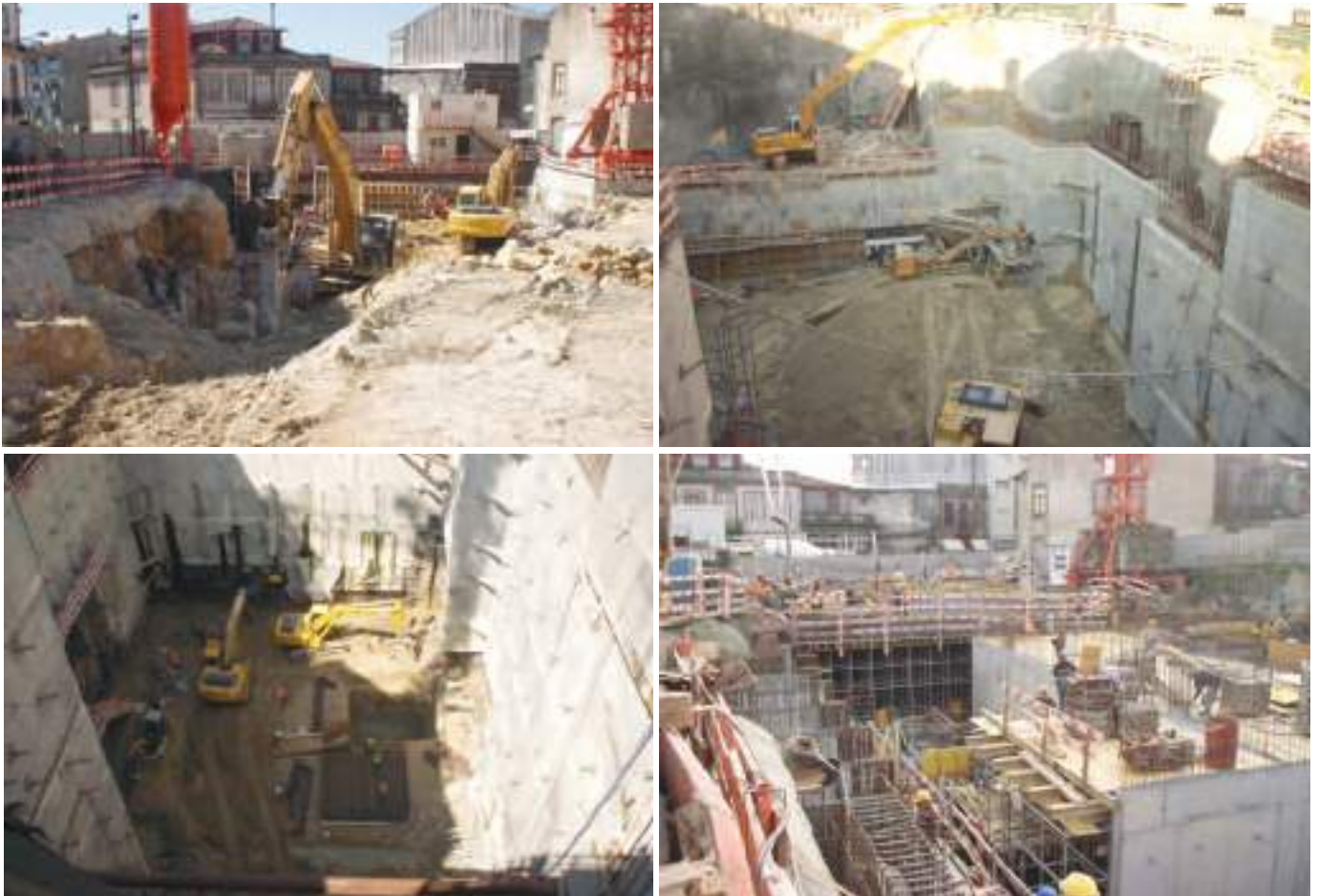
Fig. 04 Aspetos gerais dos trabalhos de abertura do poço. General views of the shaft.
