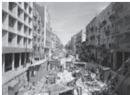
6 - Escavação do miolo e aterro sobre a abóbada
