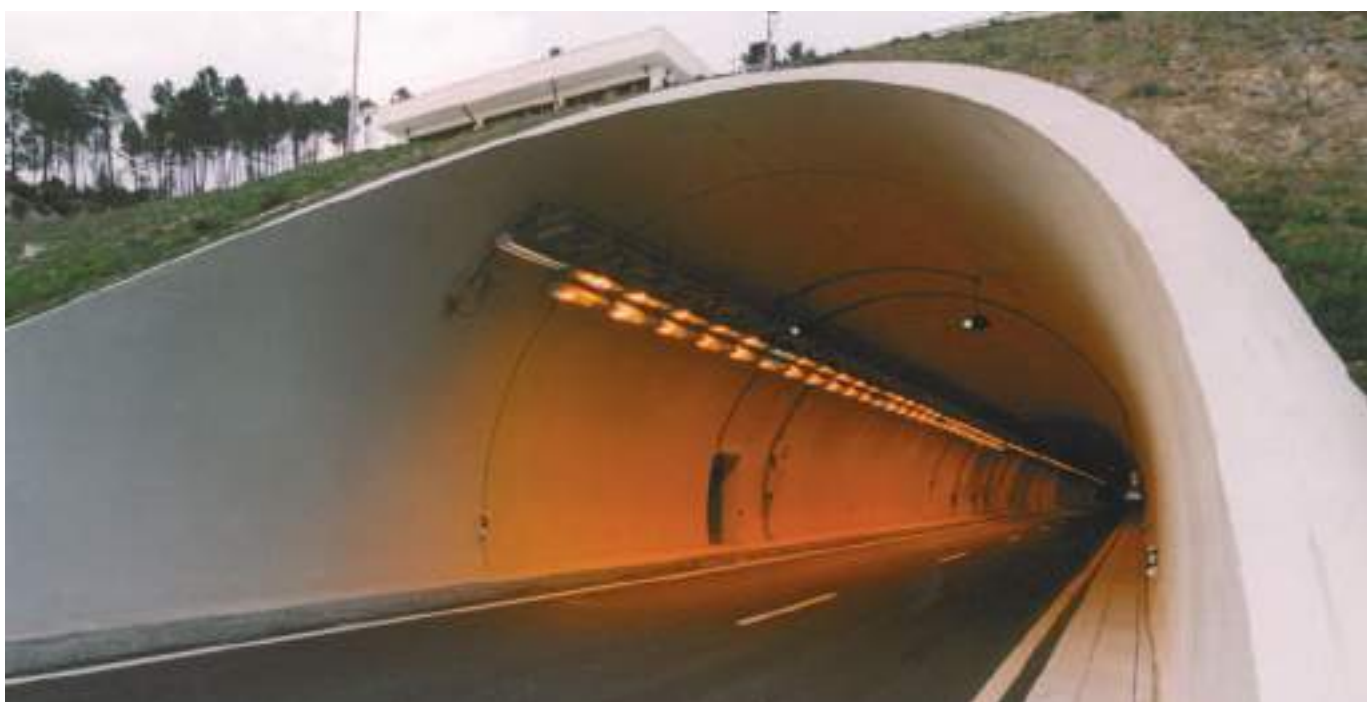
Fig. 05 Emboquilhamento Sul. Southern portal.
