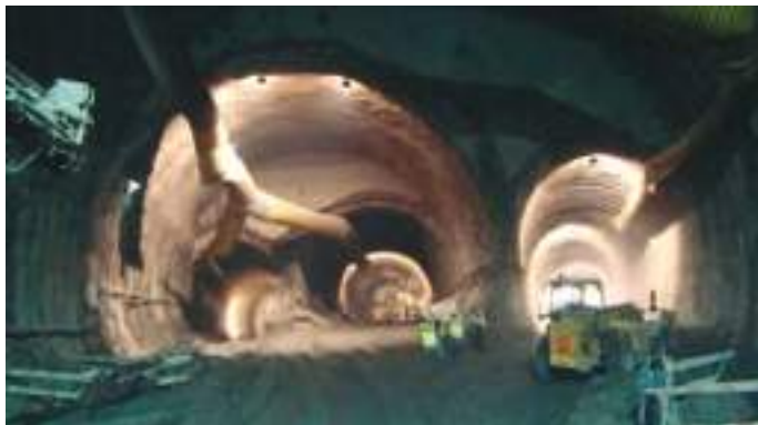
c) Câmara de alargamento – emboquilhamentos e arco invertido definitivo c) Widening chamber – portals and final invert
