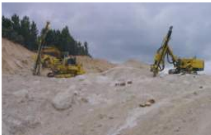
Túnel do Barracão - Trabalhos de desmorte na trincheira e de execução da secção de betão. Barracão Tunnel – Drilling works in the trench and execution of the concrete section.
