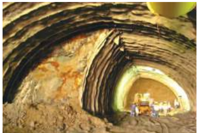
Fig. 03 Esquema do faseamento de escavação e foto da escavação da galeria Nascente Norte, aos pk 0+637,5 (fase 1) e 0+610 (fase 2). Excavation scheme and photo of eastern-northern gallery at pk 0+637.5 (stage 1) and 0+610 (stage 2).
