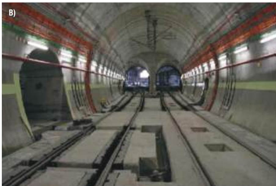
Fig. 04 Túnel concluído: a) secção de alvenaria e b) secção de betão. Finished tunnel: a) masonry section and b) concrete section.
