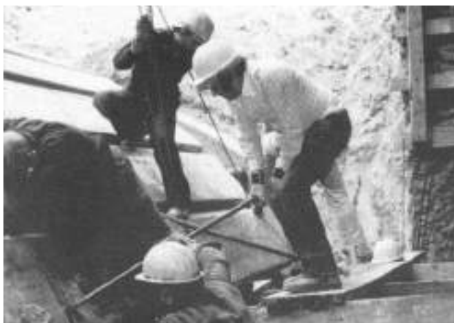
Túnel de Calvanas – Apoio da extremidade traseira das lanças no anel de montagem e dianteira nas cambotas de apoio (arquivo de imagens do Metropolitano de Lisboa). Calvanas Tunnel – Support of the back-end of the booms on the assembly ring and of the front-end on the supporting ribs (Metropolitano de Lisboa image archive).
