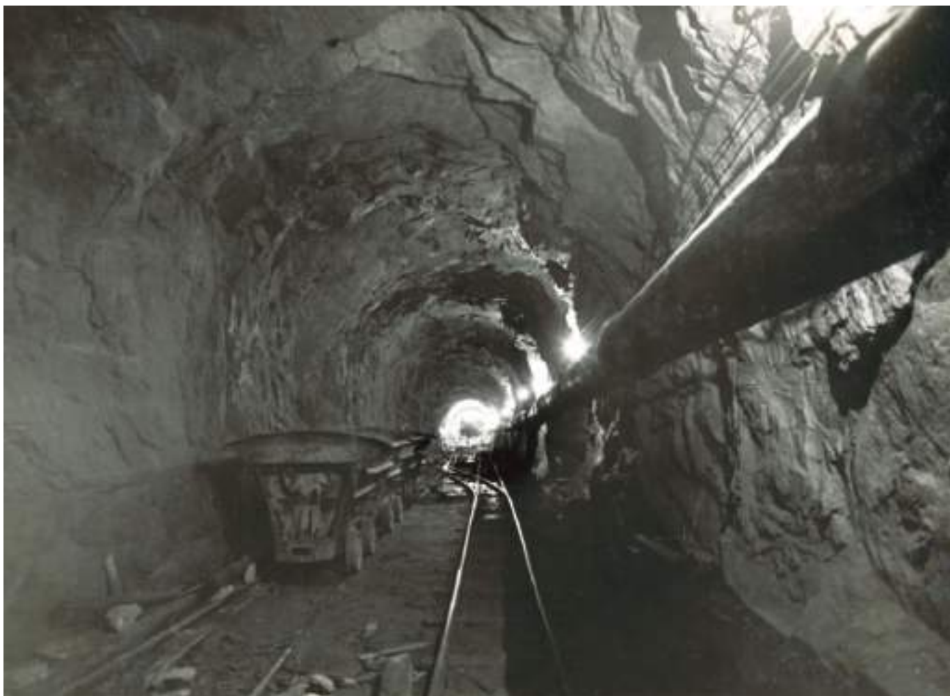
Fig. 07 Galeria de ataque à central, agora de ventilação e segurança. Cavern construction tunnel, now used for ventilation and safety.
