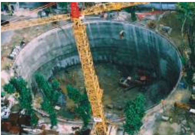
Vista geral do Poço e do quadro de reforço para emboquilhamento do túnel. General overview of the shaft and reinforcement framework for the tunnel portal.
