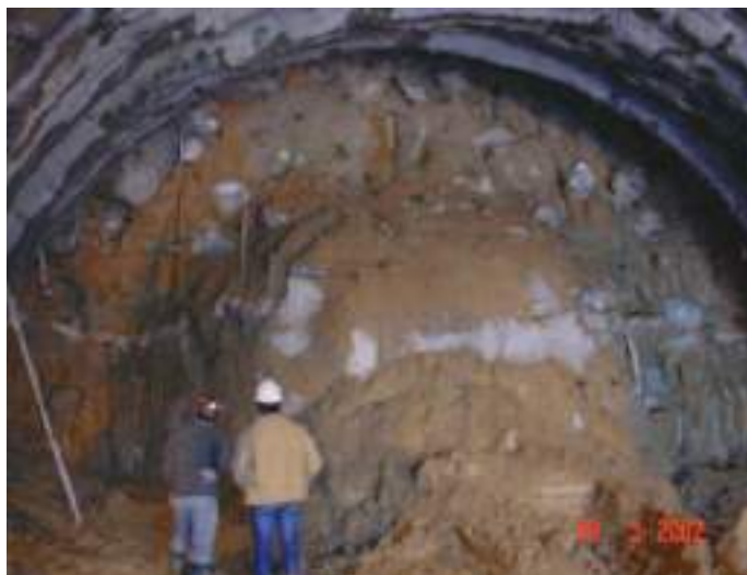
Fig. 02 Escavação da Fase 1 nos emboquilhamentos. Do lado Norte, em ZG4, à esquerda. À direita, no emboquilhamento Sul, em ZG3. Excavation of Stage 1 at portals. ZG4 at the Northern end (L.). ZG3 at Southern portal (R.).
