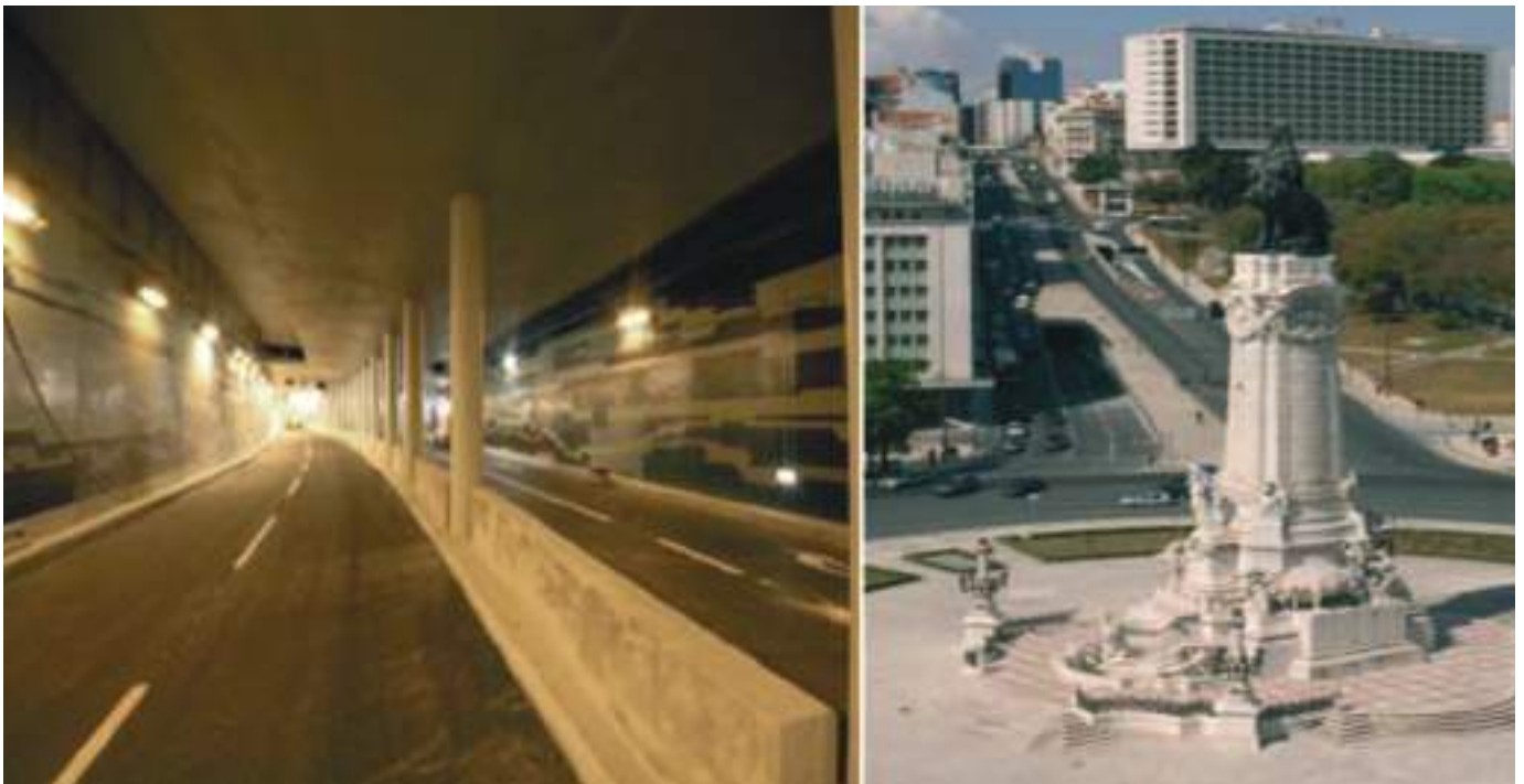
Fig. 13 Aspeto do interior do túnel e arranjo final da Praça do Marquês de Pombal. View of the final interior arrangement of the tunnel and of the final layout of the Marquês de Pombal Roundabout.
