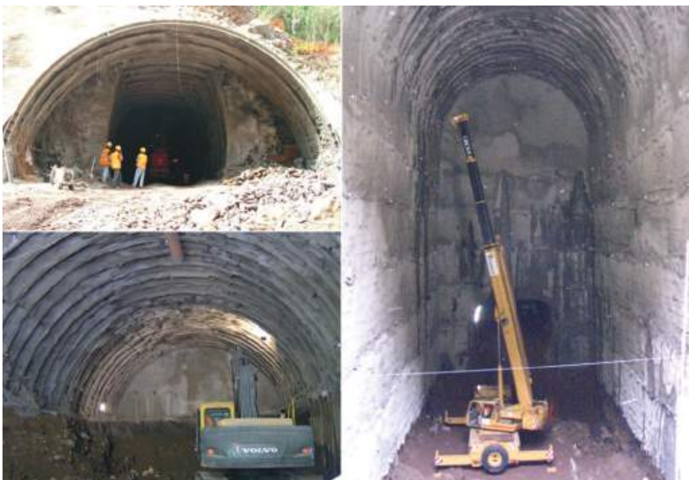
Fig. 06 Aspeto da escavação da galeria piloto e das destroças laterais, da fase de rebaixo e da secção plena. Views of the excavation of pilot gallery, top heading, benching and full cross section.
