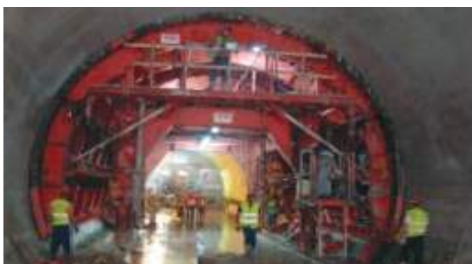
c) Túnel de via – revestimento secundário c) Track tunnel – final lining
