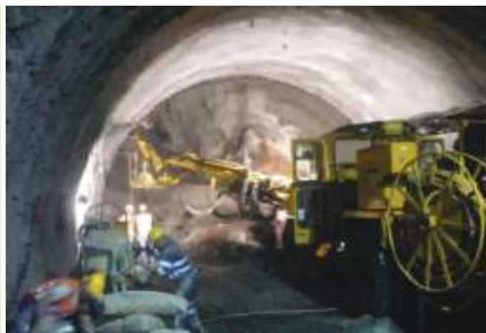
Fig. 05 Faseamento executivo e revestimento primário e vista da execução das enfilagens na frente Sul. Excavation stages and primary support and view of the forepoling installation at the southern heading face.
