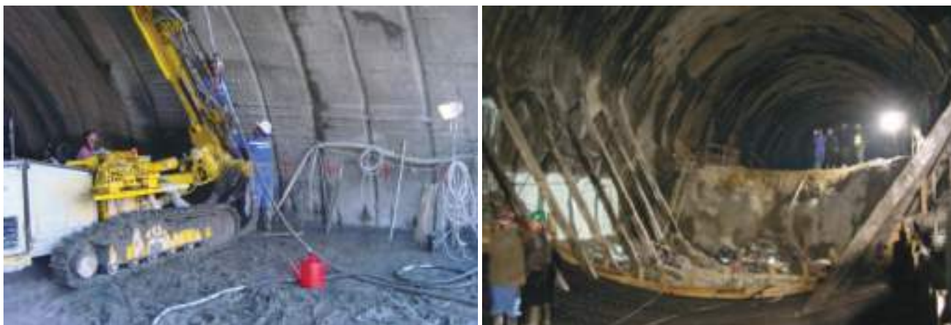
Fig. 03 Escavação em ZG4 – Fase 2. À esquerda execução de colunas em jet-grouting armadas e, à direita, execução da soleira curva em betão armado. Excavation on ZG4 – Stage 2. On the left constructing reinforced jet-grouting columns. On the right, construction of reinforced concrete arch invert.
