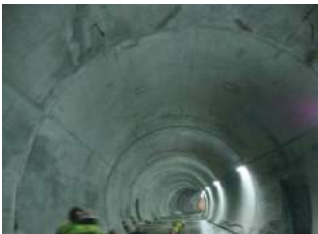
Fig. 16 Revestimento definitivo em betão armado. Final lining in reinforced concrete.
