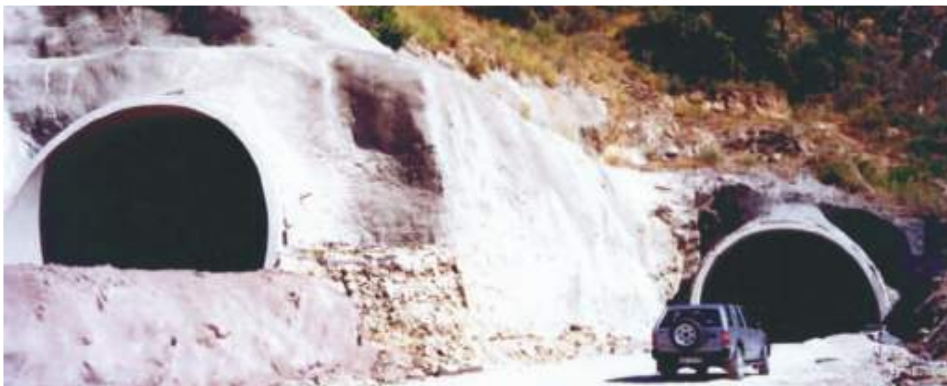
Fig. 04 Aspeto do emboquilhamento Sul, com vias desfasadas em altura e longitudinalmente. Varosa Tunnel. Southern portal aspect.
