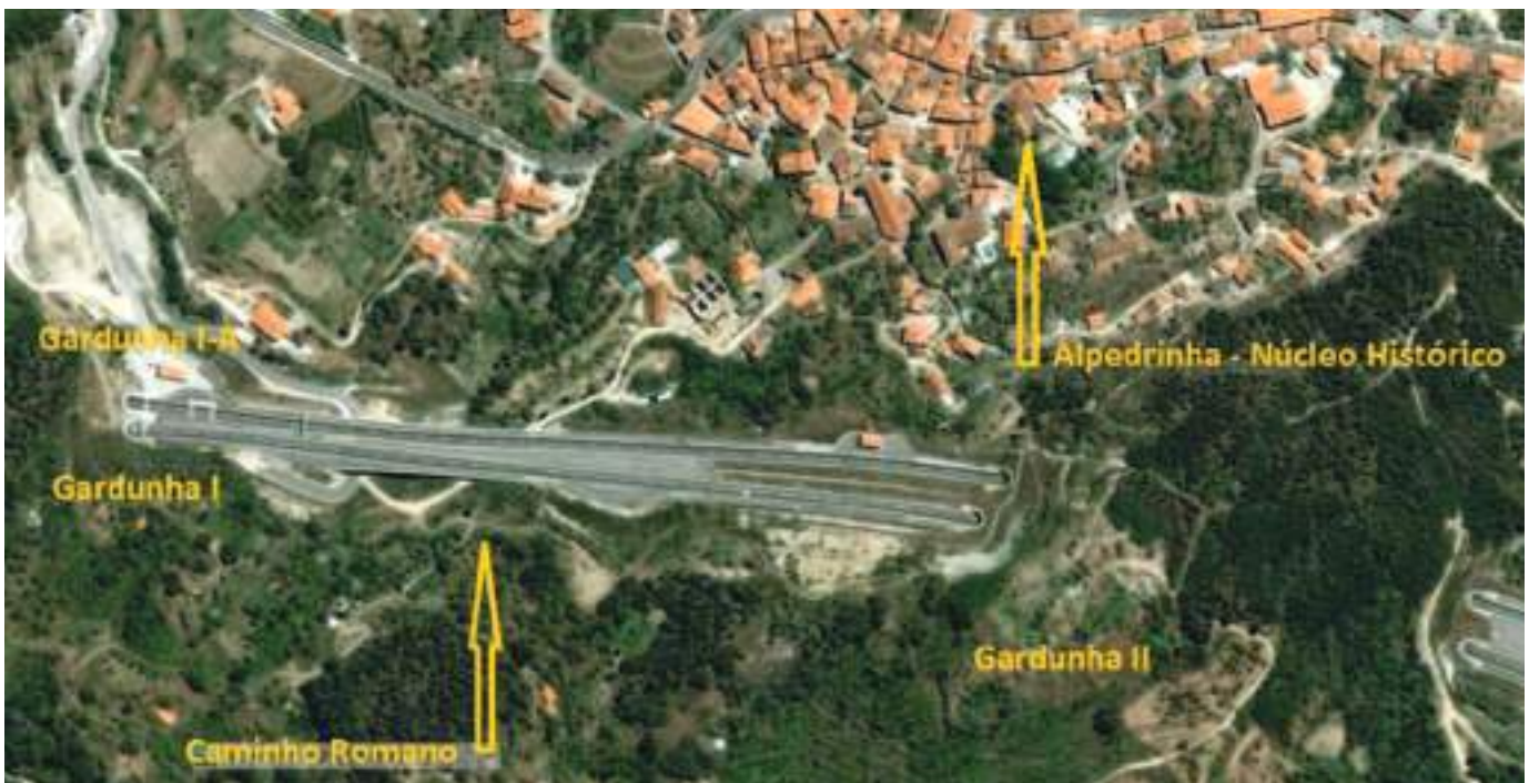
Fig. 01 Vista aérea de Alpedrinha, incluindo o túnel de Alpedrinha (Gardunha II) e o emboquilhamento Sul dos túneis da Gardunha I e I-A. Aerial view of Alpedrinha, including Alpedrinha (Gardunha II) tunnel and southern portal of Gardunha I and I-A.
