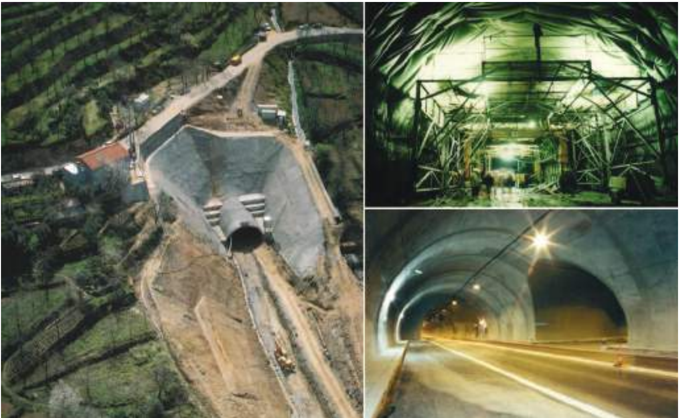
Emboquilhamento norte. Instalação da membrana de PVC. Zona de inversão de marcha. Northern portal (L). Installation of the PVC membrane. Emergency layby.
