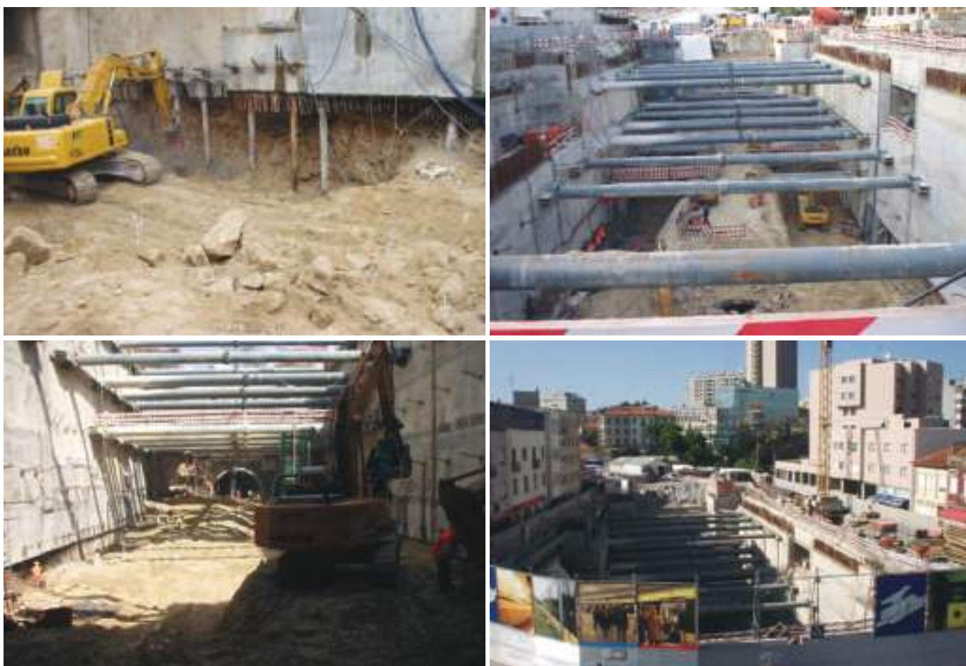
Fig. 05 Vistas gerais da obra. General views of the work.
