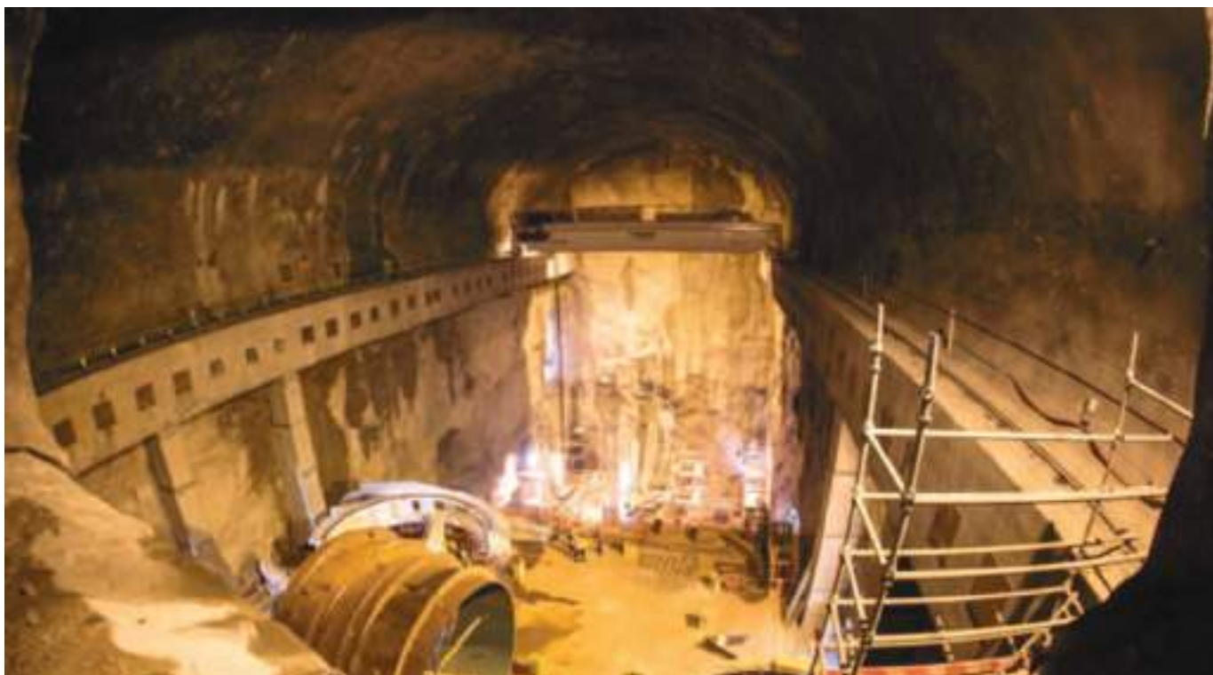
Escavação da central. Em primeiro plano o átrio de montagem. Ao fundo a zona do grupo. Powerhouse excavation. Assembly hall in the foreground and turbine/generator unit zone in the back.
