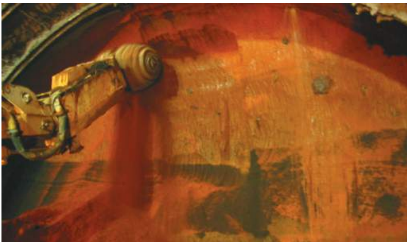
Fig. 03 Escavação mecânica em ZG4. Mechanical excavation in ZG4.
