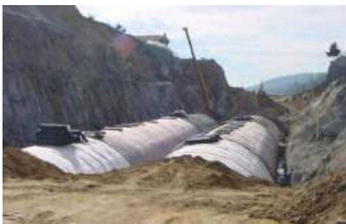
Túnel do Barracão – Aspeto geral dos trabalhos de impermeabilização, drenagem e reaterro. À direita, aspeto do muro ancorado de proteção à habitação localizada no emboquilhamento Sul. Barracão Tunnel – General aspect of the waterproofing, draining and re-filling works. Right: aspect of the anchored wall to protect the house located at the southern portal.
