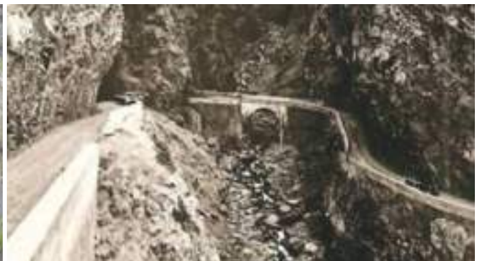
Túnel da Ribeira do Inferno Ribeira do Inferno Tunnel
