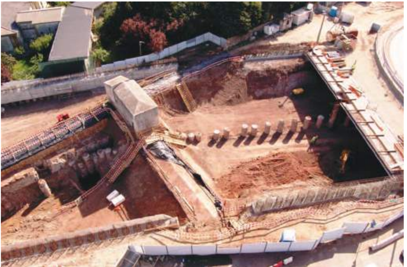
Fig. 07 Vista aérea na zona de interferência dos aquedutos com o túnel na fase de construção. Aerial view of the interference zone of the aqueducts with the tunnel in the construction stage.
