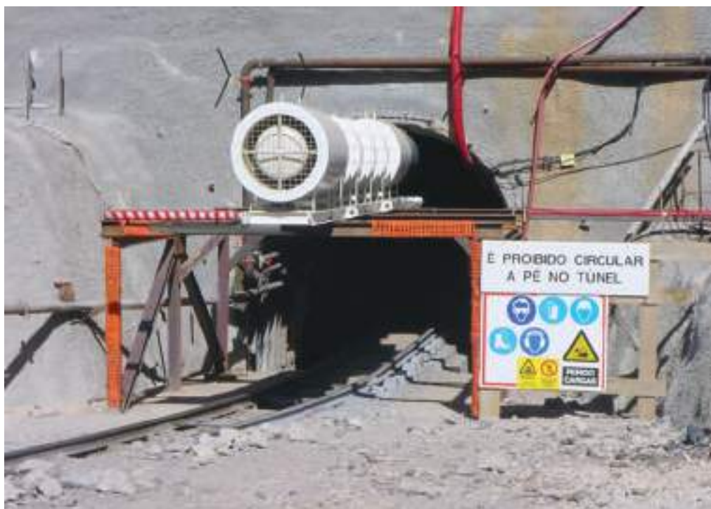
Fig. 02 Emboquilhamento de jusante. Downstream portal.
