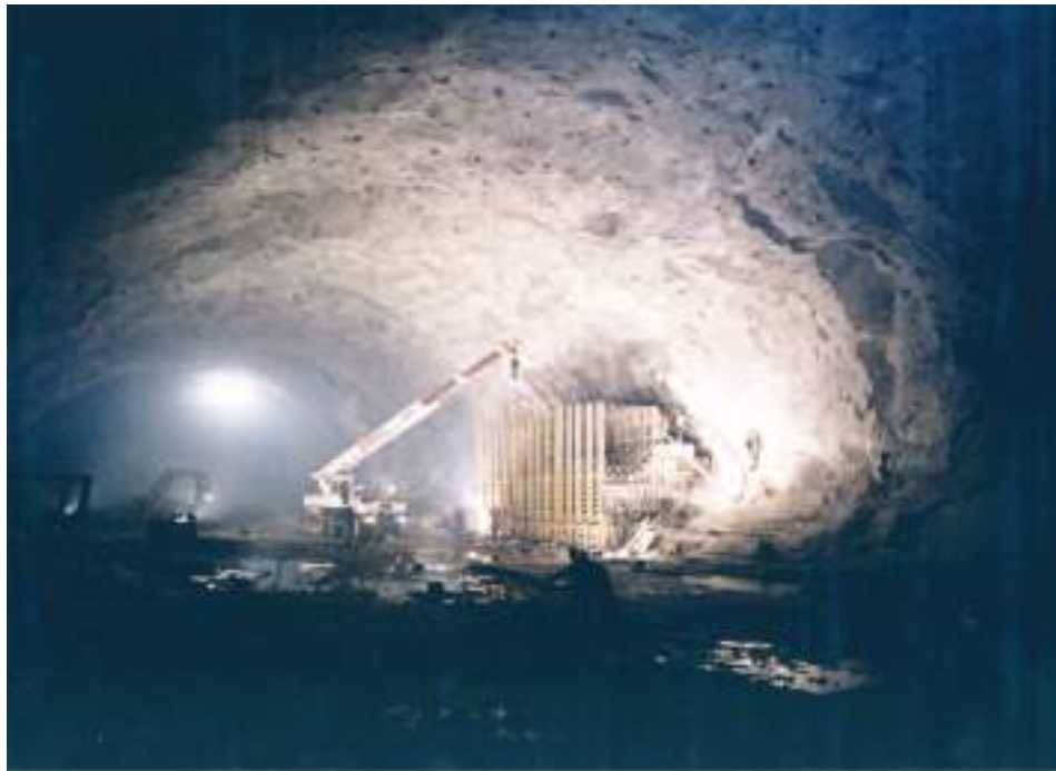
Fig. 03 Abóbada da caverna dos grupos (central). Vault of the powerhouse cavern.
