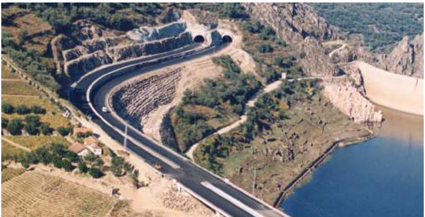
Fig. 01 Foto dos túneis e barragem do Varosa. Varosa tunnels and dam.
