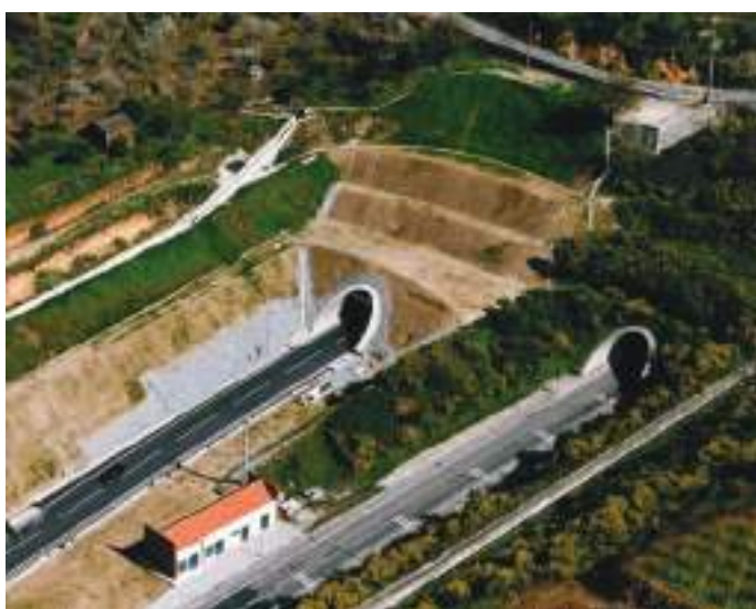
Fig. 05 Emboquilhamento Norte, com ambos os túneis em operação. Northern Portal, with both tunnels in operation.
