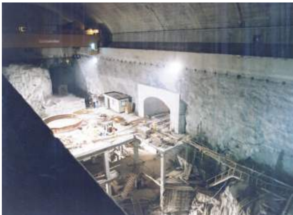
Fig. 04 Caverna dos grupos (central). Powerhouse cavern.
