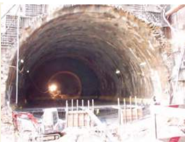
Fig. 07 Secção transversal tipo, faseamento executivo e vista geral a partir do poço do Túnel 4 nascente, na fase final de instalação do revestimento primário. Cross-section, construction phases and general view from the shaft of eastern Tunnel 4, at the final stage of the primary lining installation.
