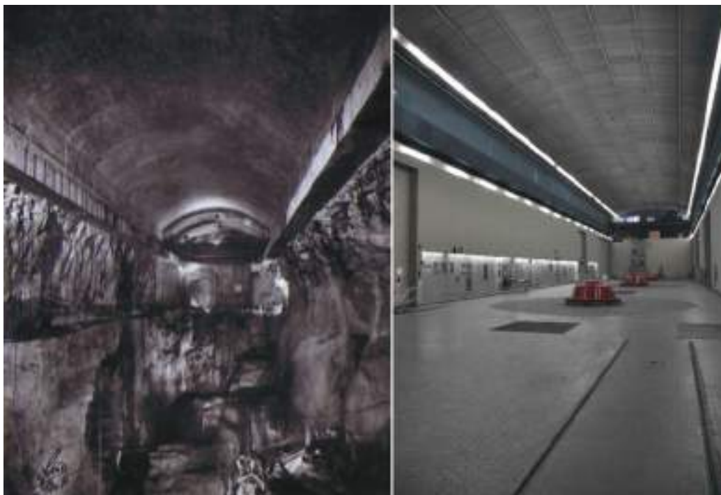
Fig. 04 Central I. Escavação da zona das turbinas. Central concluída. Powerhouse I. Turbine hall excavation. Finished powerhouse.
