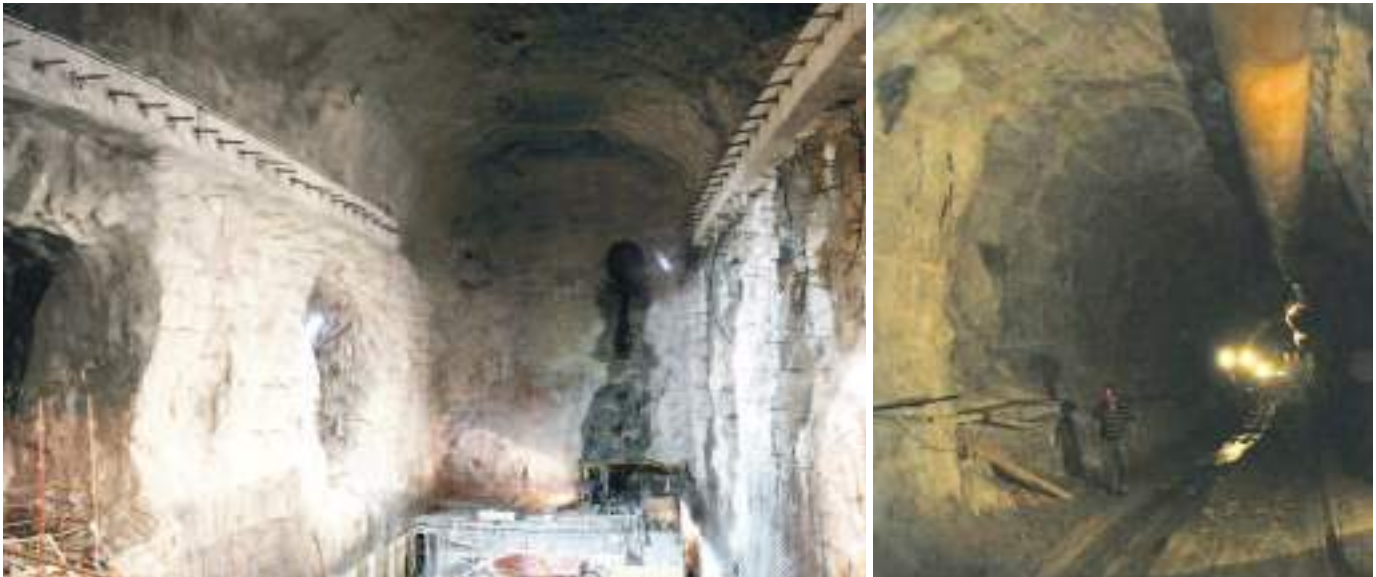
Fig. 05 Caverna da Central e galeria de carga em construção. Powerhouse cavern and headrace tunnel under construction.
