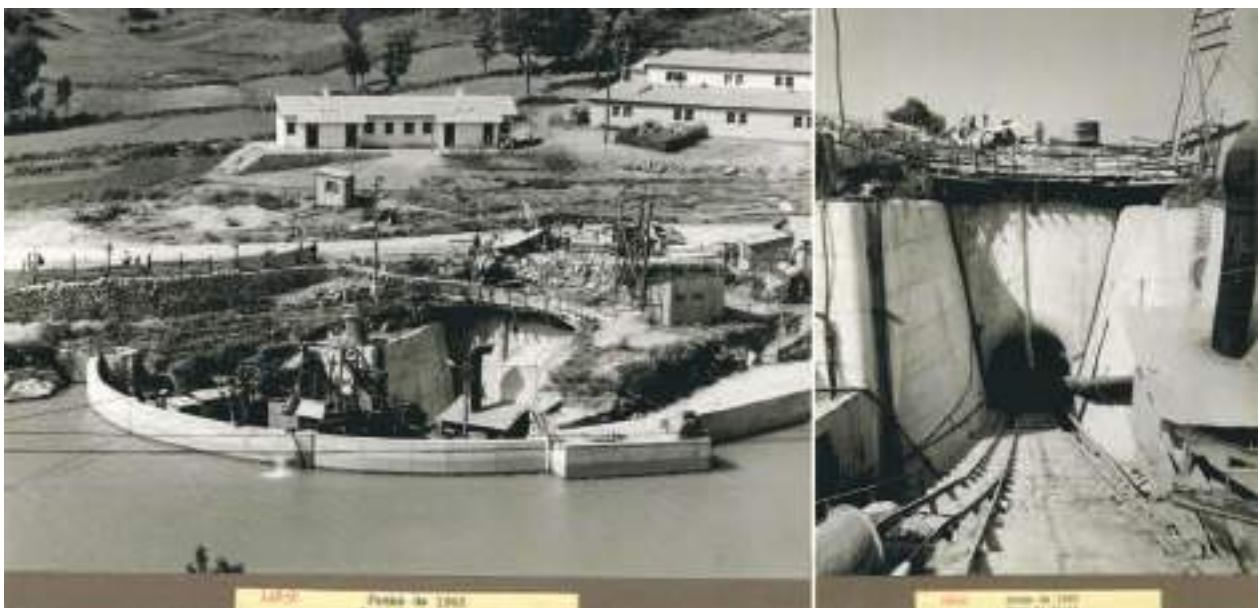
Boca de saída do túnel de restituição e respetiva ensecadeira. Tailrace tunnel outlet and respective cofferdam.
