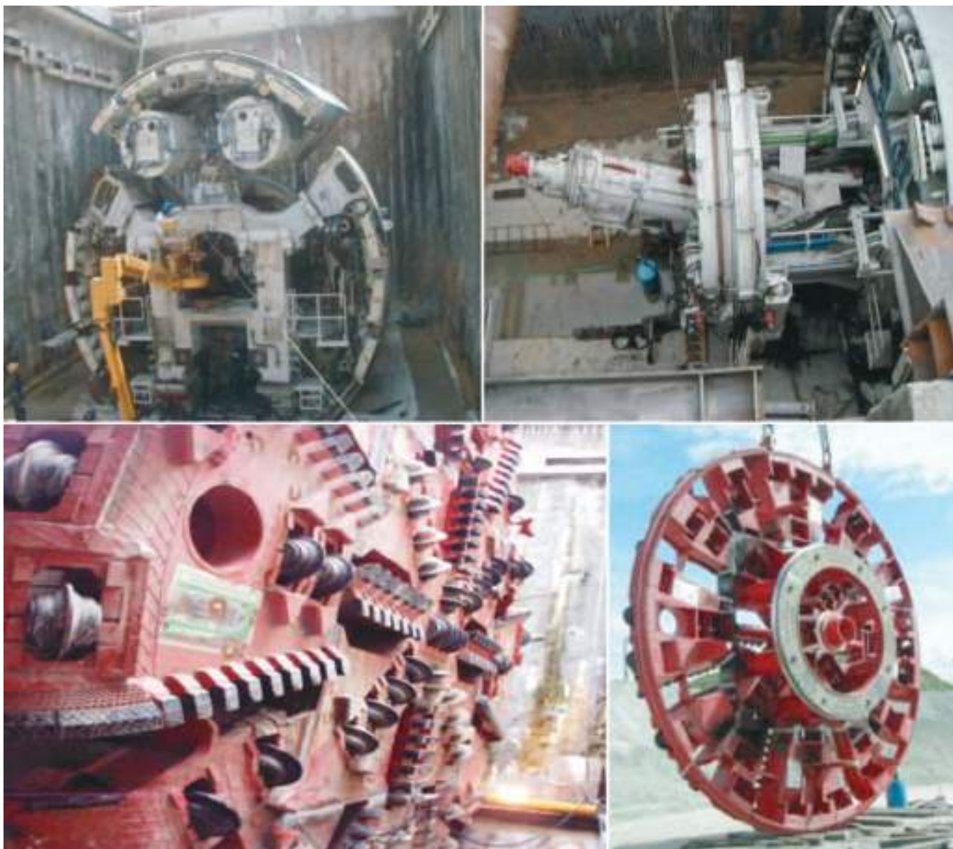
Fig. 03 Montagem da Tuneladora. Tunnel Boring Machine assembly.
