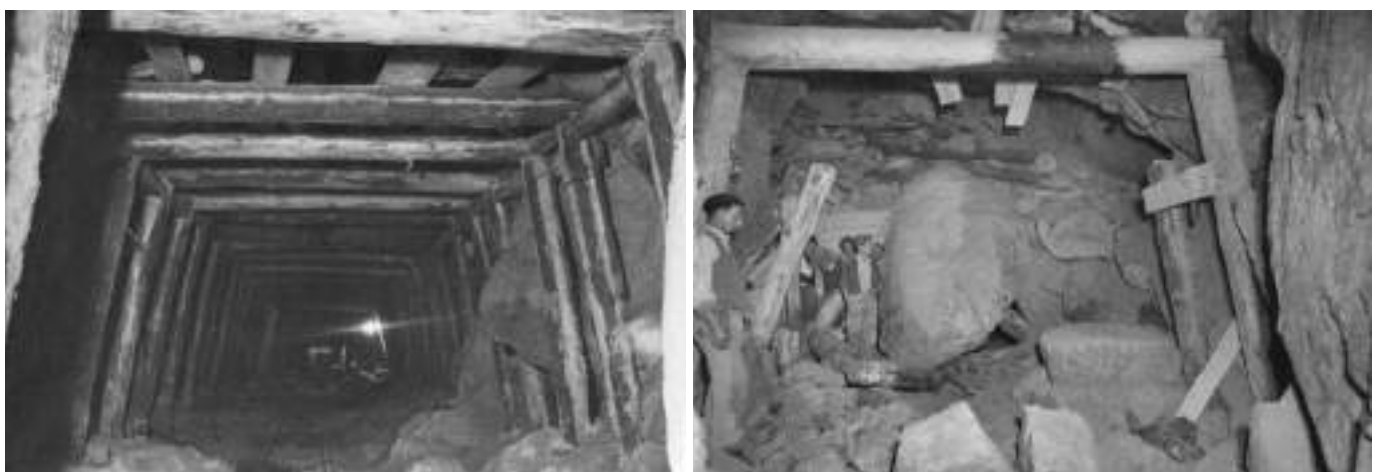
Fig. 08 Entivação na zona dos desprendimentos (Agosto, 1948) (Esq.). Desprendimento de terras até à superfície do terreno (Abril, 1949) (Dir.). Primary support in the rock fall area (August, 1948) (L.) Rock fall until the surface (April, 1948) (R.).
