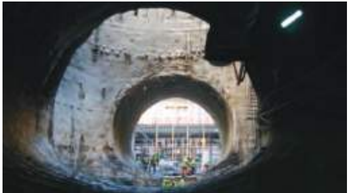
a) Poço Tejo – Escavação - Ataque do Troço 97 e NATM sob Canal Tejo a) Tagus Shaft - Excavation - stretch 97 opening and NATM under Tagus Canal
