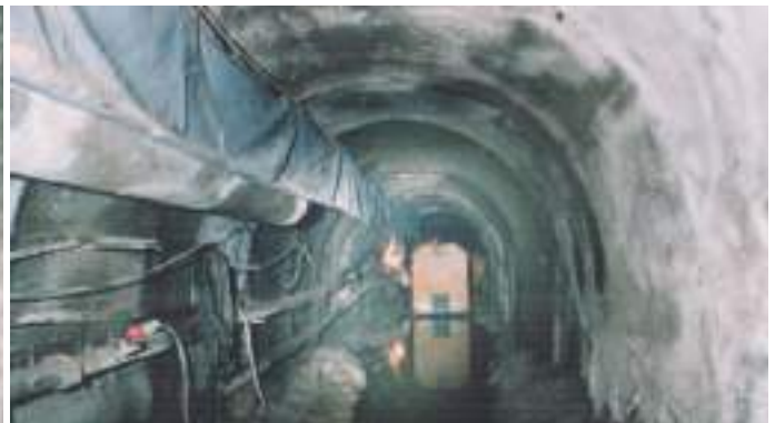
Frente de escavação do Túnel 6 Excavation face of Tunnel 6
