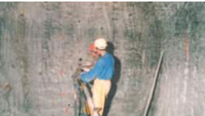
Frente de escavação do Túnel 5 Excavation face of Tunnel 5
