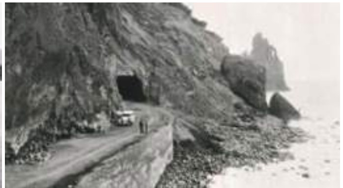
Emboquilhamento este do túnel Ribeira da Janela Eastern portal of Ribeira da Janela Tunnel
