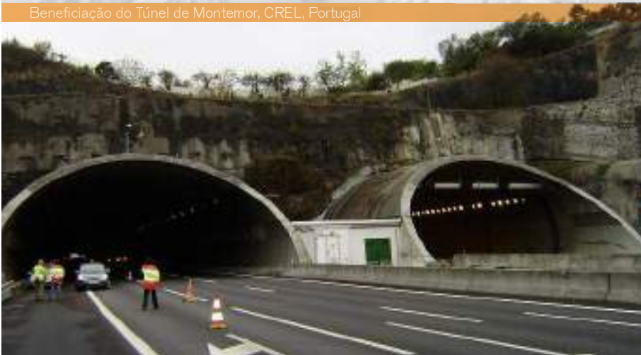
Beneficiação do Túnel de Montemor, CREL, Portugal
