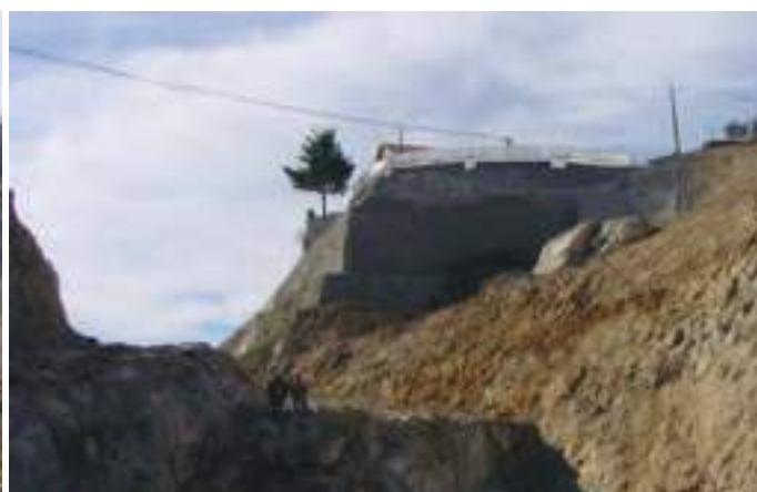
Túnel do Barracão – Aspeto geral dos trabalhos de impermeabilização, drenagem e reaterro. À direita, aspeto do muro ancorado de proteção à habitação localizada no emboquilhamento Sul. Barracão Tunnel – General aspect of the waterproofing, draining and re-filling works. Right: aspect of the anchored wall to protect the house located at the southern portal.
