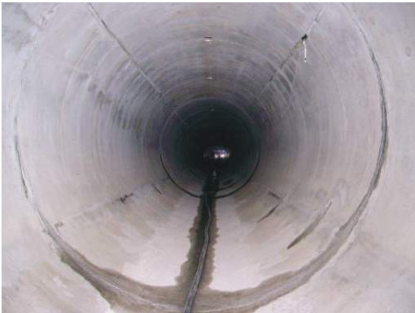
Fig. 08 Túnel revestido. Lined tunnel.
