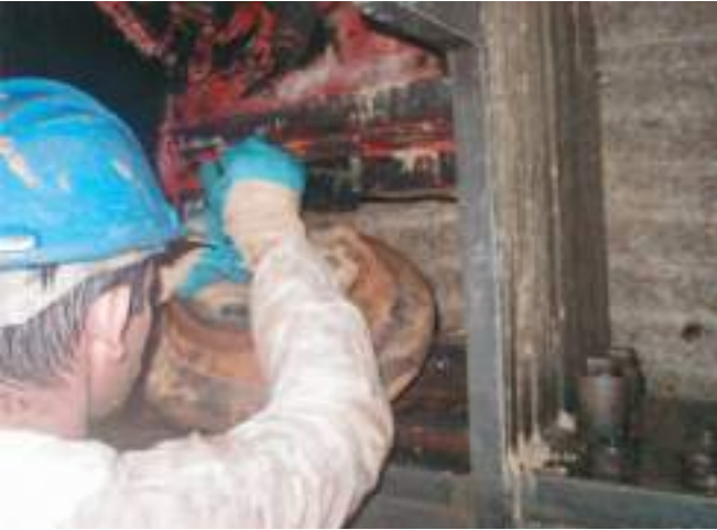
Fig. 07 Manutenção - Substituição de um rolo de corte. Maintenance – Replacement of a cutting roller.
