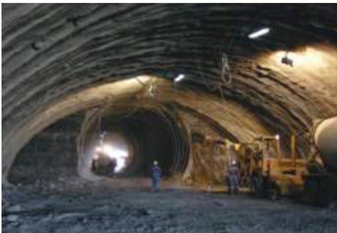
Fig. 05 Faseamento executivo da meia secção superior e vista geral do emboquilhamento sul. Upper half cross-section execution sequence and overview of the southern portal.
