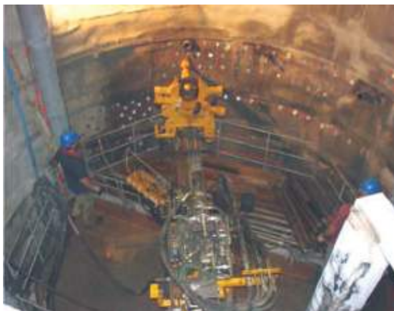
Fig. 08 Poço para tratamento debaixo dos Edifícios. Shaft for ground treatment.
