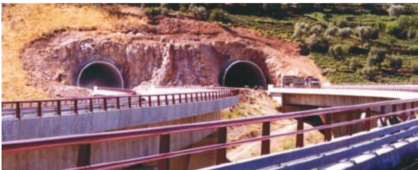
Fig. 05 Aspeto do emboquilhamento Norte, escavado em granitos e viadutos adjacentes. Northern portal aspect, excavated in granite and adjacent viaducts.
