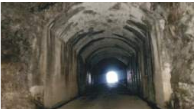
Revestimento em betão ciclópico, Túnel Água D'Alto, 1965 Cyclopean concrete lining of Água D'Alto Tunnel, 1965
