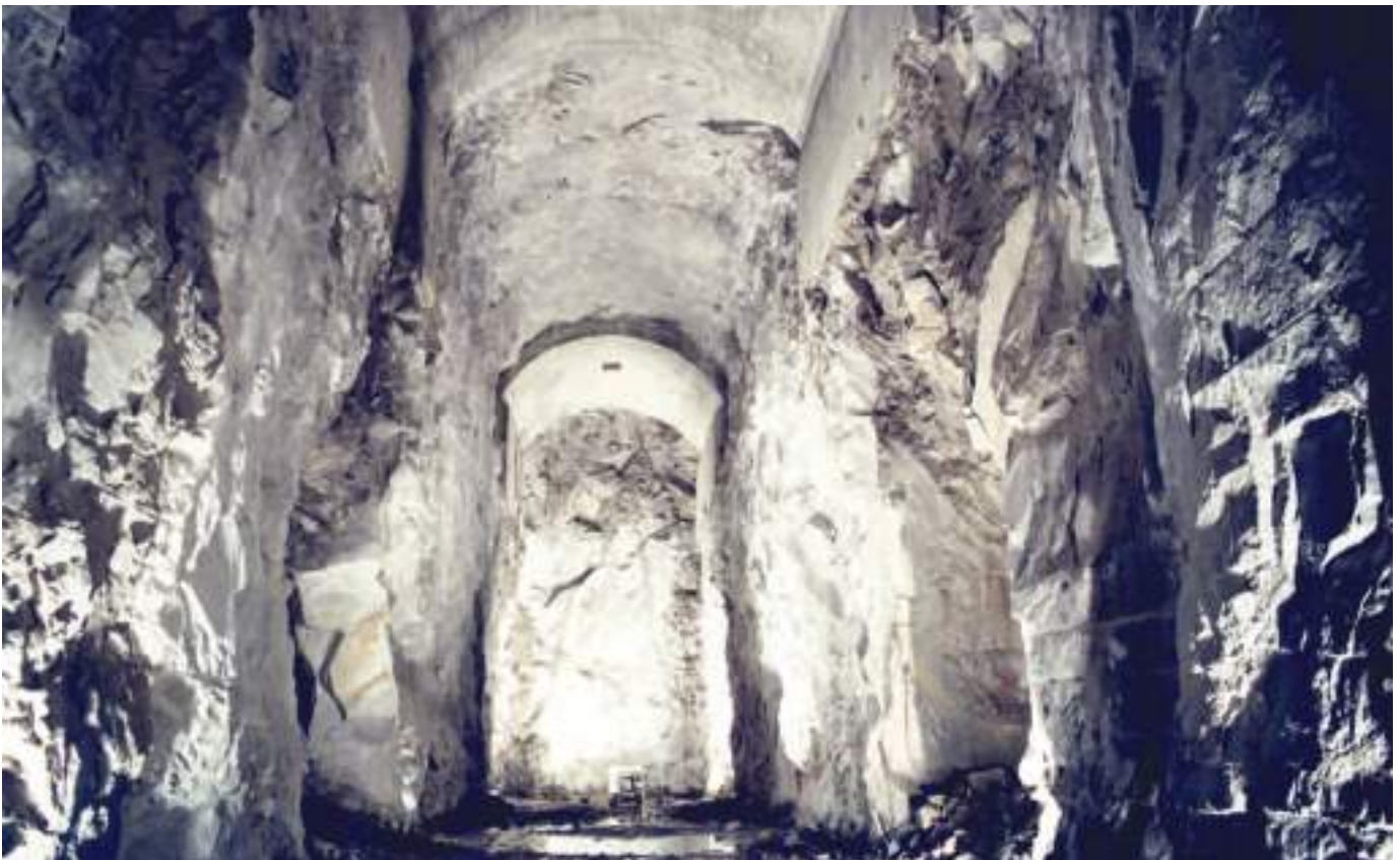
Fig. 06 Câmara das válvulas esféricas. Spherical valve chamber.
