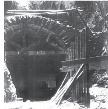
Construção do revestimento do Túnel II da via Fajã da Ovelha/Paul do Mar, 1971 Construction of Tunnel II lining of the road Fajã da Ovelha/Paul do Mar, 1971
