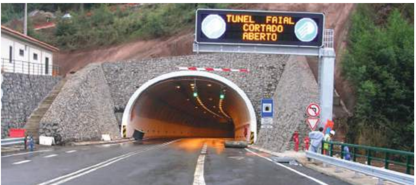
Fig. 12 Portal oeste do túnel do Faial-Cortado. West portal of Faial-Cortado tunnel.
