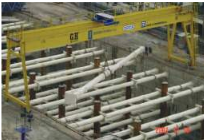
Fig. 04 Colocação de uma escora do 3º nível (à esquerda). Vista dos três primeiros níveis de escoramento da zona larga da Estação (à direita). Placement of a 3rd level prop (left). View of the three first levels of shoring in the wide zone of the Station (right).
