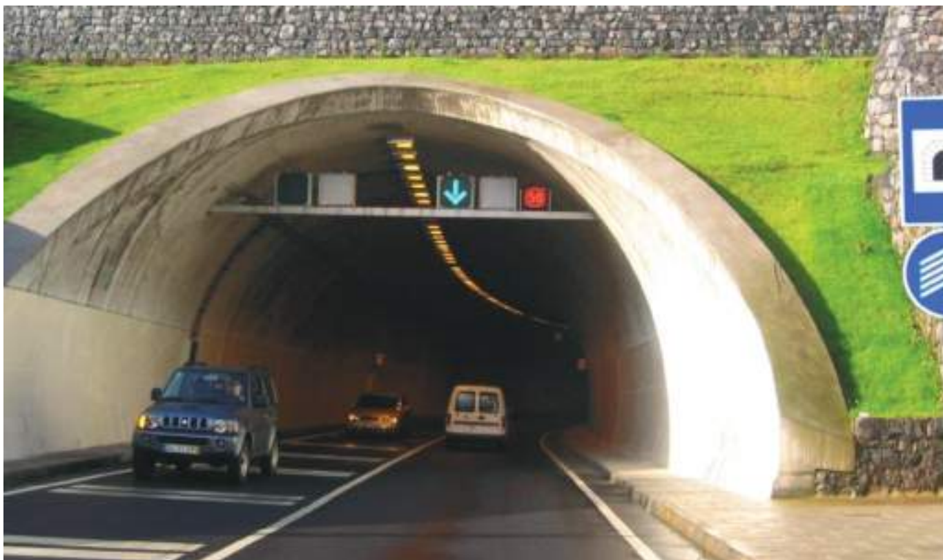
Fig. 05 Emboquilhamento Nascente. Eastern portal.
