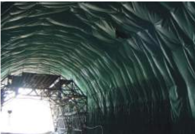
Fig. 02 Túnel da Ramela, colocação do sistema de impermeabilização (à esq.) e aspeto do emboquilhamento Sul (à dir.). Ramela Tunnel, installation of the waterproofing system (left.) and aspect of the southern portal (right.).
