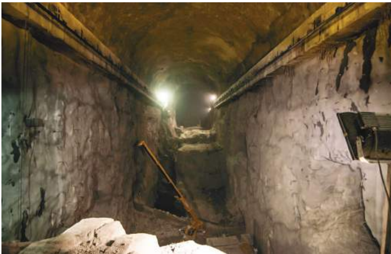
Escavação da caverna dos grupos e transformadores. Excavation of the powerhouse and transformer caverns.
