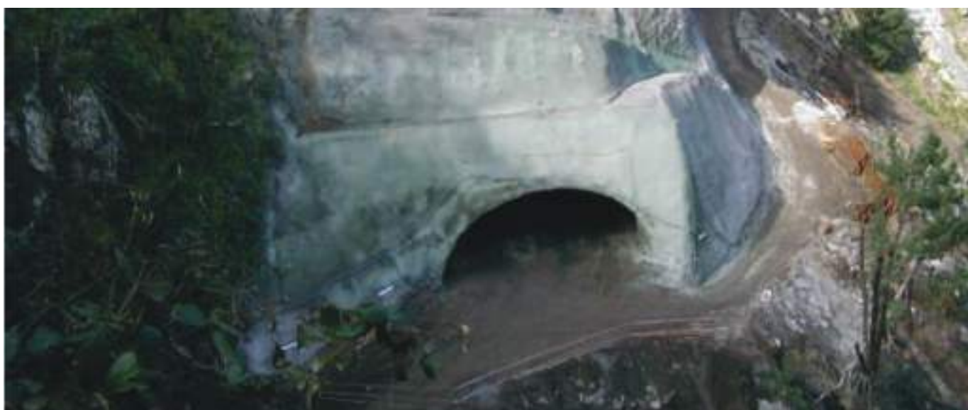
Fig. 01 Vista geral do emboquilhamento Este do túnel do Cortado. Overview of the Cortado tunnel eastern portal.
