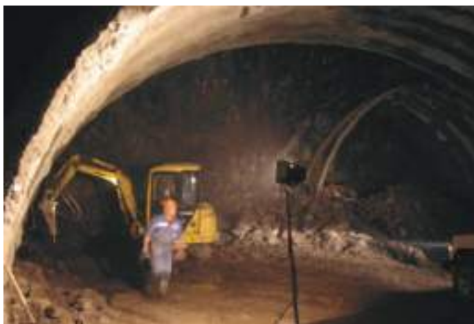
Fig. 04 Aspeto dos revestimentos primários da secção de alargamento e da galeria pedonal de emergência. View of primary supports in wide section and emergency pedestrian gallery.
