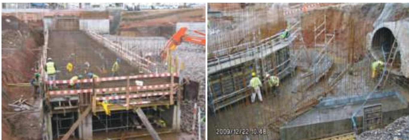
Fig. 03 Restabelecimento do Caneiro da Damaia sobre o Túnel de Benfica. Re-establishment of the Damaia waterway over the Benfica Tunnel.
