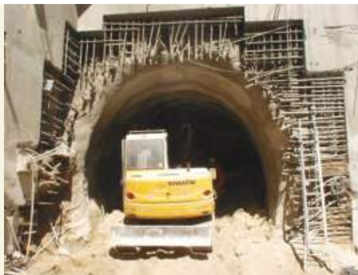
Fig. 06 Secção transversal tipo, faseamento executivo e vista geral do Túnel 2 a partir do poço na fase final de instalação do revestimento primário. Cross-section, construction phases and general view of Tunnel 2 from the shaft at the final stage of the installation of the primary lining.
