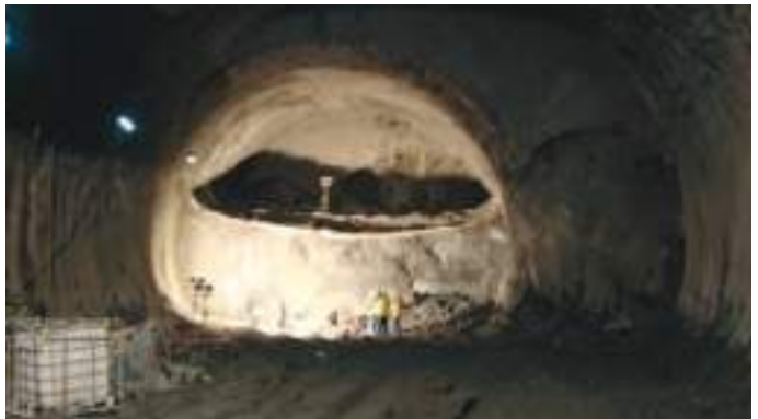
b) Câmara de alargamento – emboquilhamento túnel descendente b) Widening chamber – downward tunnel portal
