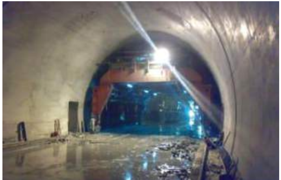
Fig. 05 Vista geral do emboquilhamento definitivo Sul e do revestimento definitivo. General view of the final South portal and of the final lining.
