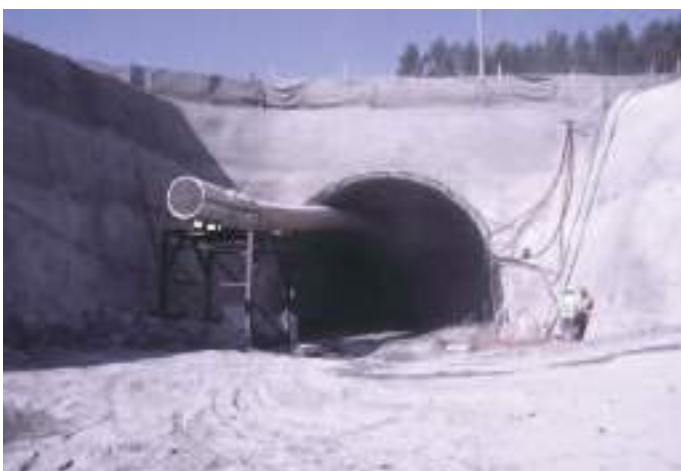
Vista geral do emboquilhamento provisório Sul e do sistema de impermeabilização. General view of the provisional South portal and of the waterproofing system.
