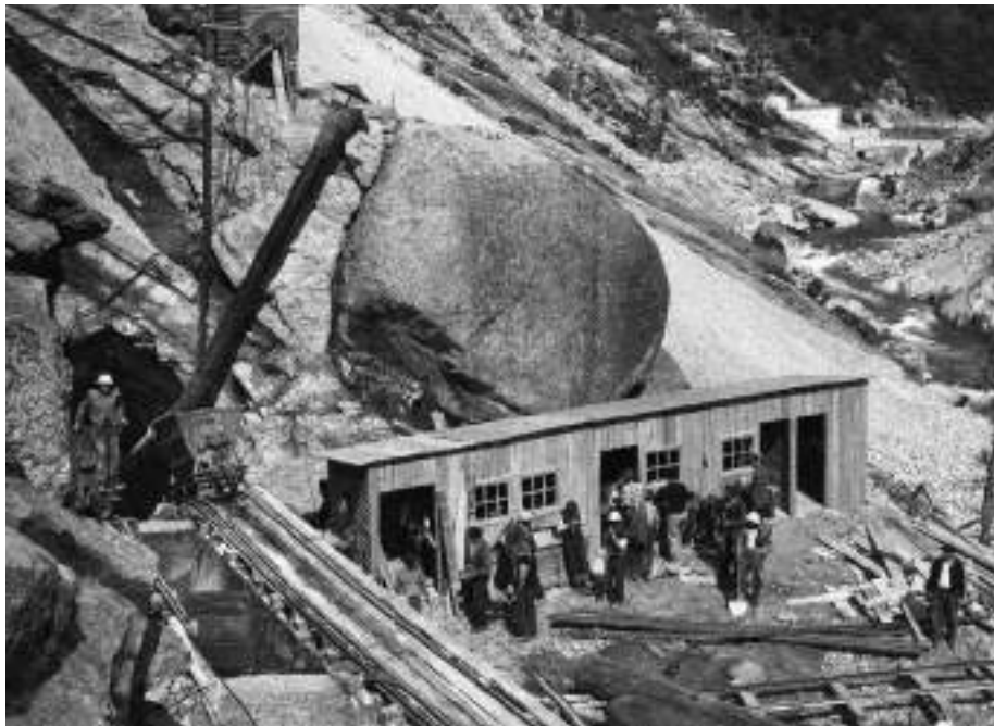
Fig. 06 Boca da galeria de ataque à central. Portal of the powerhouse construction tunnel.
