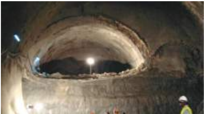
b) Câmara de alargamento – emboquilhamento túnel descendente b) Widening chamber – downward tunnel portal
