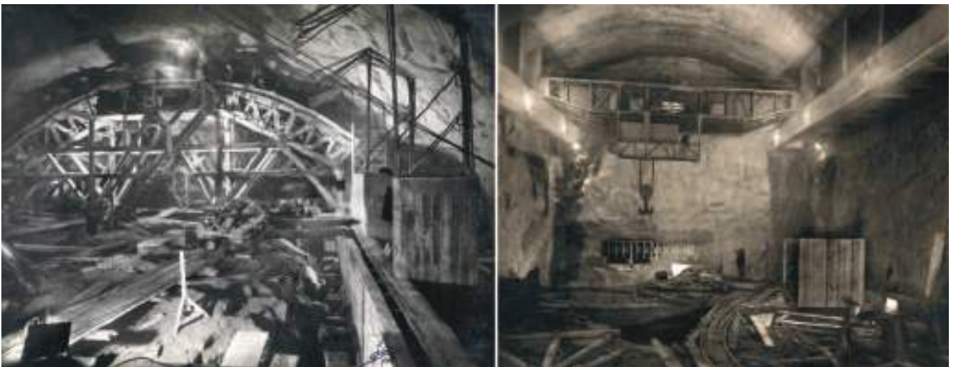
Fig. 04 Betonagem da abóbada da central (foto esquerda) e abóbada revestida com ponte rolante já montada (foto direita).
