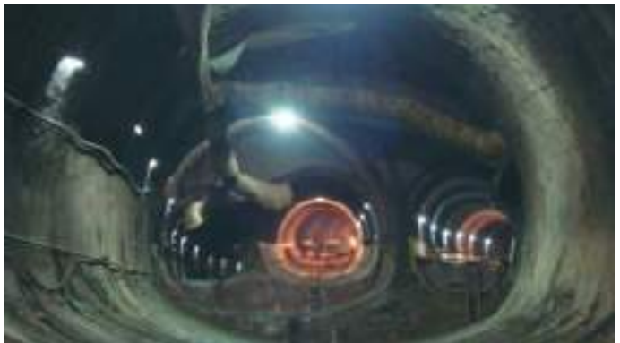
c) Câmara de alargamento – emboquilhamentos e arco invertido definitivo c) Widening chamber – portals and final invert
