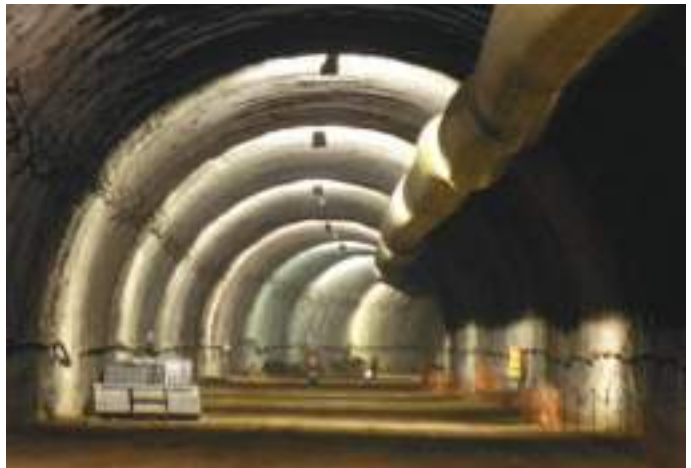
Fig. 04 Aspetto da frente de escavação e do revestimento primário aplicado e vista da secção plena. Front view of the excavation and applied primary support and view of the fully excavated section.
