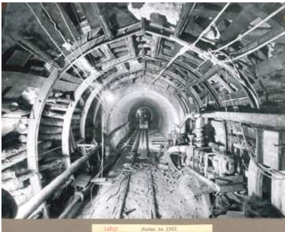
Troço de túnel de restituição de características geomecânicas desfavoráveis. Section of tailrace tunnel with unfavourable geomechanical characteristics.
