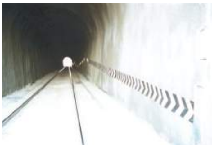
Fig. 08 Aspeto final da obra, com interior revestido com betão projetado e sinalização de segurança. Direita: emboquilhamento de entrada do túnel da Certã. Final appearance of the work, the inside lined with shotcrete and safety signs. Right: emboquilhamento de entrada do túnel da Certã.
