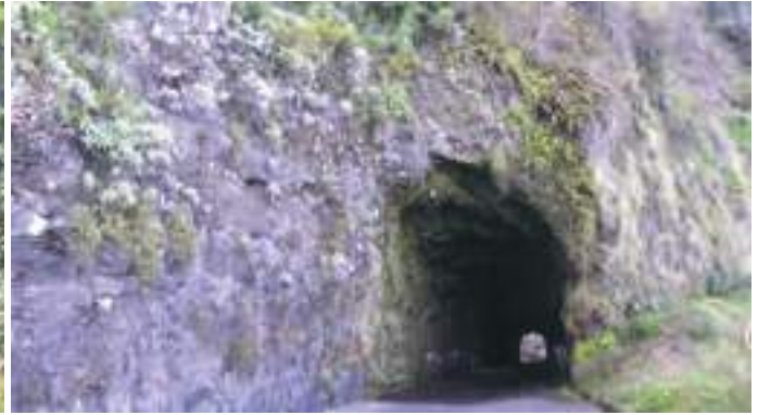
Túnel Água d'Alto, 1965 Água d'Alto Tunnel, 1965
