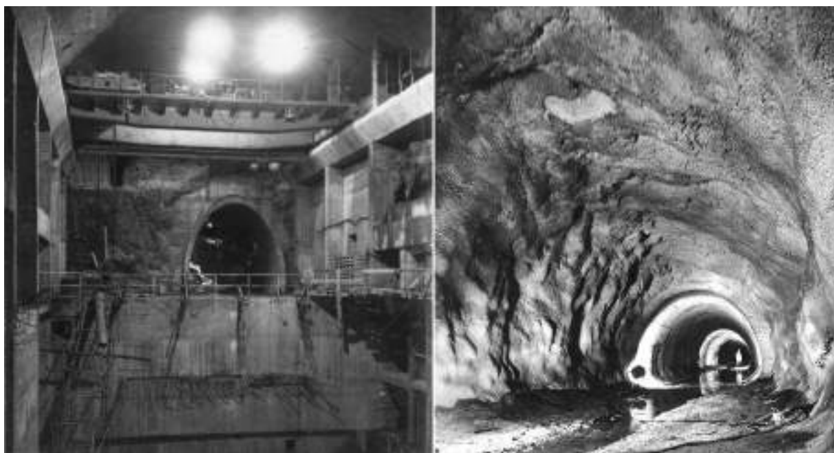
Central em construção (esq.) e túnel de restituição (dir.) onde se observam uma zona com betão projetado e troços com betão cofrado. Left, powerhouse under construction. Right, the tailrace tunnel - note a zone with shotcrete and sections lined with cast concrete.
