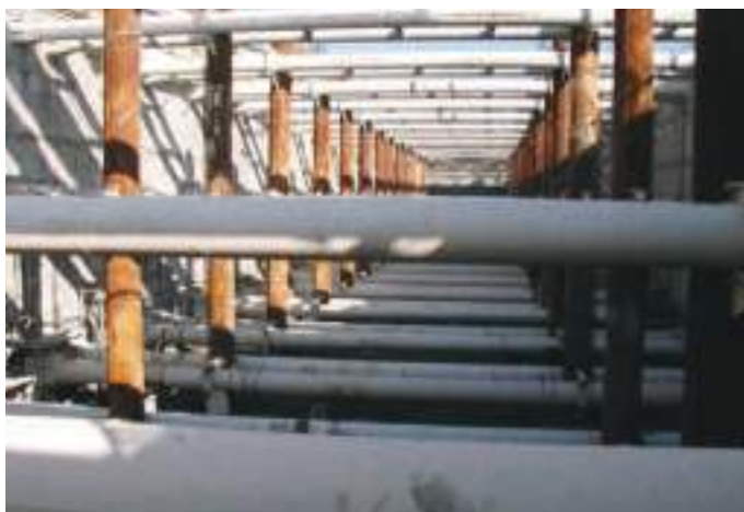
Fig. 04 Colocação de uma escora do 3º nível (à esquerda). Vista dos três primeiros níveis de escoramento da zona larga da Estação (à direita). Placement of a 3rd level prop (left). View of the three first levels of shoring in the wide zone of the Station (right).
