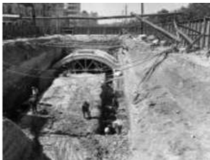
Sequência construtiva de escavação em vala estreita (arquivo de imagens do Metropolitano de Lisboa). Construction sequence of narrow trench excavation (Metropolitano de Lisboa Image Archive).
