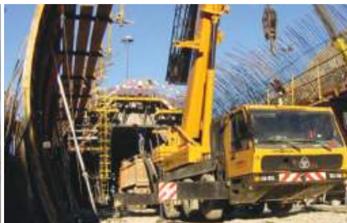
Túnel do Barracão - Trabalhos de desmorte na trincheira e de execução da secção de betão. Barracão Tunnel – Drilling works in the trench and execution of the concrete section.
