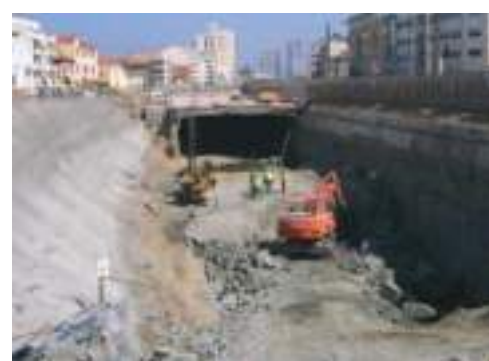
Fig. 05 Corte tipo da solução preconizada para a escavação a céu aberto e vista da zona escavada a céu aberto. Type section of the recommended solution for the open cut and view of the open cut area.
