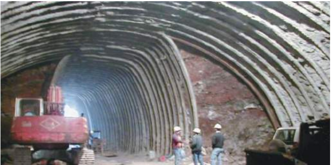
Vista do túnel piloto e do alargamento da meia secção superior. View of the pilot tunnel and of the widening of the upper half section.
