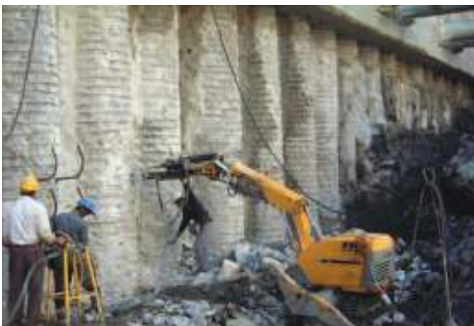
Fig. 05 Aspetos da execução da parede de forro. Aspects of the lining wall execution.
