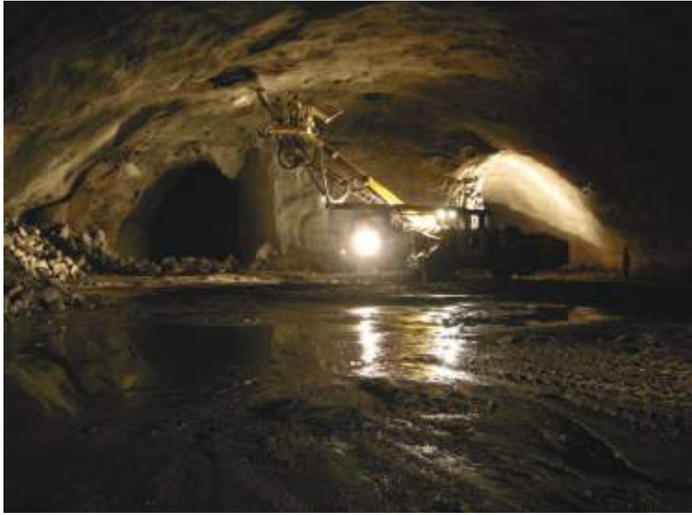
Fig. 04 Escavação da abóbada da caverna de Picote II. Excavation of the Picote II cavern vault.
