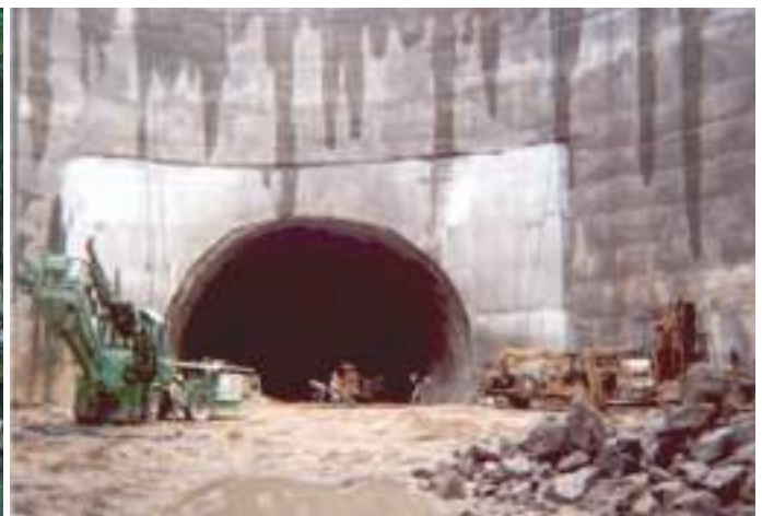
Vista geral do Poço e do quadro de reforço para emboquilhamento do túnel. General overview of the shaft and reinforcement framework for the tunnel portal.
