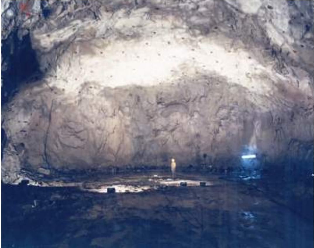
Fig. 07 Topo do poço da chaminé de equilíbrio. Fase de escavação. Top of the surge shaft. Excavation phase.
