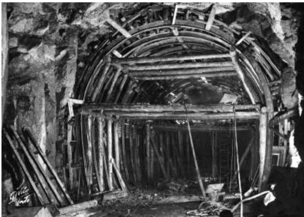
Túnel de restituição, secções revestidas a betão armado antecedido de perfilados metálicos. Tailrace tunnel, sections lined with reinforced concrete over steel ribs.
