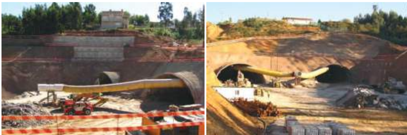
Espectro geral dos emboquilhamentos. Emboquilhamento Nascente à esquerda, com parede ancorada na proteção à habitação existente. Emboquilhamento Poente à direita.
