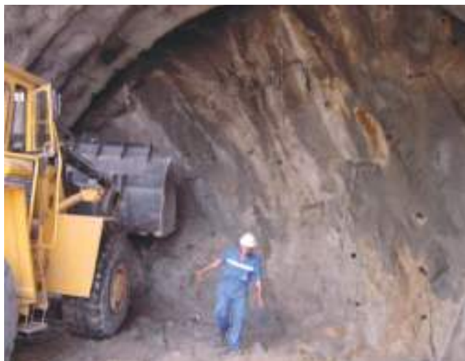
Fig. 02 Escavação da Fase 1 nos emboquilhamentos. Do lado Norte, em ZG4, à esquerda. À direita, no emboquilhamento Sul, em ZG3. Excavation of Stage 1 at portals. ZG4 at the Northern end (L.). ZG3 at Southern portal (R.).
