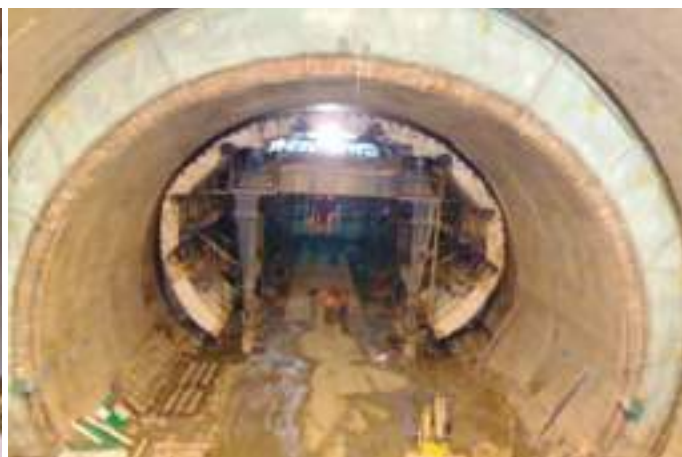
Fig. 04 Túnel do Corpo da Estação visto do Acesso Poente e revestimento secundário. Tunnel of the station: view from the western access and secondary lining.
