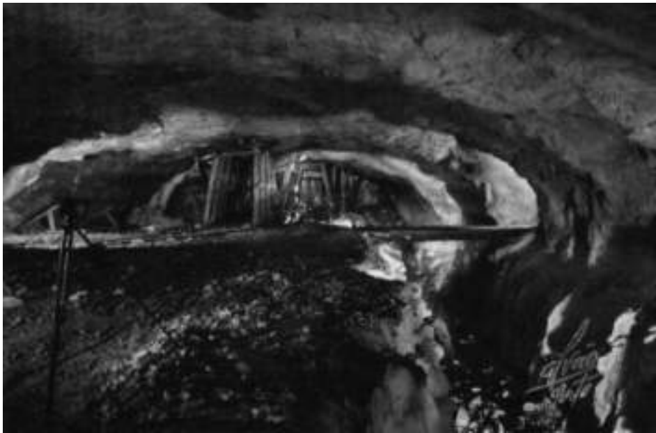
Fig. 03 Central I. Escavação da abóbada. Powerhouse I. Vault excavation.
