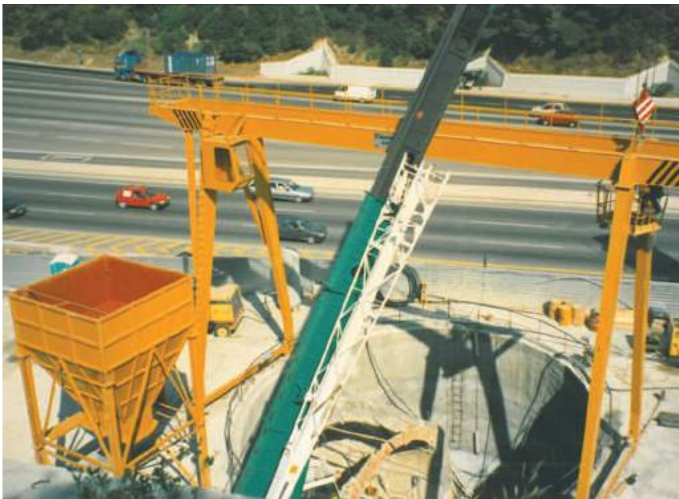
Fig. 04 Poço de ataque. Tunnel shaft.
