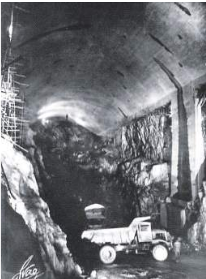
Faseamento construtivo da caverna da central dos grupos 1 a 3. Construction phases of the initial powerhouse cavern.
