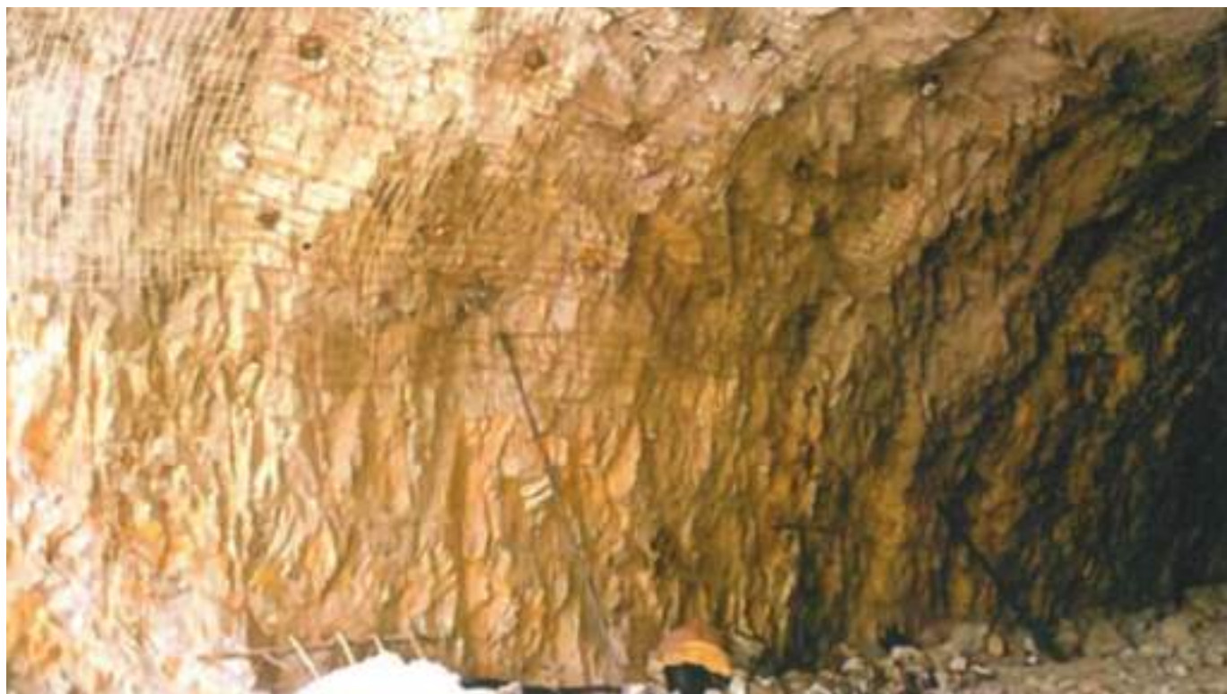
Maciço quartzítico de escavação e suporte primário. Excavation in quartzite rock mass and primary support.
