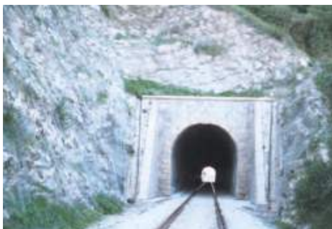
Fig. 08 Aspeto final da obra, com interior revestido com betão projetado e sinalização de segurança. Direita: emboquilhamento de entrada do túnel da Certã. Final appearance of the work, the inside lined with shotcrete and safety signs. Right: emboquilhamento de entrada do túnel da Certã.
