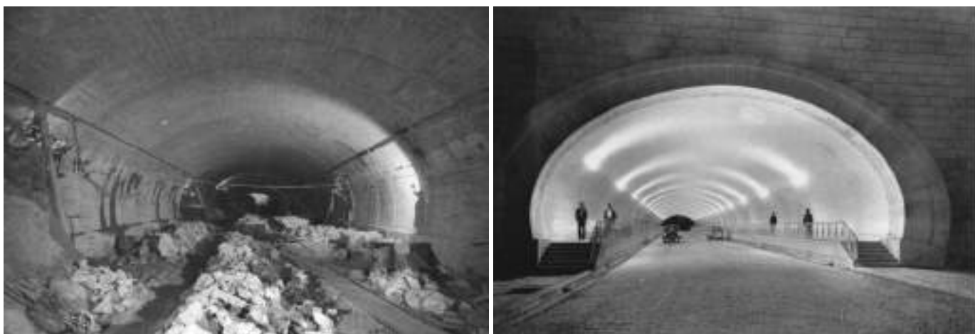
Fig. 10 Construção do revestimento definitivo (1949) e túnel terminado (1952). Construction of the final lining (1949) and tunnel open to the public (1952).
