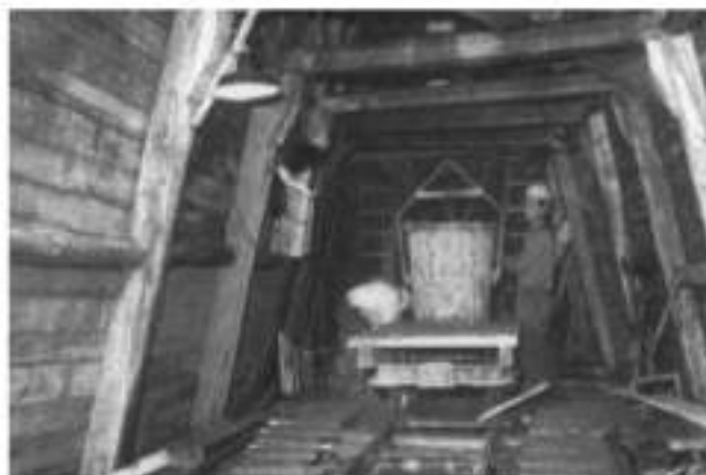
Método Belga – Sequência construtiva ( arquivo de imagens do Metropolitano de Lisboa). Belgian Method – Construction sequence (Metropolitano de Lisboa image archive).
