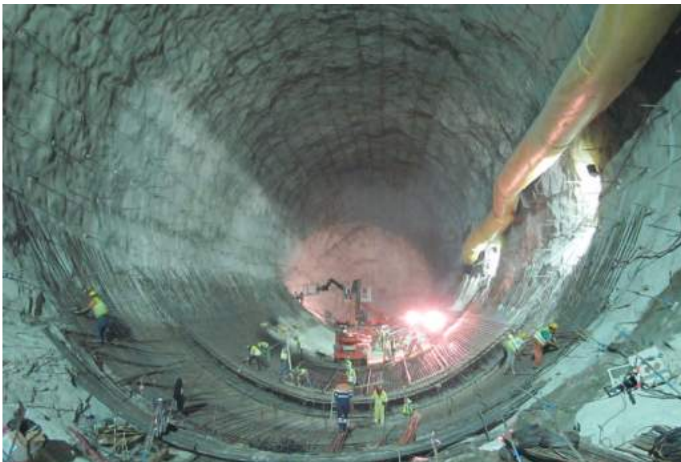
Fig. 09 Desarenador superior em construção. Upper sand trap in construction.
