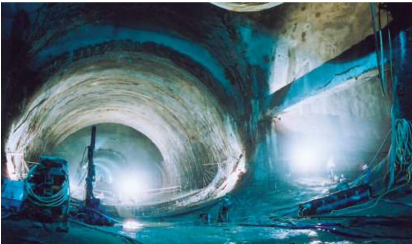
Fig. 04 Aspeto geral da zona de intersecção após conclusão da escavação. General view of the intersection area after excavation completion.
