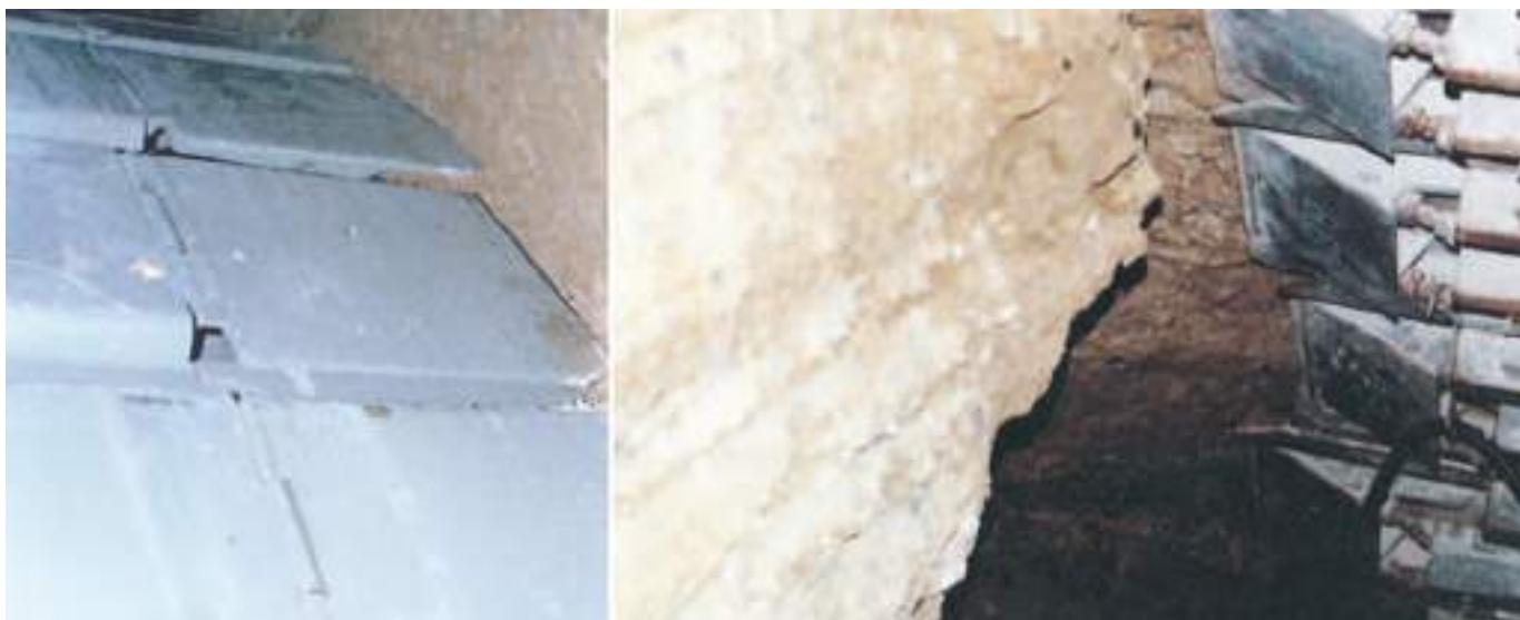
Fig. 08 Túnel de Calvanas – Extremidades dianteiras das lanças de entivação das abóbodas (arquivo de imagens do Metropolitano de Lisboa). Calvanas Tunnel – Front end of the vault shoring booms (Metropolitano de Lisboa image archive).
