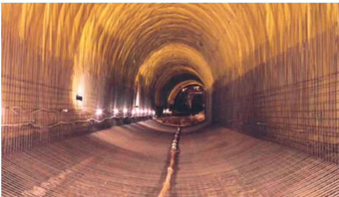
Fig. 10 Revestimento definitivo com soleira invertida em ZG4. Permanent support with invert arch in ZG4.
