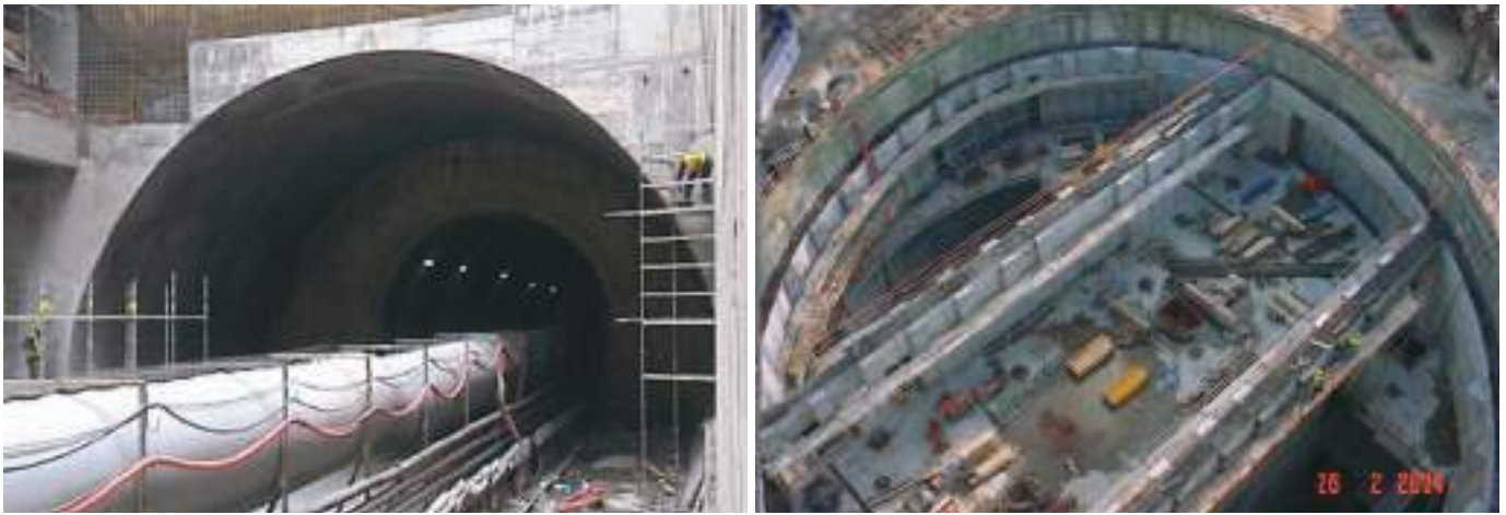
Vista do túnel com trabalho simultâneo da TBM e implantação das estruturas internas no poço. View of the tunnel with simultaneous TBM work and internal structure layout in the shaft.
