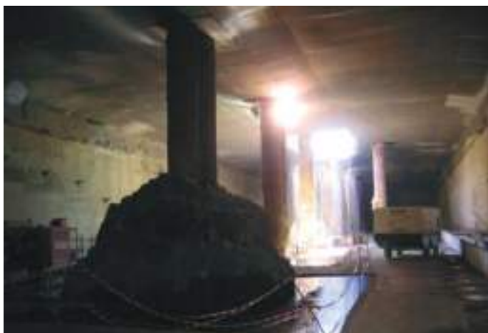
Fig. 04 Especto das estacas por recalçar e do respetivo recalce. Aspect of the piles to be regouted and respective regrouting.
