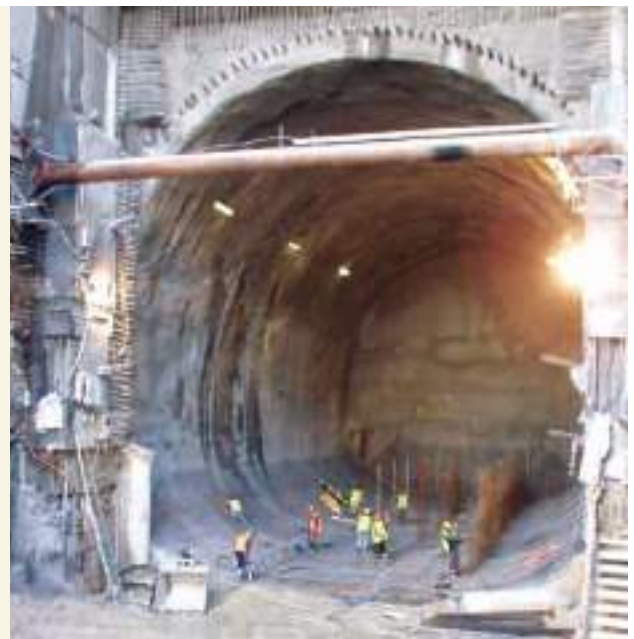
Fig. 05 Secção transversal tipo, faseamento executivo e vista geral do Túnel 1 na fase final de instalação do revestimento primário. Cross-section, construction phases and general view of Tunnel 1 at the final stage of the installation of the primary lining.
