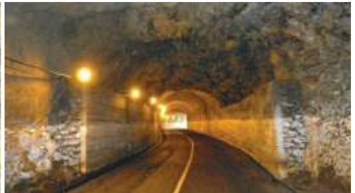
Revestimento parcial com pedra e betão Túnel II da via Fajã da Ovelha/Paúl do Mar, 1971 Partial lining with stone and concrete of Fajã da Ovelha/Paúl do Mar Tunnel II, 1971
