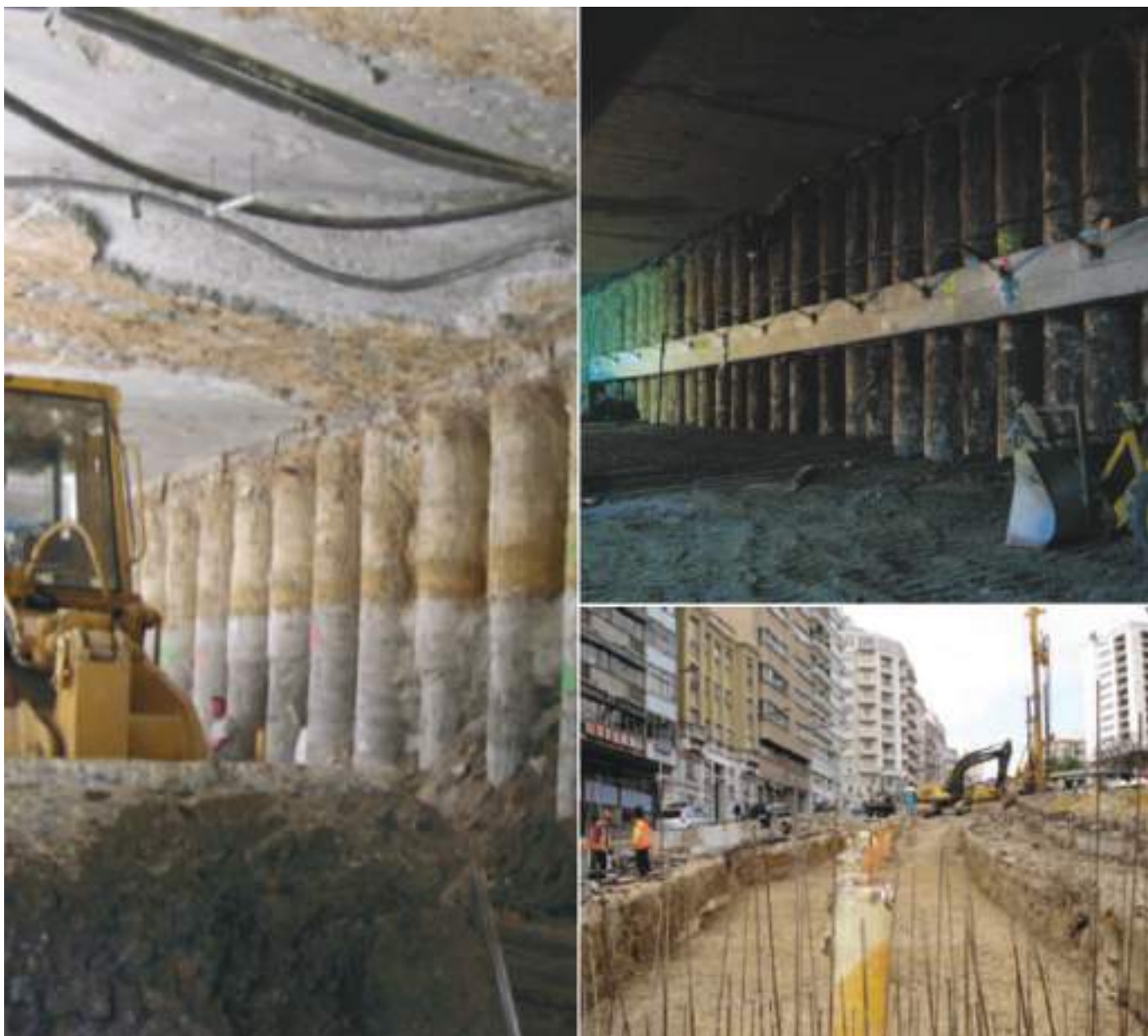
Fig. 06 Pormenores da cortina de estacas e dos trabalhos na Av. António Augusto Aguiar. Pile sheet wall and top slab, and excavation works at António Augusto Aguiar Avenue.
