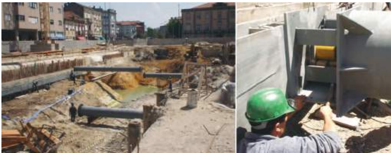
Fig. 04 Instalação das escoras e do macaco hidráulico para aplicação do pré esforço. Installing the props and the hydraulic jack to apply the pre-stressing load.
