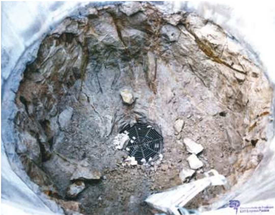
Fig. 08 Poço de adução. Fase de alargamento da secção, a partir da superfície, após abertura de furo piloto com “raise-boring”. Headrace shaft. Phase of widening the section, from the surface, after opening the pilot shaft with raise-boring.
