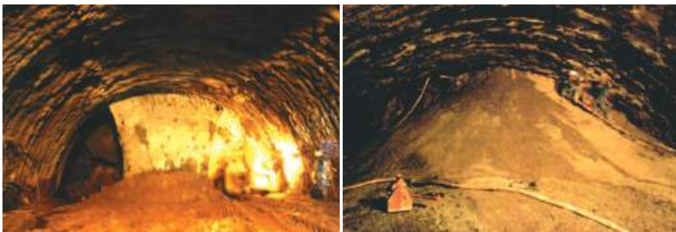
Fig. 03 Aspetos da escavação com side-drifts em ZG3. À direita tratamento da chaminé. Aspects of the excavation with side-drifts in ZG3 (L). On the right, treatment of the chimney.
