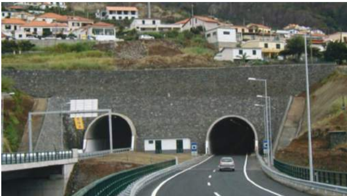
Fig. 06 Vista geral do emboquilhamento Oeste. General overview of the western portal.
