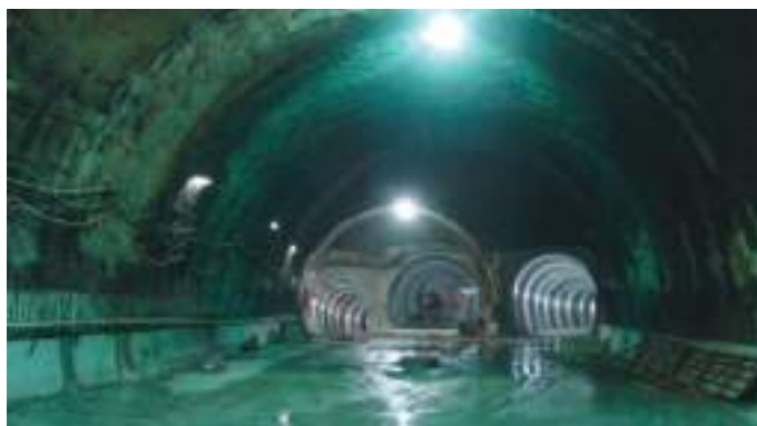
a) Câmara de alargamento – soleira executada a) Widening chamber – invert
