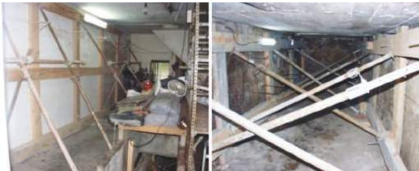
Travamento das paredes interiores e edifícios na rua do Bonjardim. Shoring up of internal and external walls and buildings on Rua do Bonjardim.
