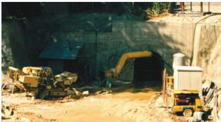
Fig. 07 Emboquilhamento na zona do Estoril. Portal in urban environment (Estoril).
