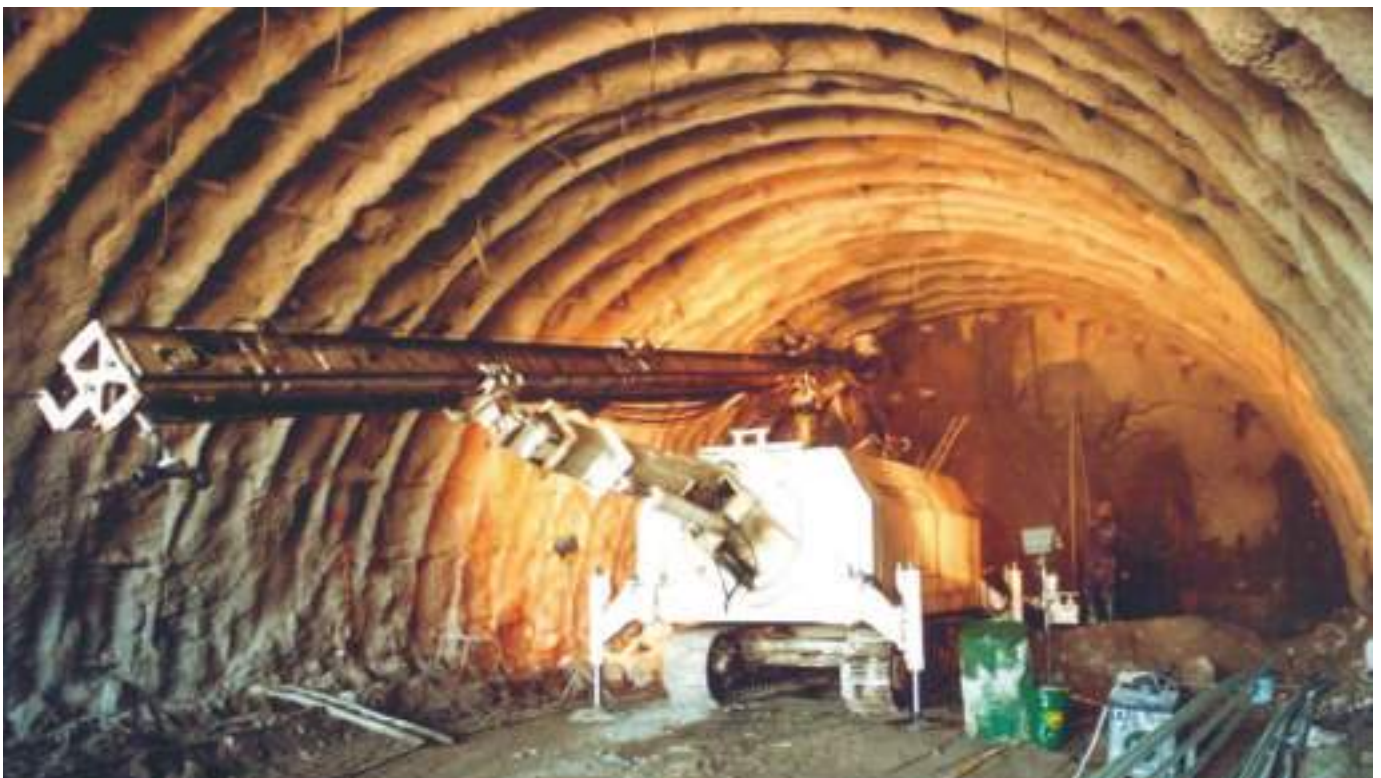
Fig. 02 Execução de microestacas sub-horizontais. Execution of sub-horizontal micropiles.
