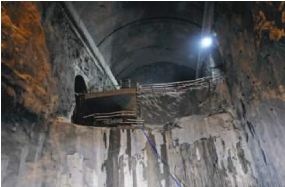
Fig. 05 Escavação do núcleo da caverna, após betonagem da abóbada. Excavation of the main cavern after construction of the vault concrete lining.
