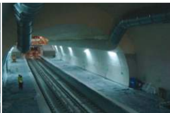
Fig. 04 Túnel do Corpo da Estação visto do Acesso Poente e revestimento secundário. Tunnel of the station: view from the western access and secondary lining.
