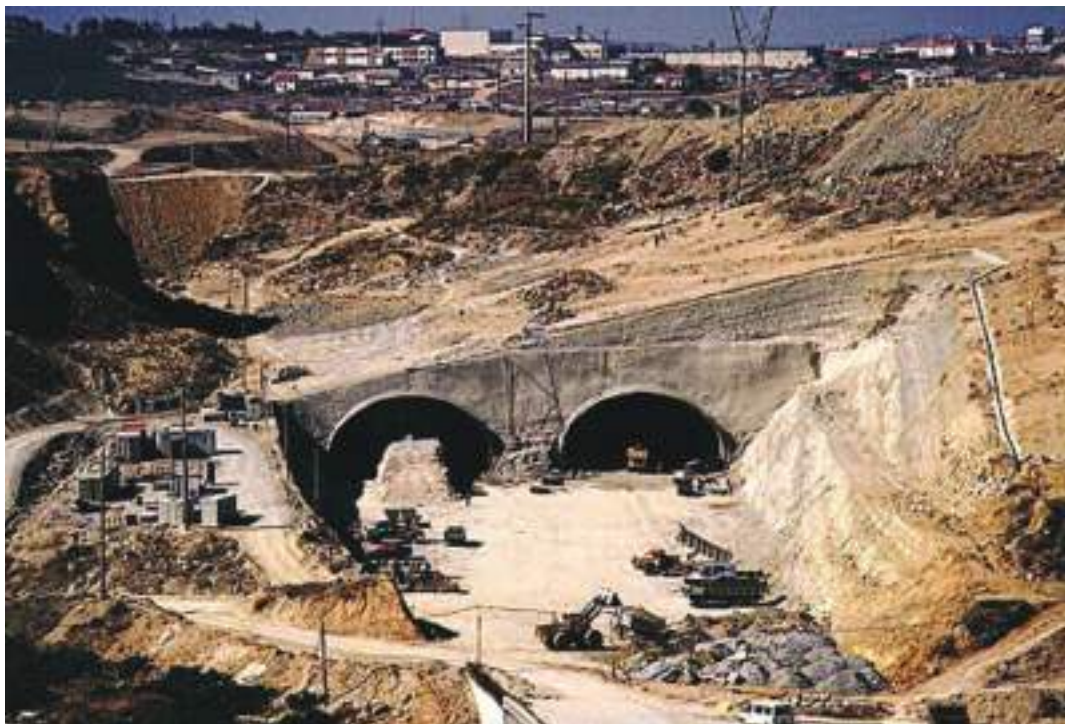
Fig. 04 Vista geral do Portal Oriental do Túnel em fases diferentes. De notar o escasso recobrimento (2 m). Eastern Portal, in different execution phases. Note the small overburden (2m).
