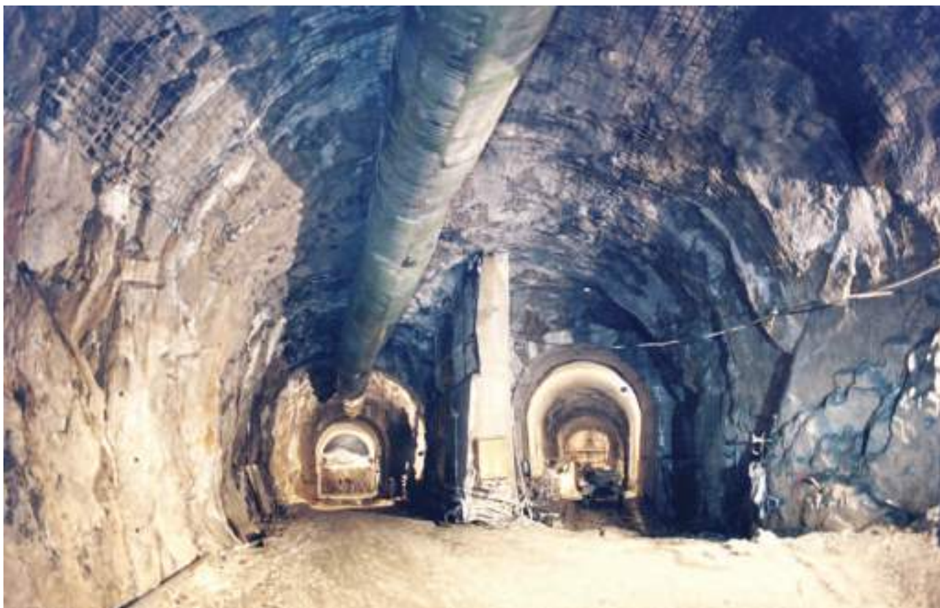
Fig. 10 “By-pass” do túnel de ataque ao túnel de restituição. Tailrace tunnel and ancillary construction tunnel "by-pass".
