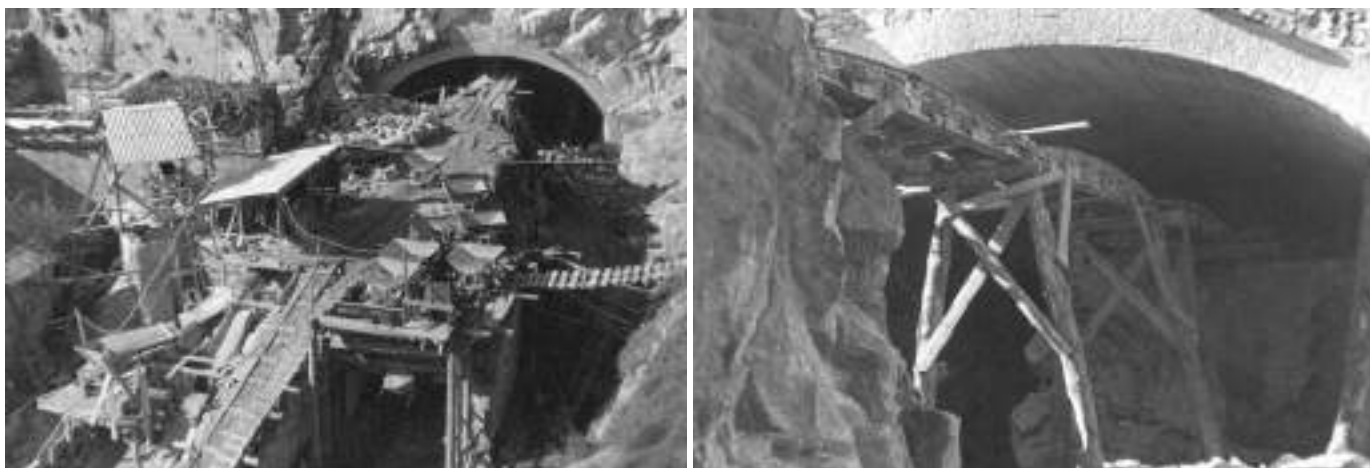
Fig. 09 Construção emboquilhamento Este, 1949. Construction of the East portal, 1949.
