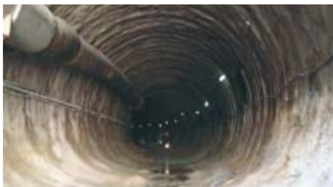
b) PV190 – Escavação; Túnel de via – revestimento primário b) PV 190 – Excavation; Track tunnel – primary lining
