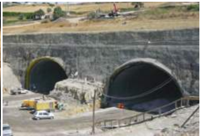
Fig. 05 Faseamento executivo da meia secção superior e vista geral do emboquilhamento sul. Upper half cross-section execution sequence and overview of the southern portal.
