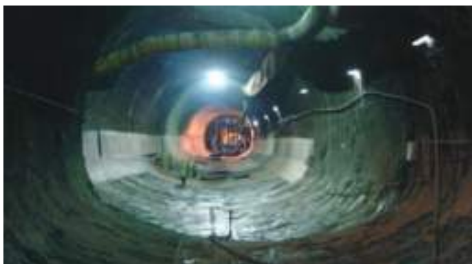
a) Câmara de alargamento – soleira executada a) Widening chamber – invert
