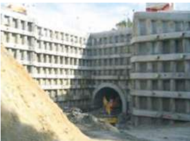
Fig. 07 Contenção periférica junto ao PV193. Peripheral support near PV193.
