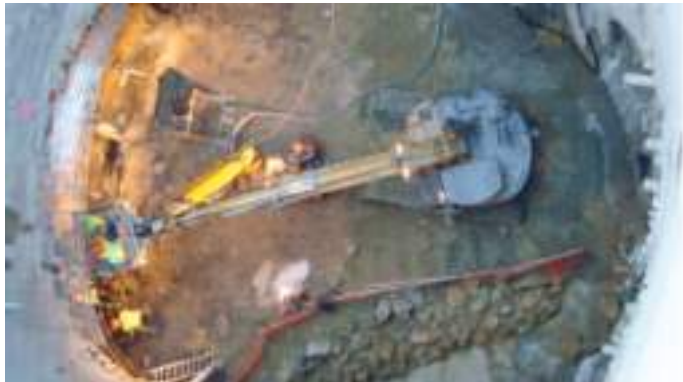
a) Poço Tejo – Escavação - Ataque do Troço 97 e NATM sob Canal Tejo a) Tagus Shaft - Excavation - stretch 97 opening and NATM under Tagus Canal
