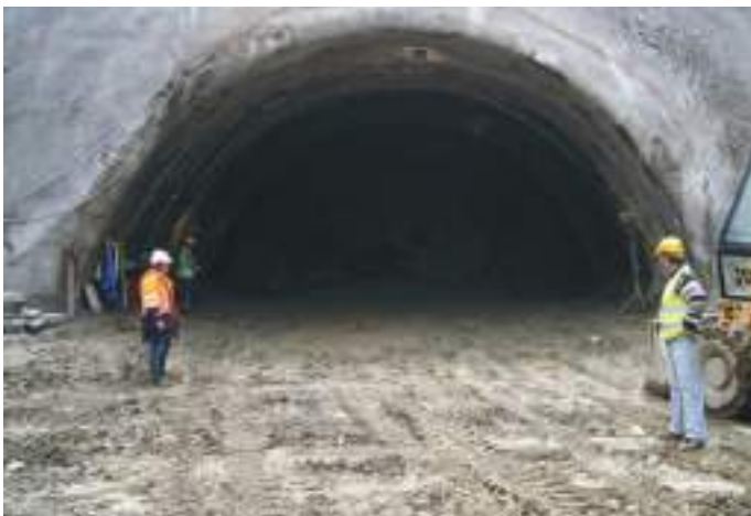
Aspetos da escavação da meia secção superior e da meia secção inferior. Aspects of the excavation of the upper and lower half sections.
