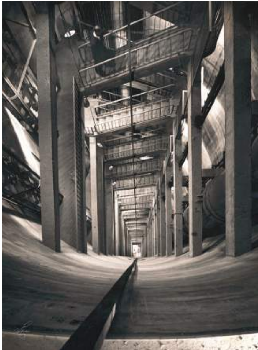
Fig. 09 Poço de acesso concluído. Completed access shaft.
