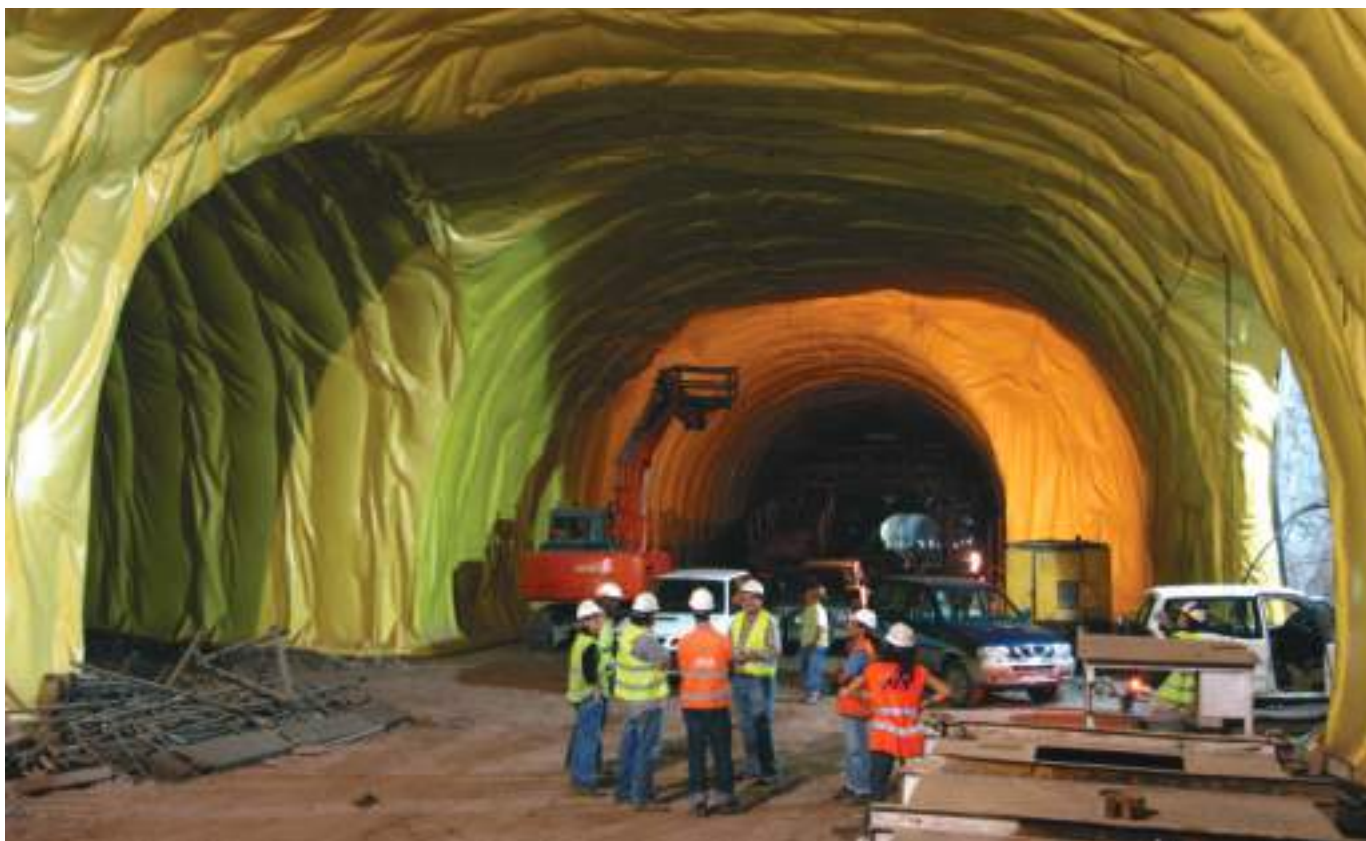
Sistema de impermeabilização. Waterproofing geomembranes.
