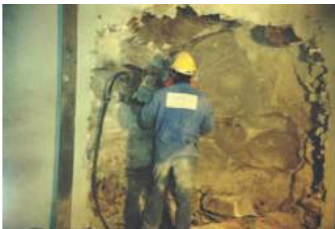
Fig. 07 Nichos, abertura e colocação de armaduras. Hideouts, opening and placing reinforcements.
