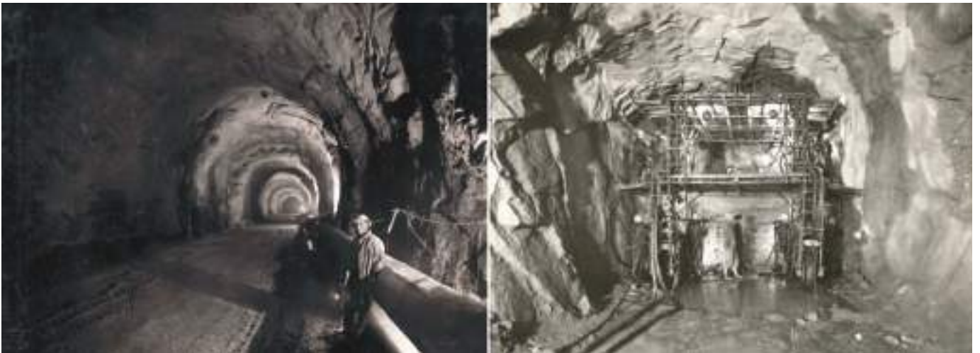
Fig. 11 Túnel de restituição, secção corrente. Tailrace tunnel, current section.
