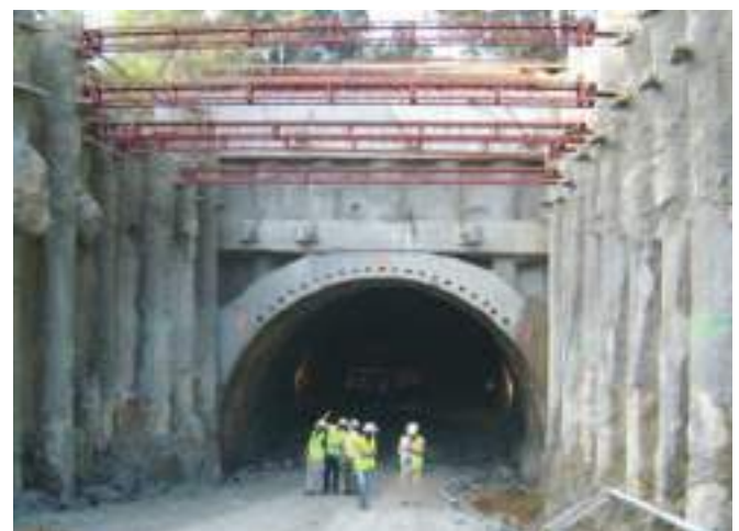
Fig. 08 Escavação junto ao Emboquilhamento Poente. Excavation near western portal.
