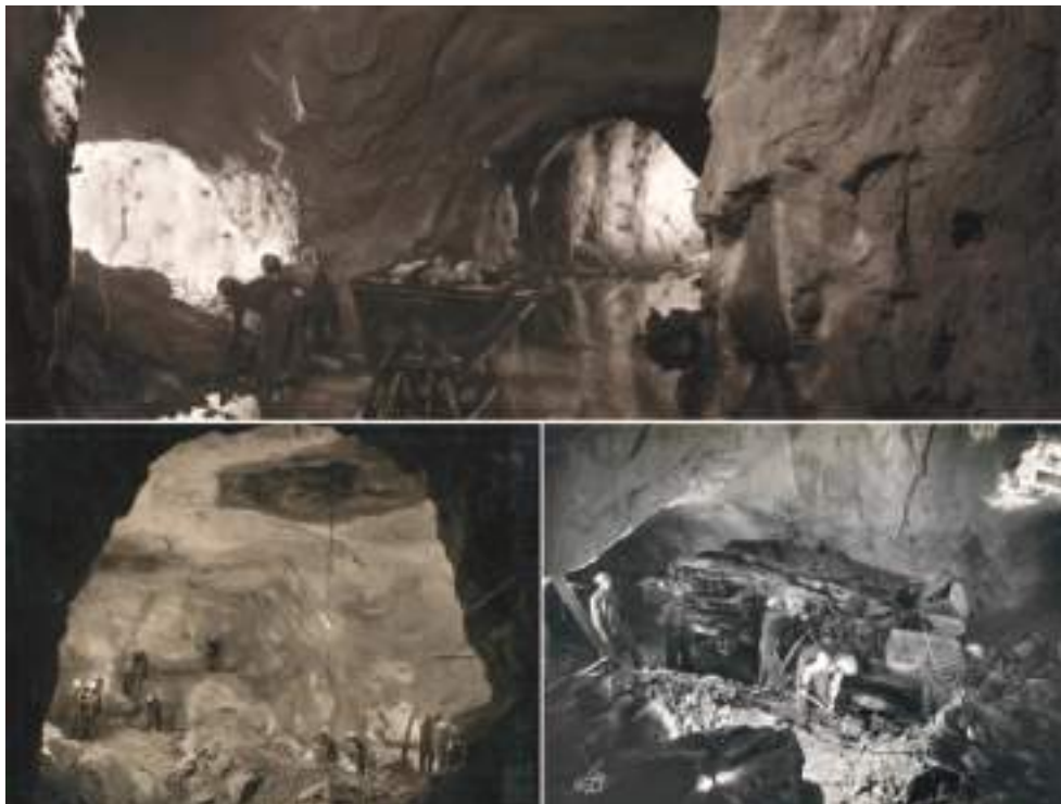
Faseamento de escavação da caverna da central. Excavation phases of the powerhouse cavern.
