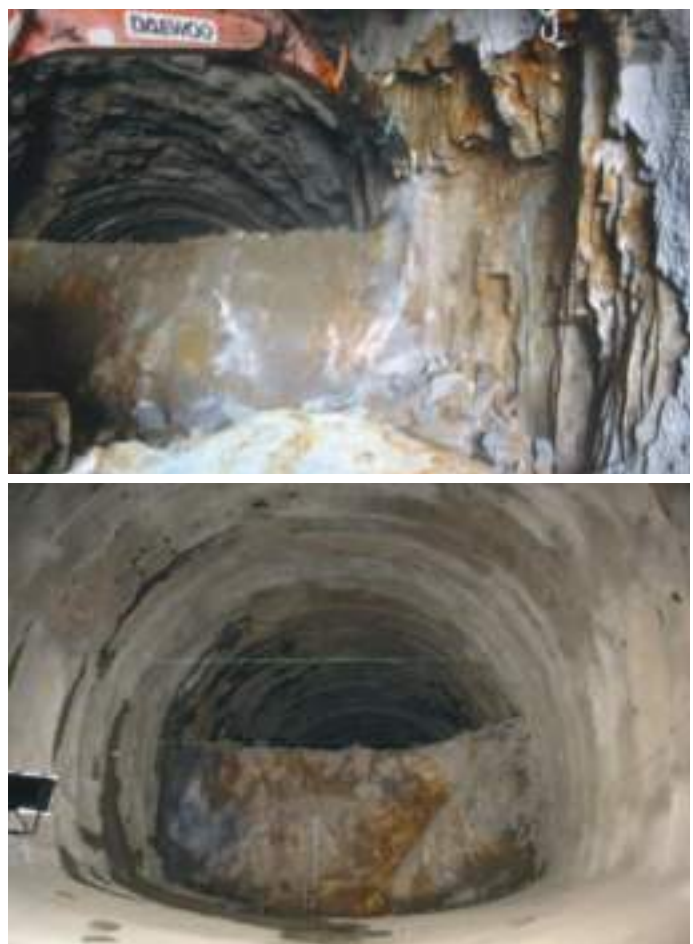
Fig. 05 Faseamento de escavação em maciço/secção Tipo III (em cima) e tipo IV e V (em baixo). Excavation phases in the ground/section Type III (above) and type IV and V (below).
