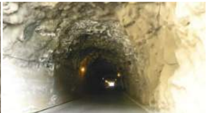
Revestimento com betão projetado, Túnel Ponta do Sol I, 1965 Shotcrete lining, Ponta do Sol I Tunnel I, 1965
