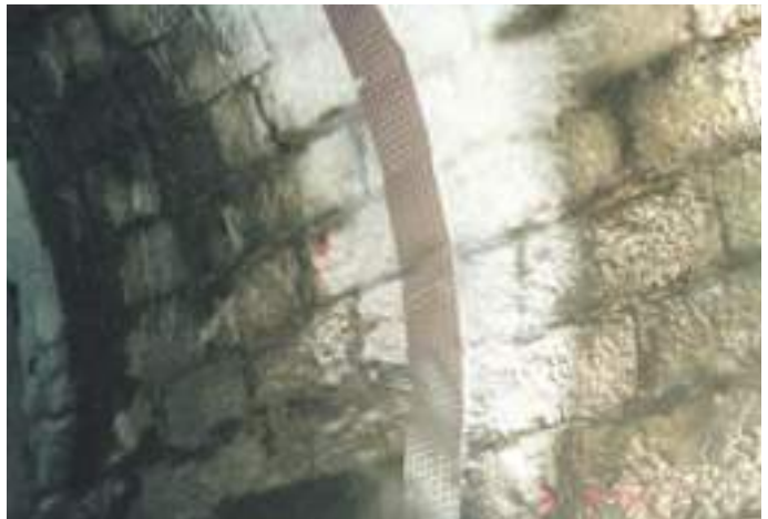
Drenagem, aspetos da colocação de drenos planos no contorno da estrutura. Drainage, aspects of setting up flat drains on the walls of the structure.
