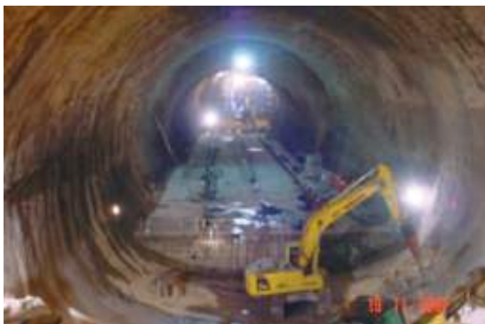
Fig. 04 Túnel do Corpo da Estação visto do Acesso Poente e revestimento secundário. Tunnel of the station: view from the western access and secondary lining.
