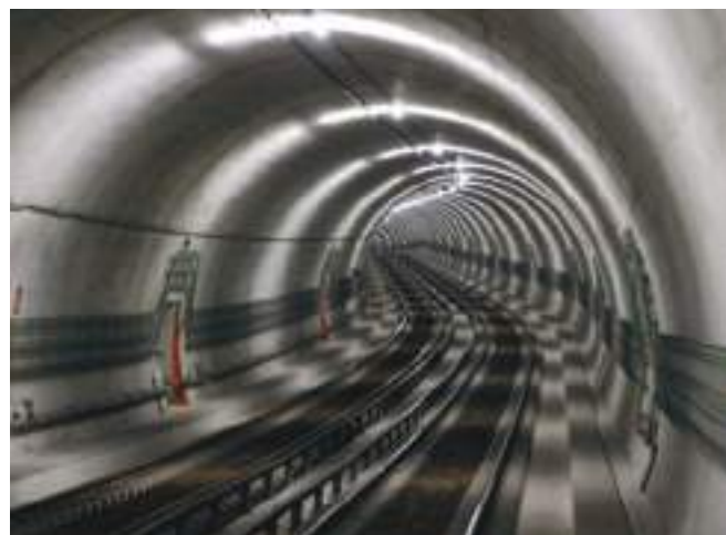
Fig. 17 Em exploração desde Julho de 2012. Tunnel open to the public since July 2012.
