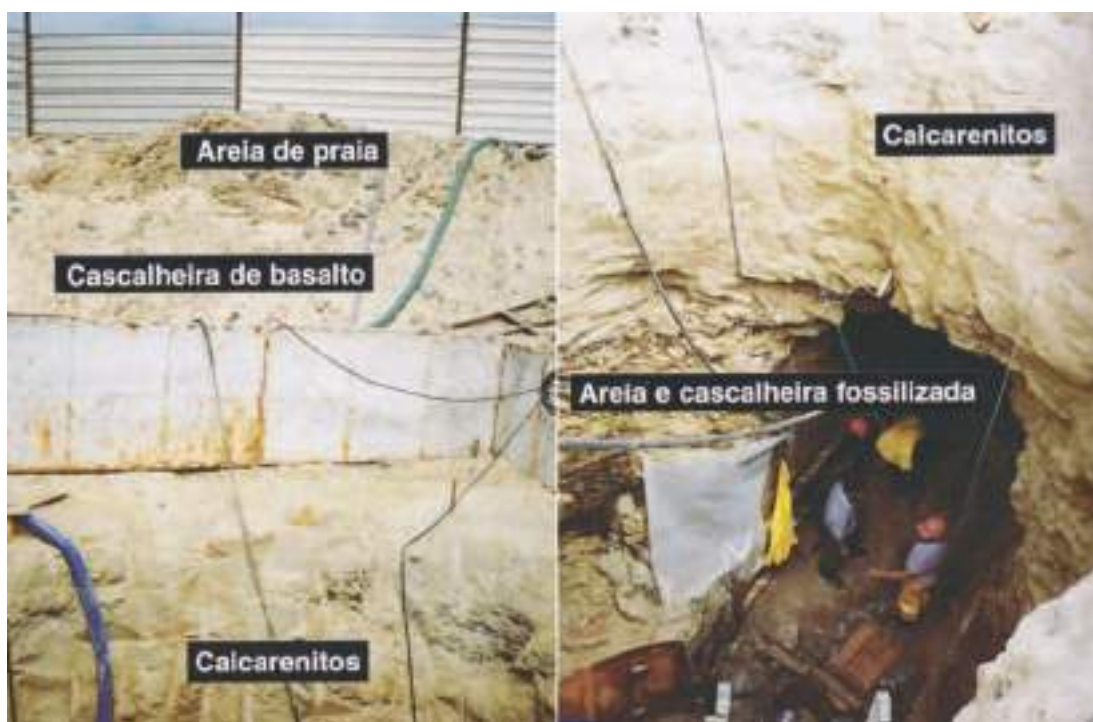
Fig. 09 Aspetto do poço e do emboquilhamento da galeria de captação principal. Aspect of the main water gallery well and portal.
