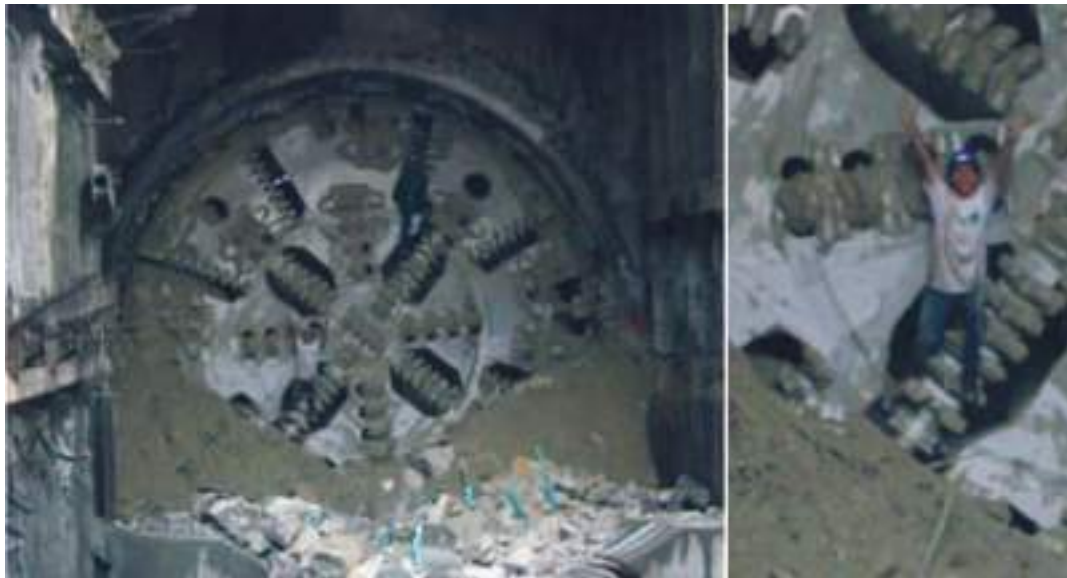
Fig. 05 Saída da TBM na Trindade em 21-10-2002. Machine emerging at Trindade station, October 21st 2002.
