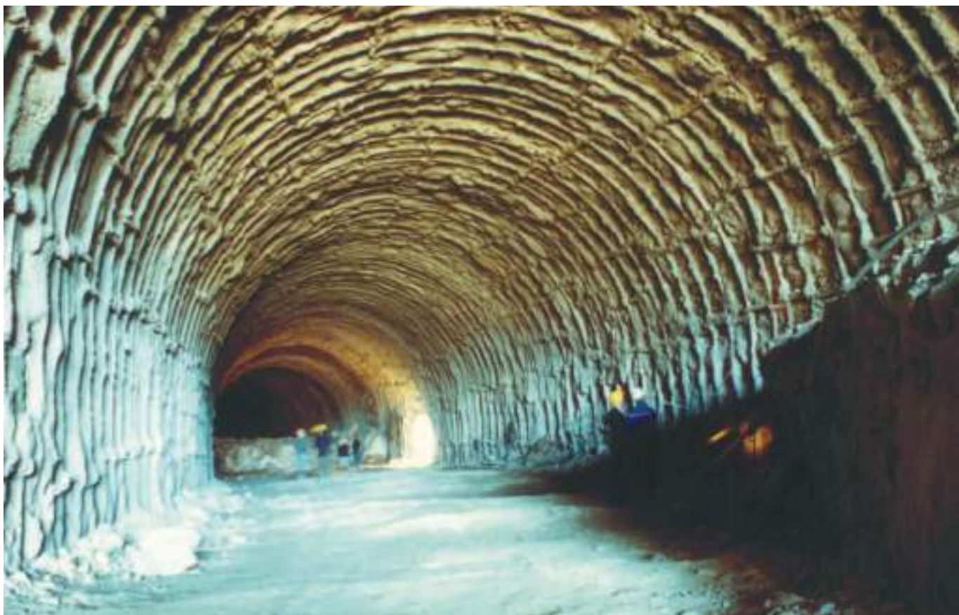
Aspetto das escavações durante a execução da destroça. Excavation and primary support.
