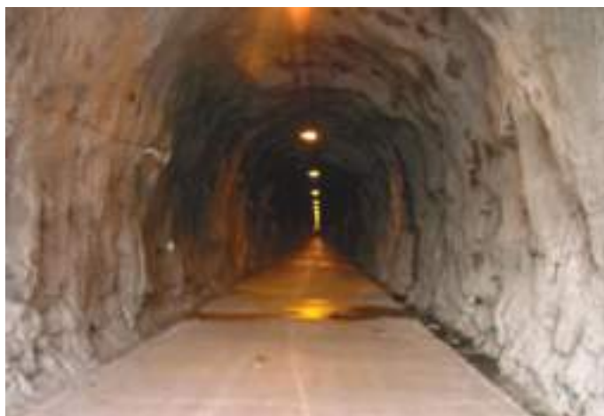
Fig. 04 Aspeto dos revestimentos primários da secção de alargamento e da galeria pedonal de emergência. View of primary supports in wide section and emergency pedestrian gallery.
