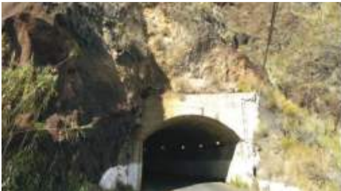
Revestimento da secção total do Túnel II da via Fajã da Ovelha/Paúl do Mar, 1971 Lining of total section of Fajã da Ovelha/Paúl do Mar Tunnel II, 1971
