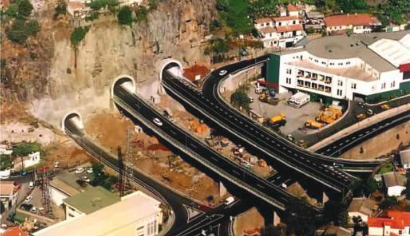
Fig. 07 Nó no vale da ribeira de Santa Luzia observando-se os emboquilhamentos Este do túnel João Abel de Freitas e do túnel do ramo de saída sul. Vale da ribeira de Santa Luzia interchanger. Portals of João Abel de Freitas tunnel and south exit tunnel.
