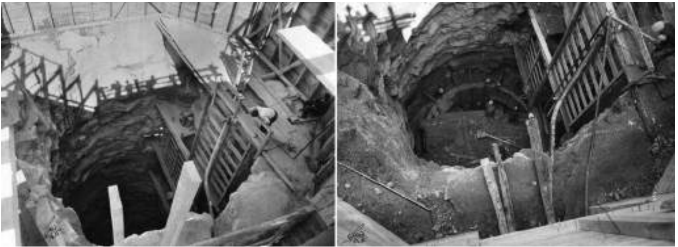
Fig. 08 Boca do poço de acesso. Access shaft entrance.
