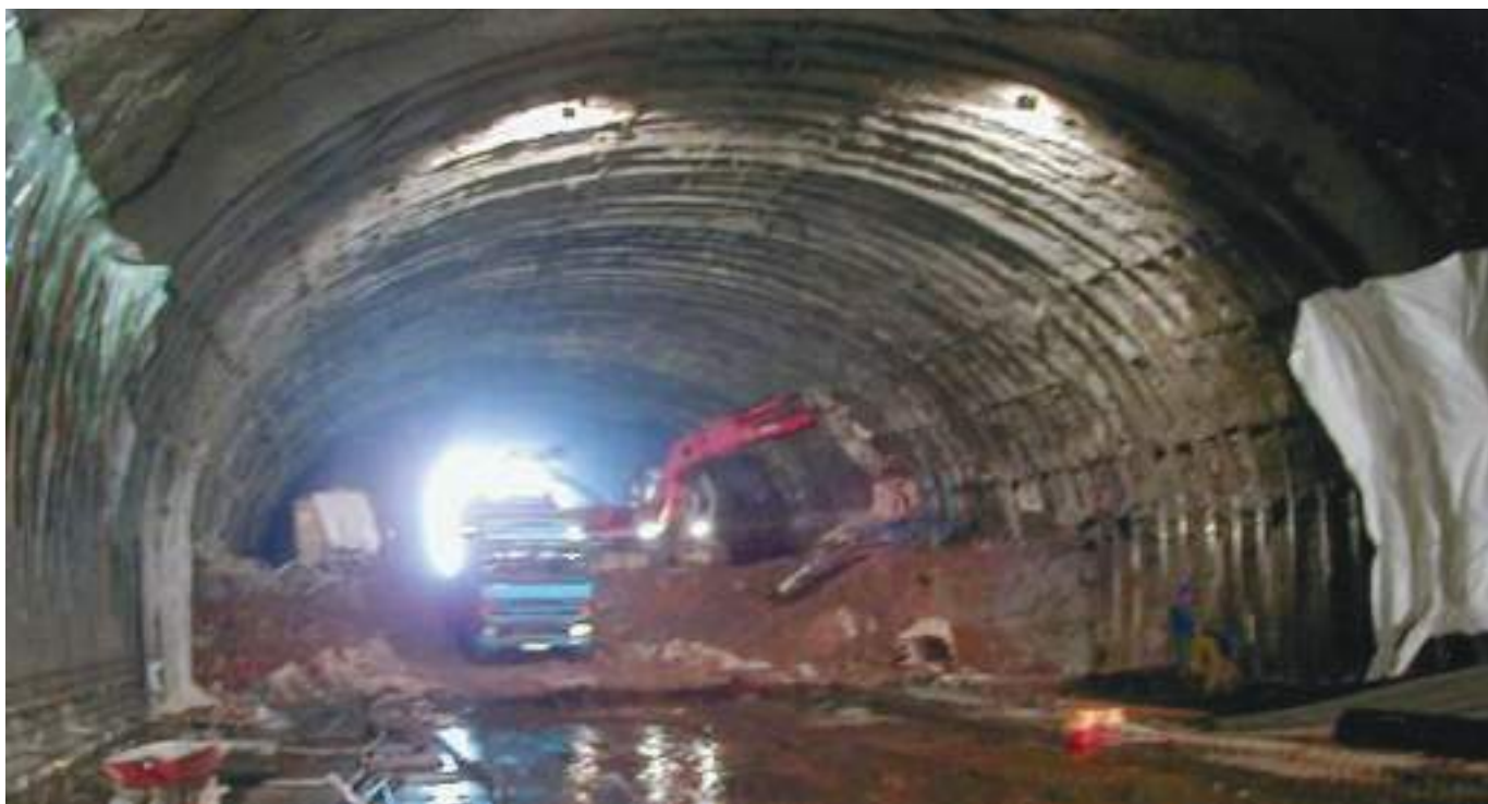
Vista da execução do rebaixo. View of the bench excavation.
