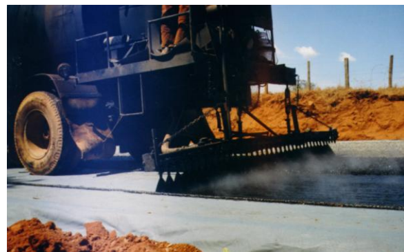
Geossintéticos na construção do pavimento (*)
