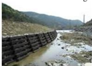
Construção de canal com blocos de Polietileno (PE)
