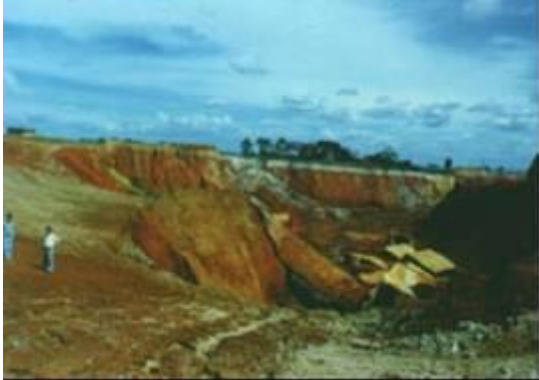
Danos causados por erosão
