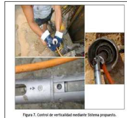
Figura 7. Control de verticalidad mediante Sistema propuesto.
