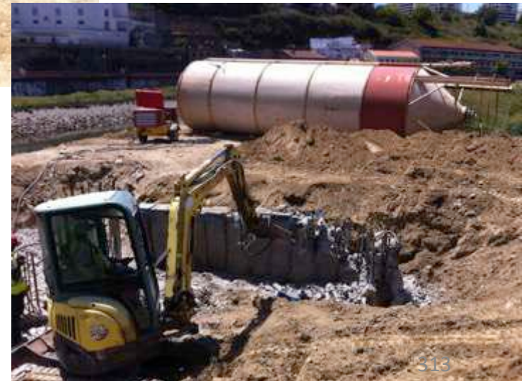
Descabeçamento das estacas
