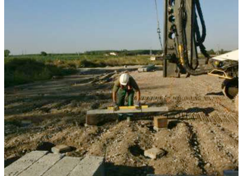
Verificação da cota final das estacas
