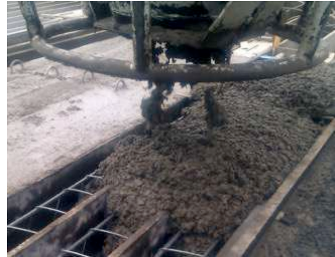
Betonagem nos moldes de cofragem
