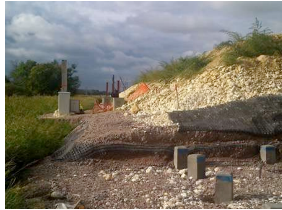
Centrais de armazenamento de dados e pormenor das geomalhas
