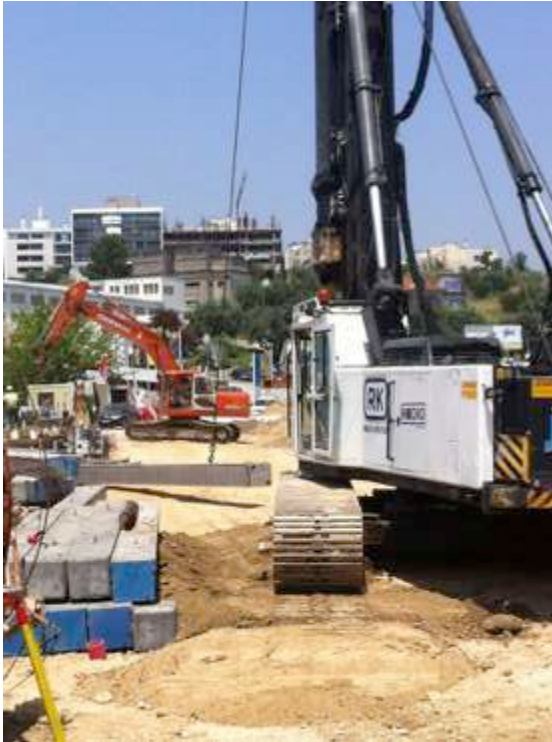
Transporte e elevação das estacas
