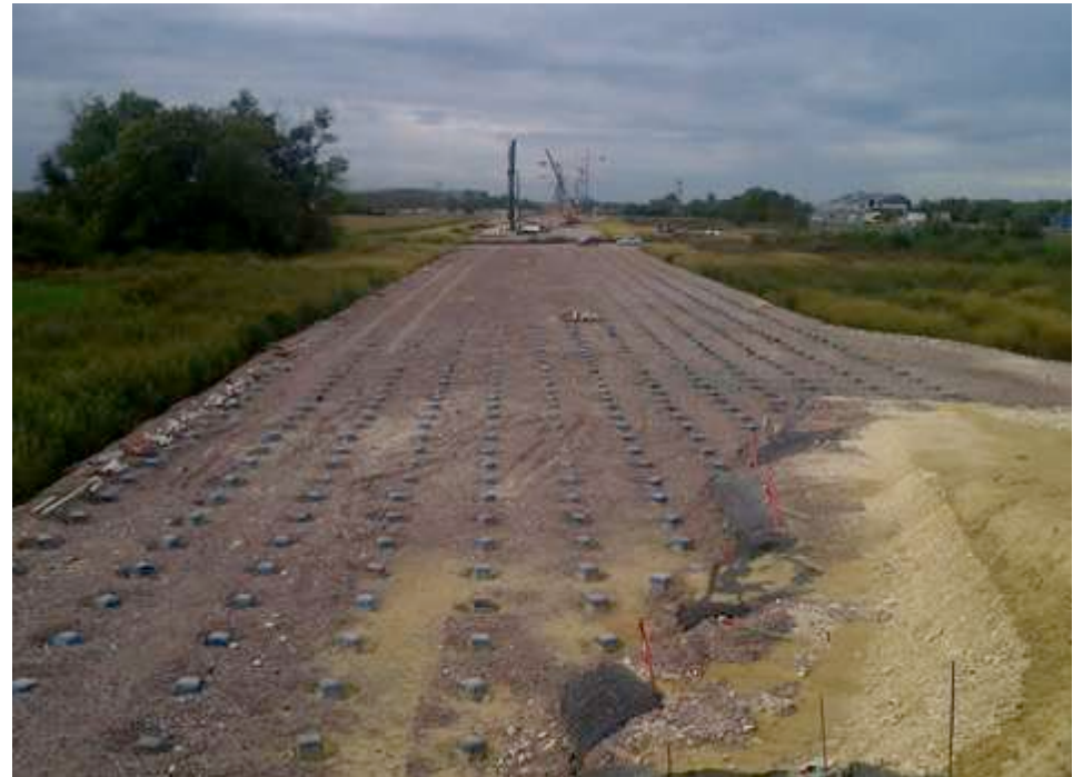
Malha de estacas do aterro experimental
