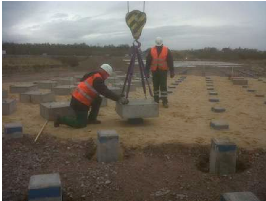
Colocação de capitéis
