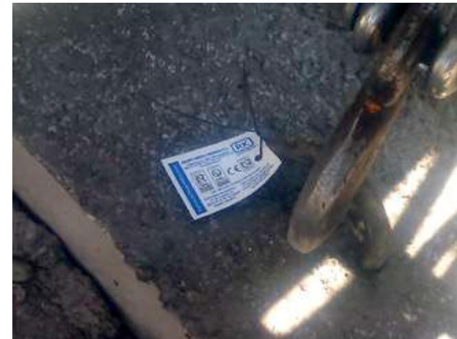
Etiqueta de identificação da estaca
