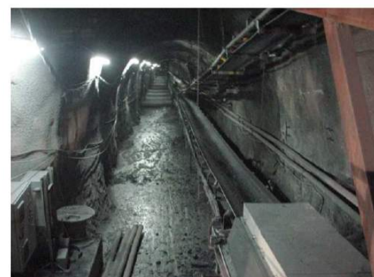
Vista da cauda da tuneladora
