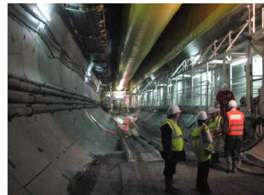
Túnel auxiliar de evacuação de escombros
